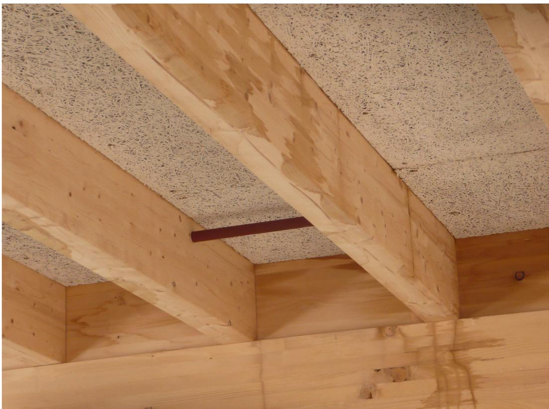
Wasserschäden an der Dachkonstruktion OG 1
