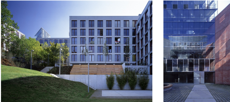
Abbildung 6+7: Sanierungsprojekt BURSE; Passivhausniveau mit Einsatz von Lüftungsanlagen.
