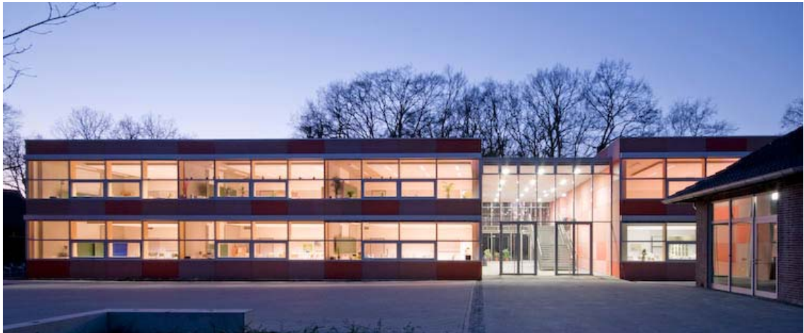
Abbildung 10: Erweiterung Schulzentrum Mitte, Nordhorn
