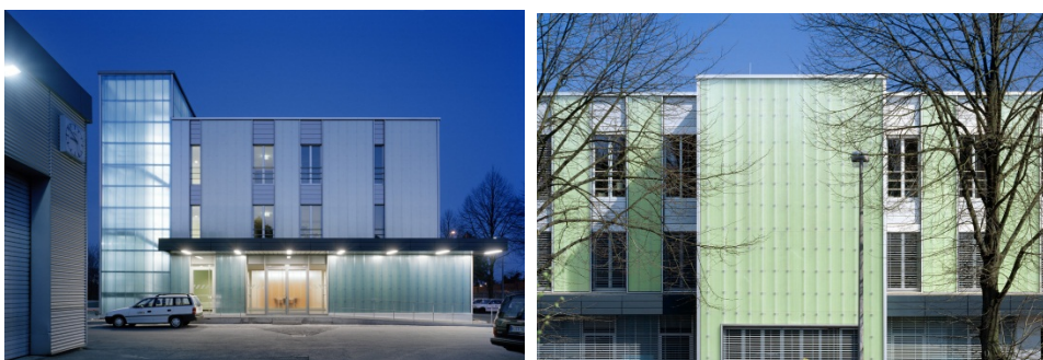
Abbildung 8+ 9: Remscheider Entsorgungsbetriebe, DBU Förderprojekt
