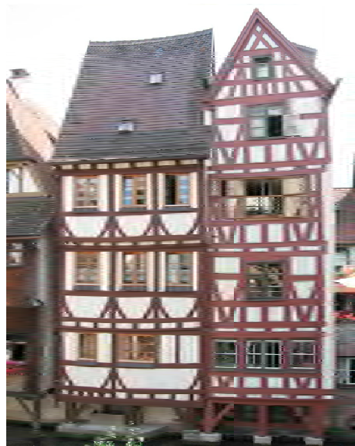
Fachwerkbau, Fischerviertel, Ulm, ca. 15. Jahrhundert (Quelle: Mediatum, Fachgebiet Holzbau)
