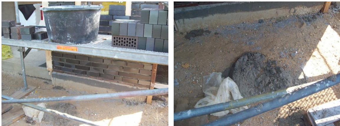
Abbildung 27: Fassadenarbeiten Baustelle G [Fotos: B. Marx]
