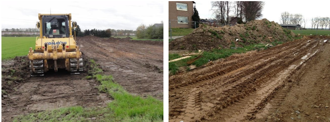
Abbildung 38: Erdarbeiten und Bodenmiete Baustelle E [Fotos: B. Marx]
