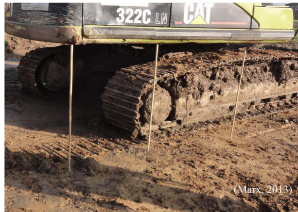
Abbildung 6: Oberbodenabtrag Baustelle E [Foto: B. Marx]
