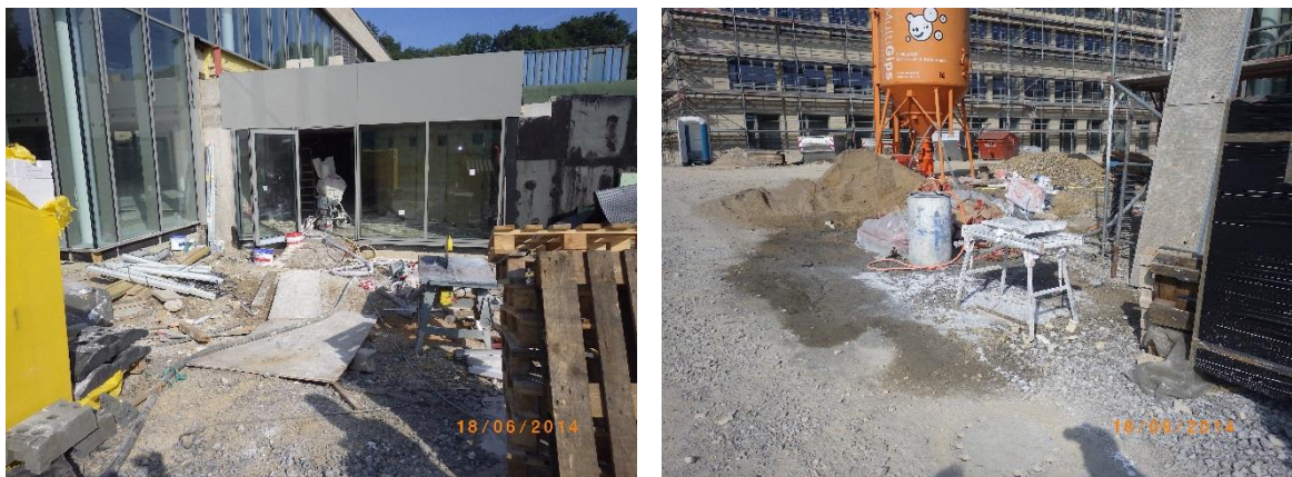
Abbildung 13: Ausbauarbeiten Baustelle R [Fotos: B. Marx]
