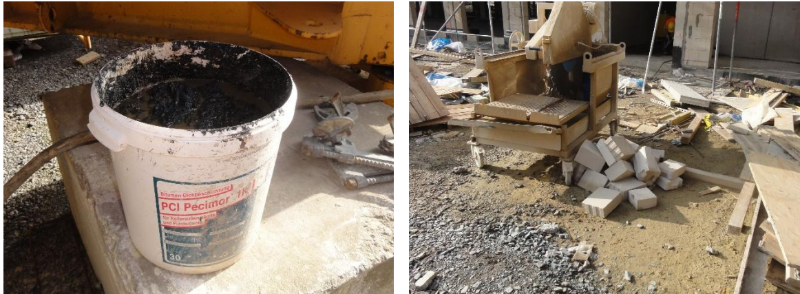
Abbildung 12: Rohbauarbeiten Baustelle R [Fotos: B. Marx]
