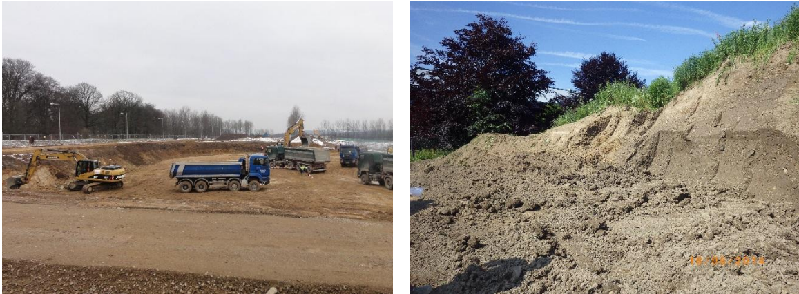
Abbildung 11: Erdarbeiten und Bodenmiete Baustelle R [Fotos: B. Marx]
