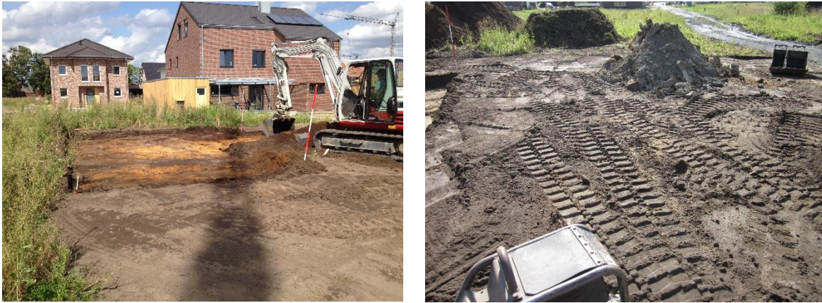
Abbildung 61: Erdarbeiten Baustelle L [Fotos: A. Randel]
