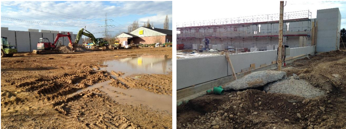
Abbildung 39: Rohbauarbeiten Baustelle E [Fotos: B. Marx]
