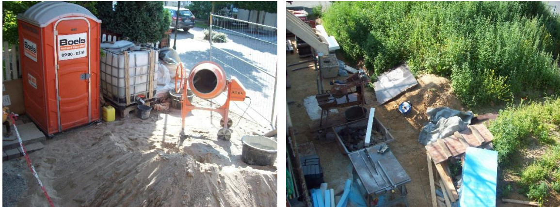
Abbildung 26: Baustelleneinrichtung Baustelle G [Fotos: B. Marx]
