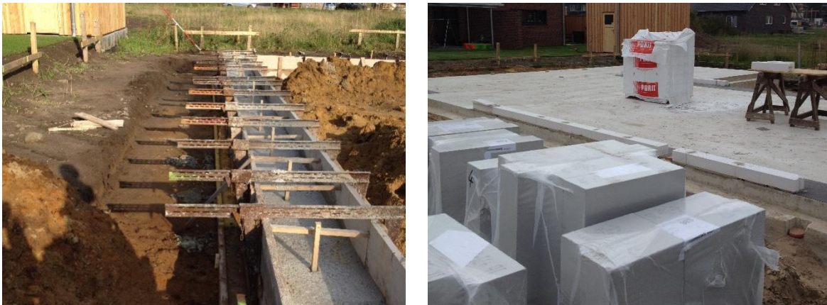
Abbildung 62: Streifenfundamente und Rohbauarbeiten Baustelle L [Fotos: A. Randel]
