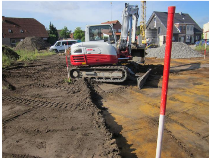
Abbildung 8: Entfernung der Krautschicht Baustelle L [Foto: A. Randel]
