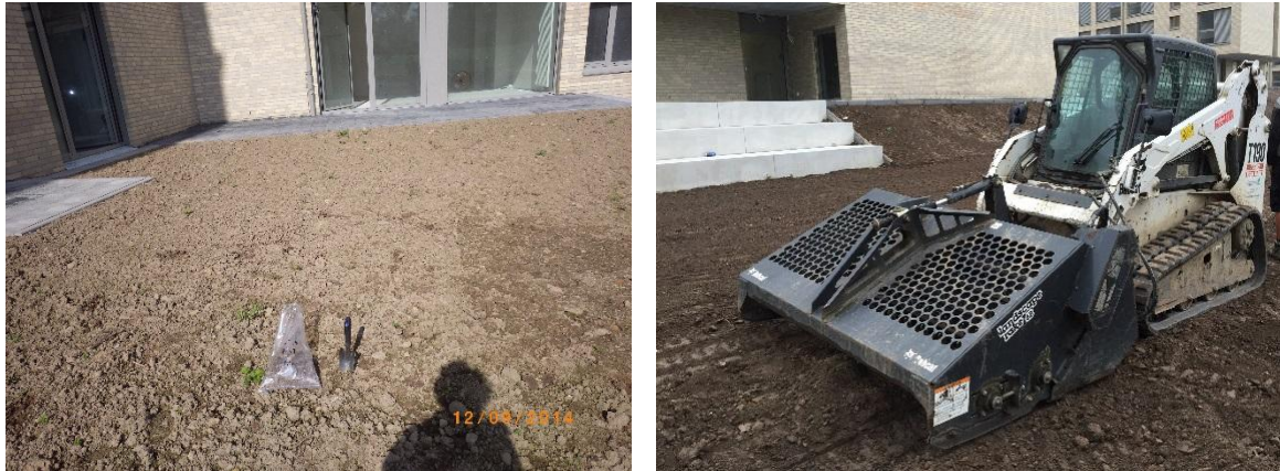
Abbildung 14: Außenanlagen Baustelle R [Fotos: B. Marx]
