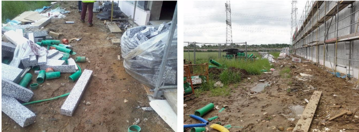
Abbildung 40: Fassaden- und Ausbauarbeiten Baustelle E [Fotos: B. Marx]
