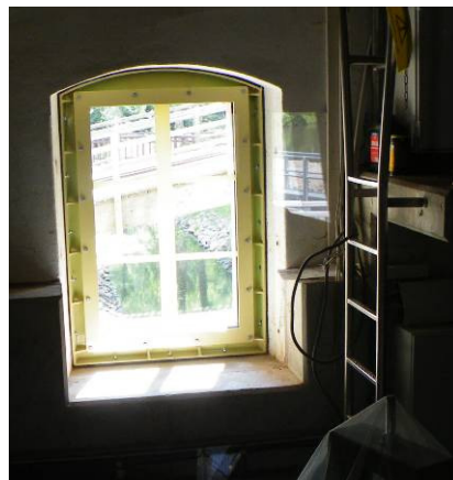
Foto 21 Außenfenster zur Turbine 24.05.2012
