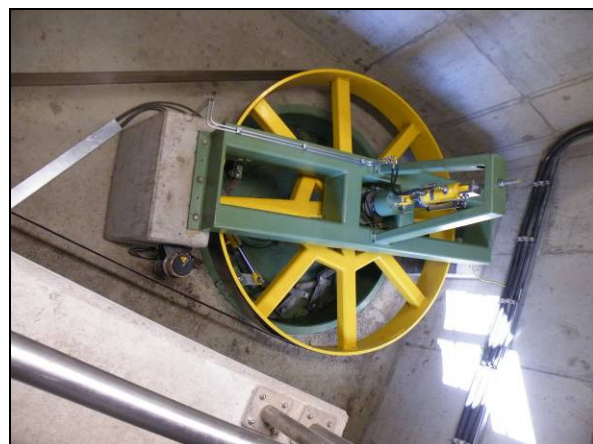
Foto 12 Turbine nach der Hochwasserschadensbeseitigung
