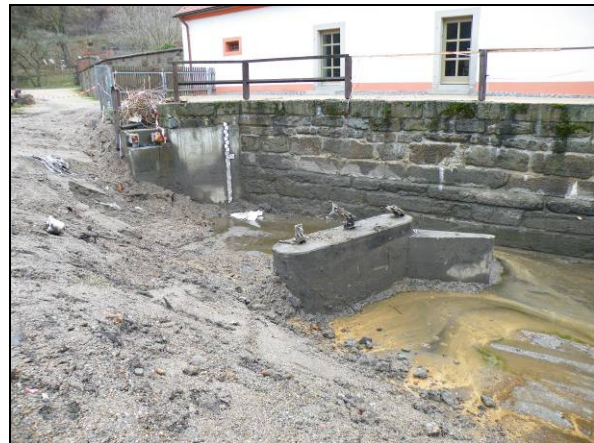
Foto 2 Oberwasserseitiger Fangedamm, demontierter Bediensteg, 18.01.2012
