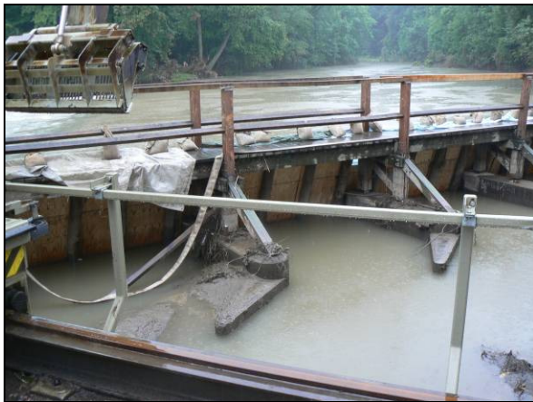
Foto 1 Mühlgraben mit provisorischer Abdichtung (Folien, Verschalung), 24.08.2010
