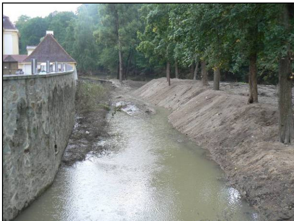
Foto 3 Mühlgraben und Neißeinsel vor der Hochwasserschadensbeseitigung, 24.08.2010
