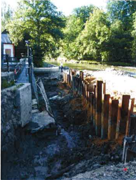
Foto 7 Baugrubenabdichtung mit Spundwand 24.07.2013
