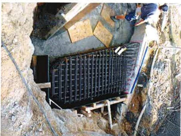
Foto 13 Bewehrung Stütze 2 an der FAA 22.08.2013
