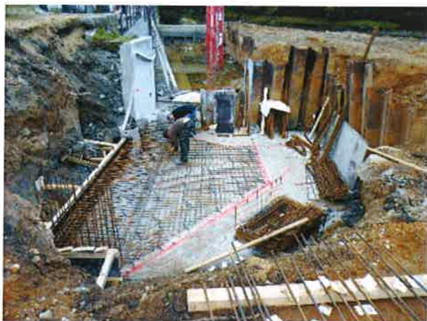
Foto 17 Beginn Bewehrung Bodenplatte Bastion 12.09.2013
