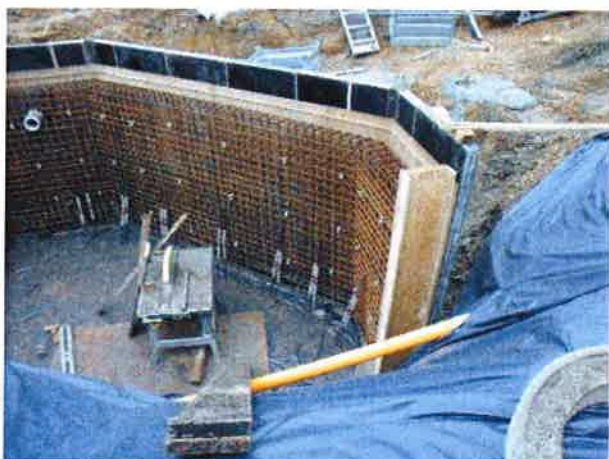
Foto 19 Bewehrung Wände Bastion 26.09.2013
