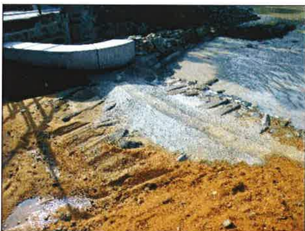
Foto 1 trockenliegende Wehrschwelle nach Errichtung Fangedamm 04.07.2013
