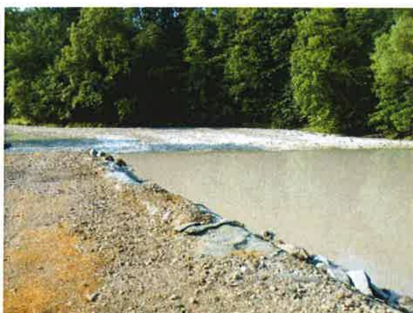
Foto 2 Ansicht befahrbarer Fangedamm 04.07.2013
