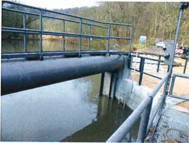
Foto 25 Einsetzen Treibgutabweiser 12.12.2013
