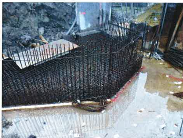
Foto 18 Bewehrung Bodenplatte Bastion 17.09.2013
