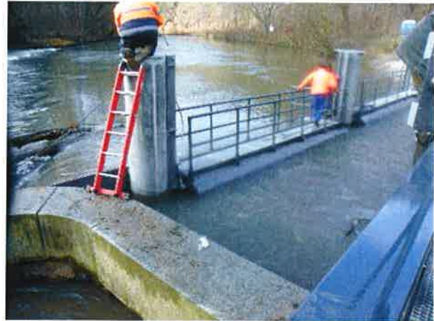
Foto 26 Einsetzen Treibgutabweiser 12.12.2013
