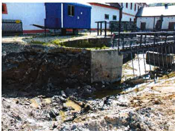
Foto 4 Führungsschienen Treibgutabweiser 04.07.2013
