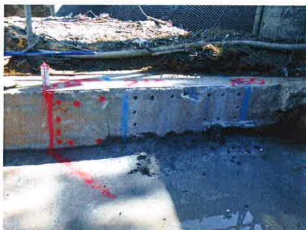
Foto 12 Ankerlöcher Rückverankerung Stützenfundamente 15.08.2013
