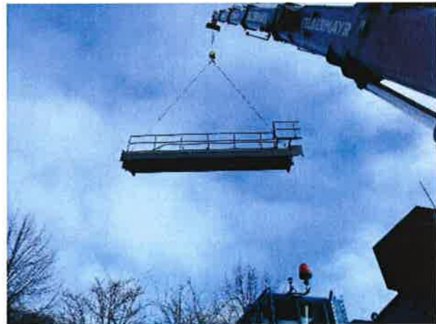
Foto 24 Einsetzen Treibgutabweiser 12.12.2013
