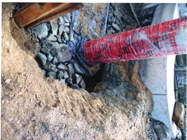
Foto 15 Stütze 2 an der FAA 05.09.2013
