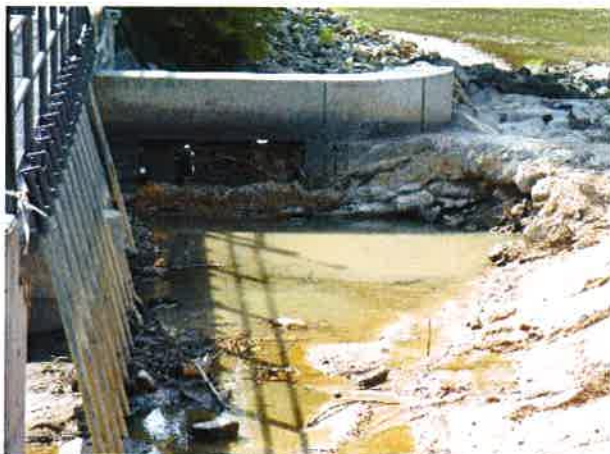
Foto 3 Fertigung Treibgutabweiser 04.07.2013
