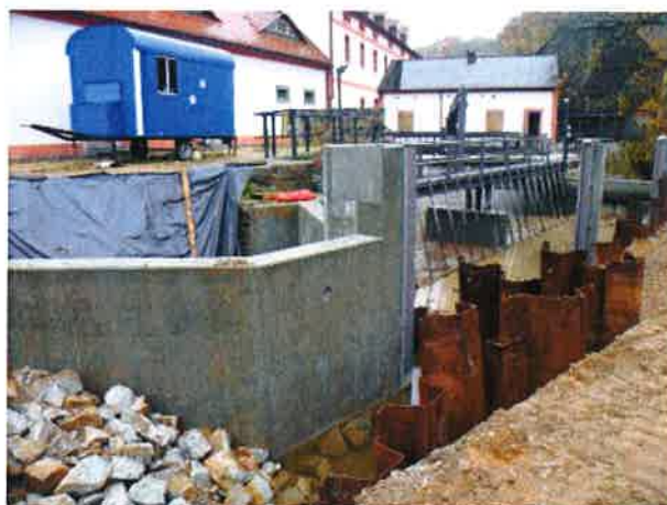
Foto 20 Fertigstellung Betonarbeiten Bastion 16.10.2013
