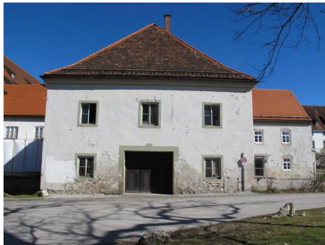
Bild 2: Fraunhofer-Zentrum Benediktbeuern. Die Fassade wird im Jahr 2014 instand gesetzt. Im EG können ab September 2014 Seminare und Workshops durchgeführt werden
