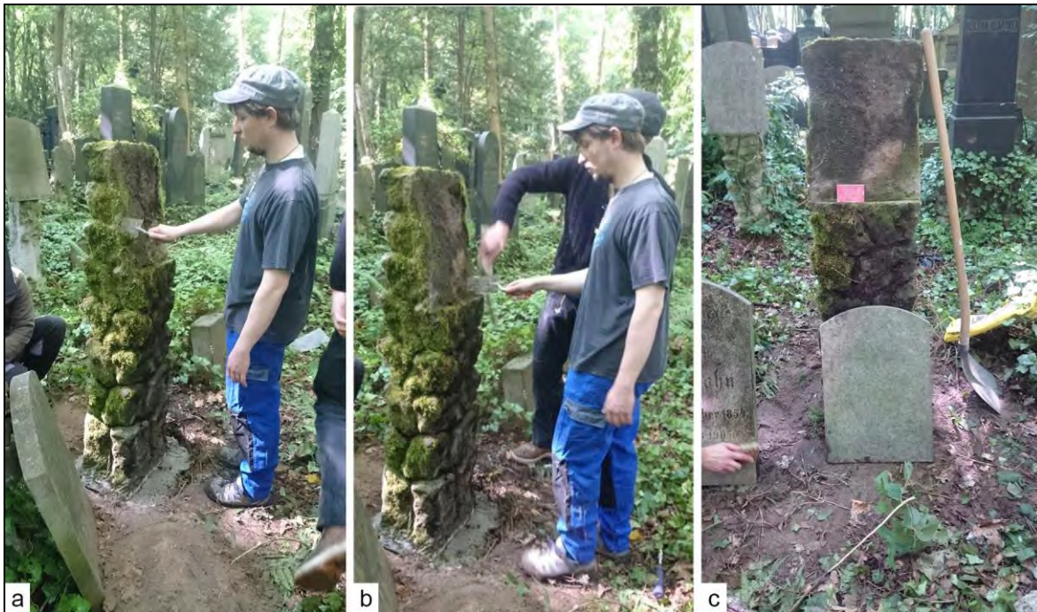
Abb. 80: Instandsetzung von Pultsteinen auf dem Jüdischen Friedhof Weißensee: Reinigen des Auflagers; Fotos: O. Zenker.
