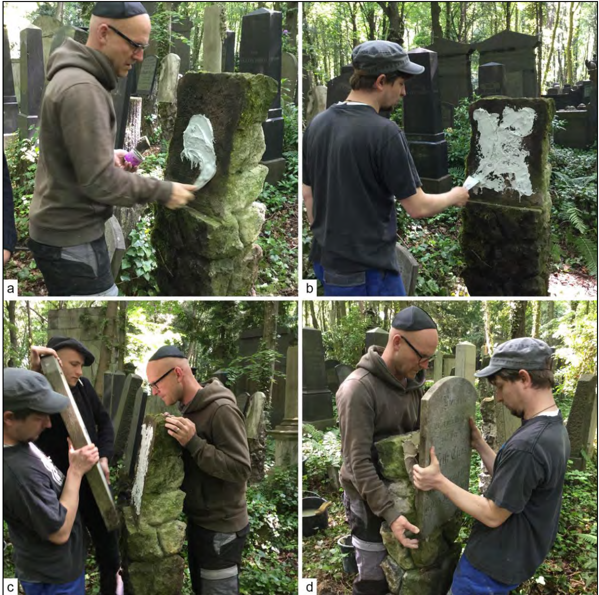
Abb. 83: Instandsetzung von Pultsteinen auf dem Jüdischen Friedhof Weißensee: Auftragen des Klebers und Ansetzen der Schriftplatte; Fotos: O. Zenker.
