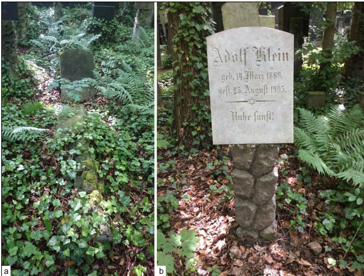
Abb. 86: Pultstein vor und nach Instandsetzung; Fotos: O. Zenker.
