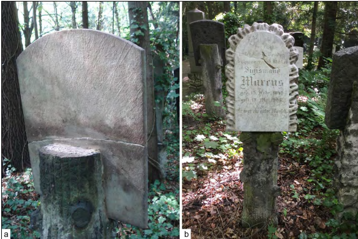
Abb. 82: Instandsetzung von Pultsteinen auf dem Jüdischen Friedhof Weißensee: Gebrochene, vor Befestigung zusammengeklebte Schriftplatten; Fotos: O. Zenker.
