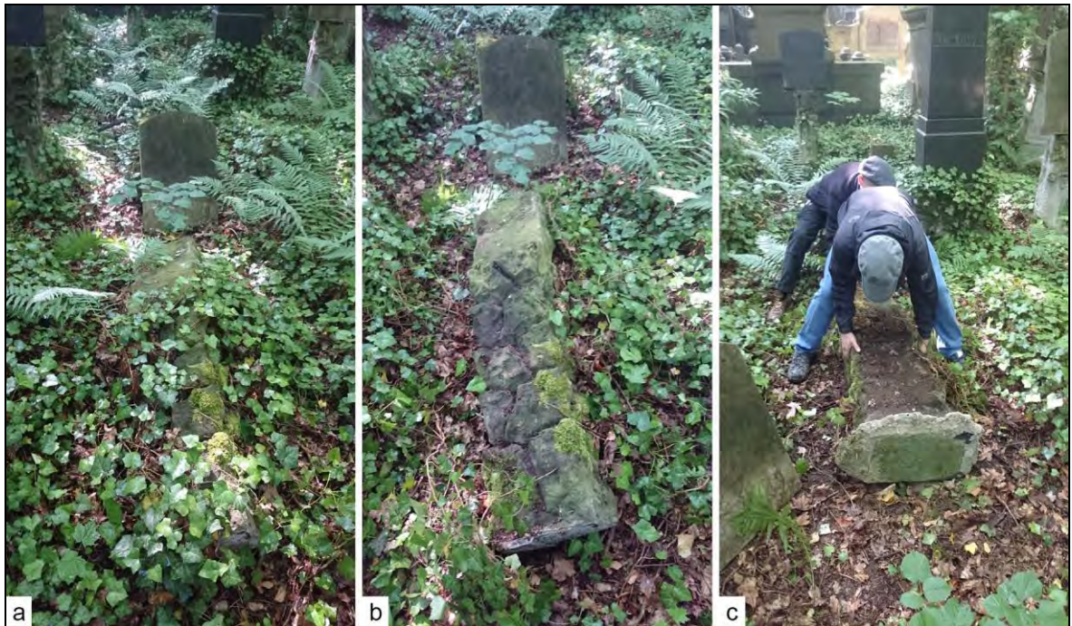
Abb. 77: Instandsetzung von Pultsteinen auf dem Jüdischen Friedhof Weißensee: Freilegung und Bergung des Pultsteins; a. Auffindsituation; b. nach Entfernung des Bewuchses; c. Beiseitelegen des Sockelpfeilers und der Schriftplatte; Fotos: O. Zenker.
