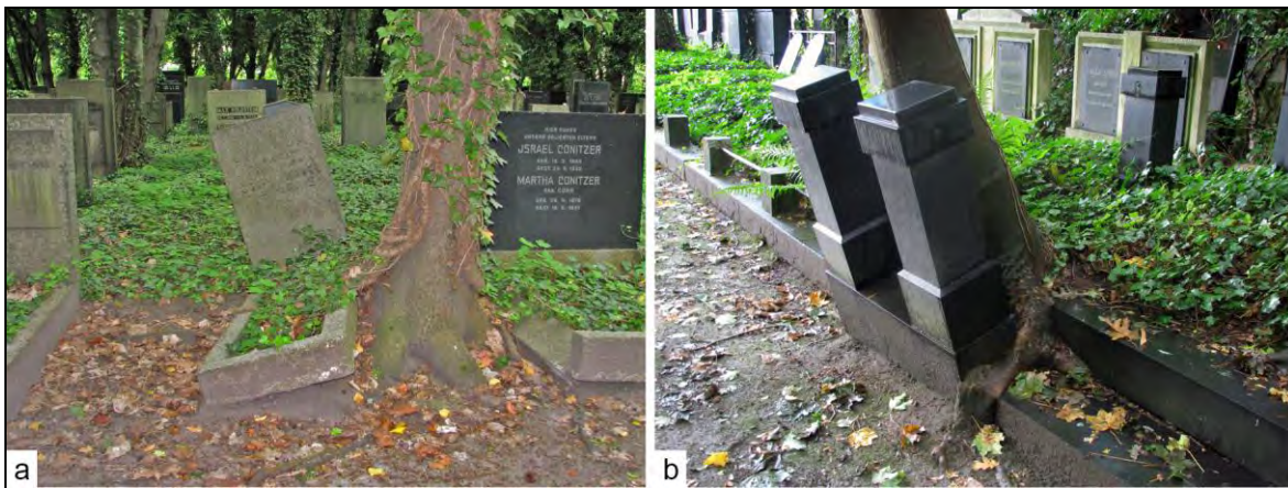
Abb. 60: Beispiele für Wurzelhebungen an Grabmalen; Fotos: A. Lemke.
