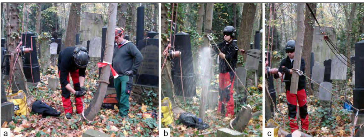
Abb. 70: Fällung von Bäumen mit Doppelseiltechnik auf dem Grabfeld R2, a. Doppelte Befestigung des Seilzugs, b. Beim Sägen wird der Baum durch Seile in seiner Position fixiert, c. Der abgesägte Baum bleibt in seiner ursprünglichen Position und wird stückweise hängend zersägt. Dadurch gibt es keine Schäden durch umfallende Bäume; Fotos: B. Seitz.
