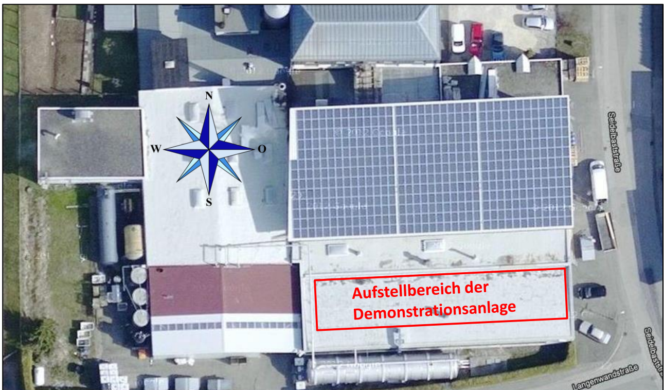
Abbildung 19: Aufstellbereich der Demonstrationsanlage
