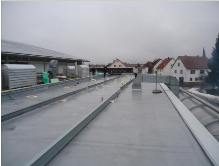
Abbildung 22: Installation Grundträger
