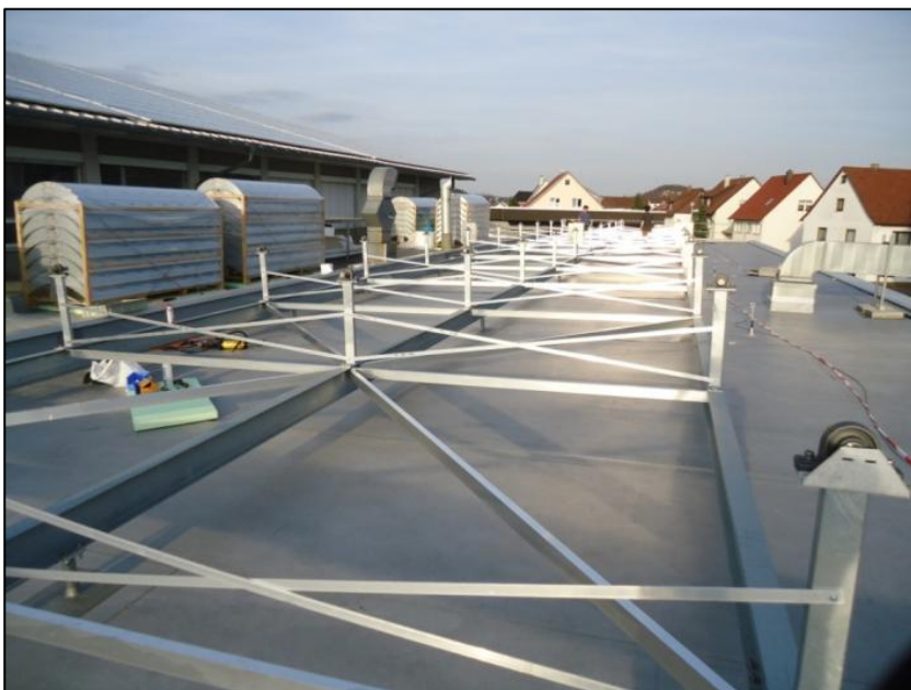
Abbildung 25: Kreuzverbund der Unterkonstruktion
