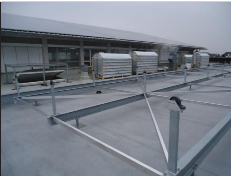
Abbildung 24: Installation Unterkonstruktion mit Lager
