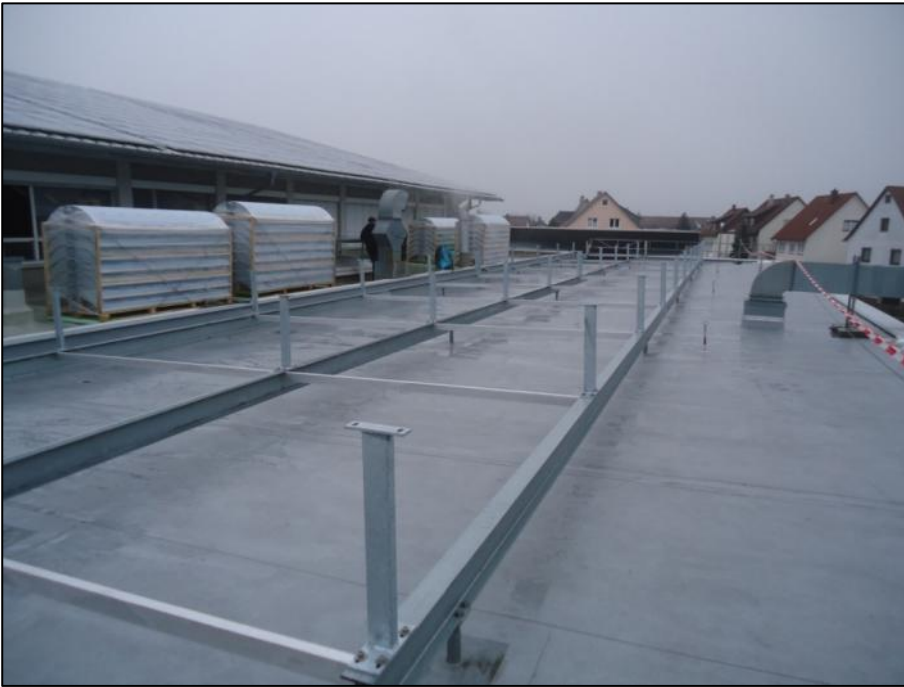
Abbildung 23: Installation der Unterkonstruktion
