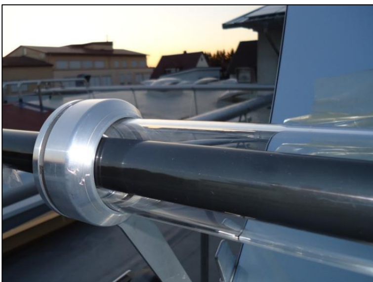
Abbildung 8: Verbaute Absorber-Muffe
