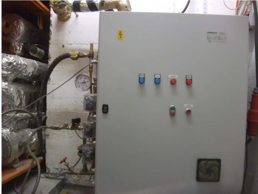
Bild 3: Frischdampferzeuger KE 12 der Firma Jordan
