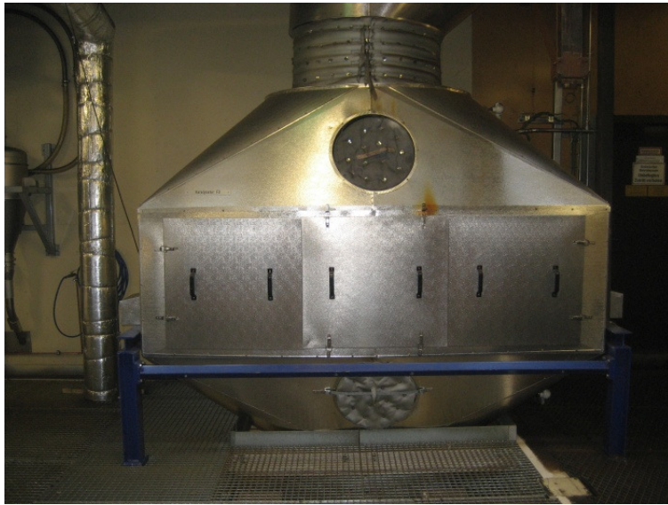
Katalysatorgehäuse für einen Chargenröster (zweistufiger Oxidationskatalysator)
