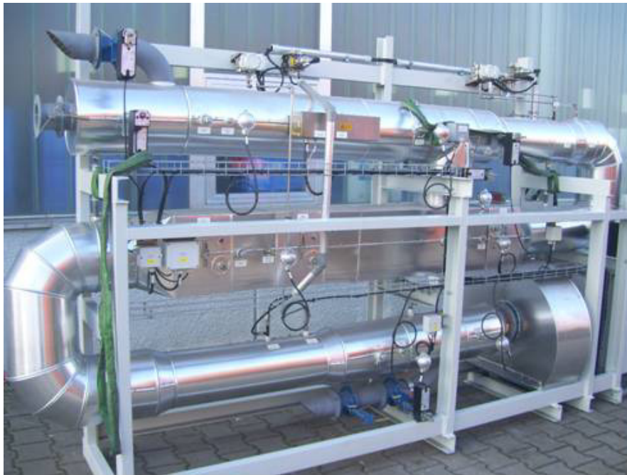
Abb. 12: Fertiggestellte Versuchsanlage vor dem Transport
