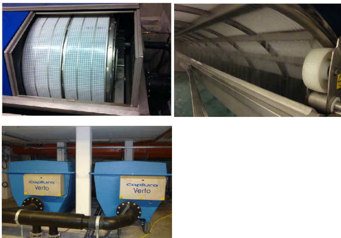
Abbildung 2: Außen- und Innenansichten des Siebtrommelsystems Verto
