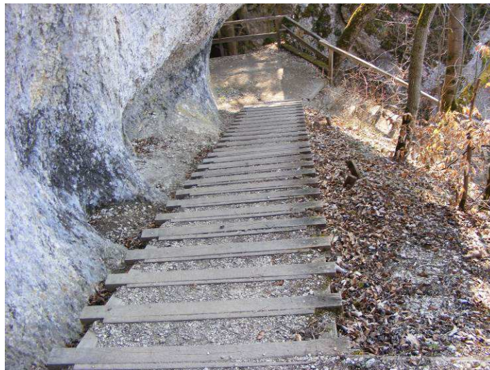
Abb. 41: Treppenweg als Sonderform des Wegtyps 2 in den „Grotten“ der Fürstlichen Anlagen Inzigkofen. (Foto: P. Pauli)
