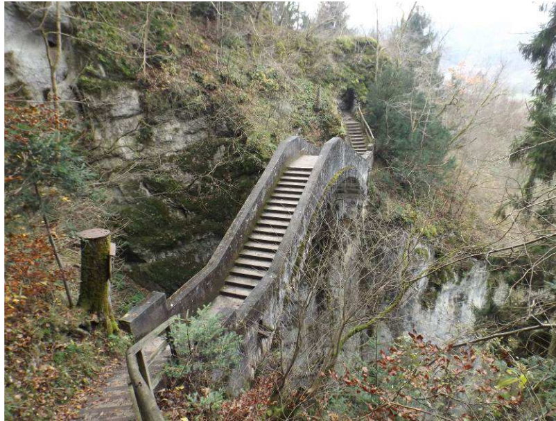
Abb. 25: Weg zur Teufelsbrücke über die „Höll“ in den Fürstlichen Anlagen Inzigkofen. Die Brücke wurde 1895 aus Beton gefertigt und ersetzte eine leichtere Konstruktion, die aus Holz bestand. Der Weg wurde bereits in der Urkarte von 1844 dokumentiert. (Foto: P. Pauli)
