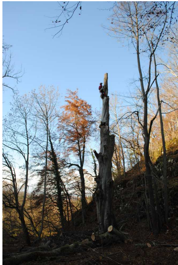
Abb. 244: Buche auf der Festwiese nach der stückweisen Fällung in SKT. Torso bleibt erhalten. (Foto: M. Jauch)
