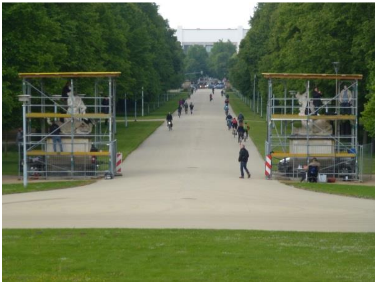
Eingerüstete Kentaurengruppen an der Hauptachse im Großen Garten
