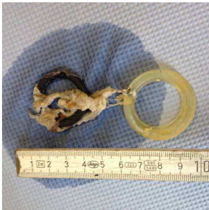
Abb. 6: Dichtungsringe mit Faserzopf wurden mit angesaugt
