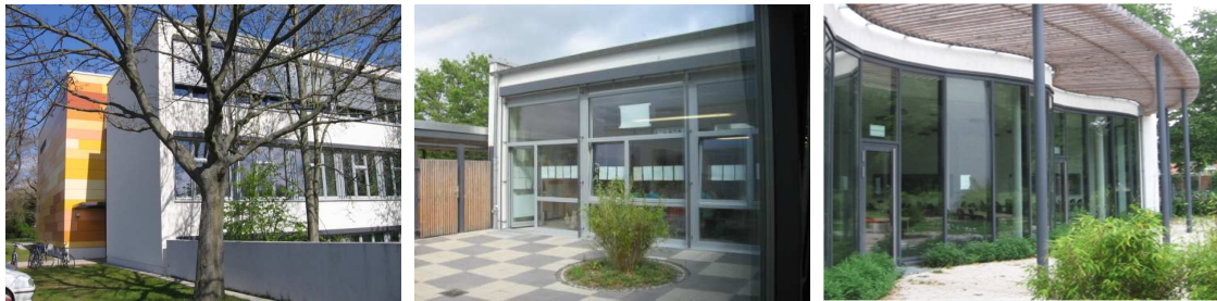
Abbildung 72: Aula-Trakt Bestand Südostansicht
