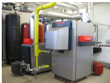
Abbildung 76: Gas-Brennwertkessel (Grundlast)
