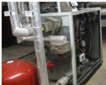
Abbildung 69: Fernwärme Wärmetauscher
