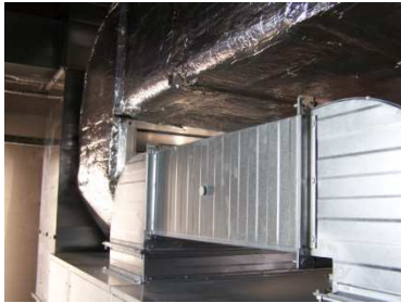
Abbildung 82: zentrale Lüftungsanlage
