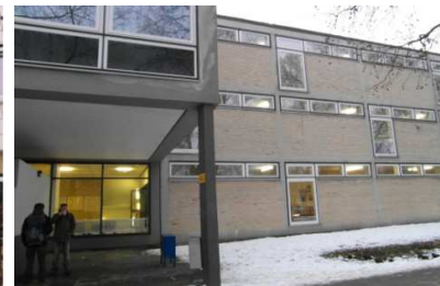
Abbildung 87: Mensa Neubau Südostansicht
