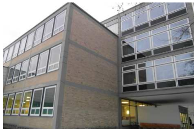
Abbildung 85: Aula-Trakt Bestand Südostansicht
