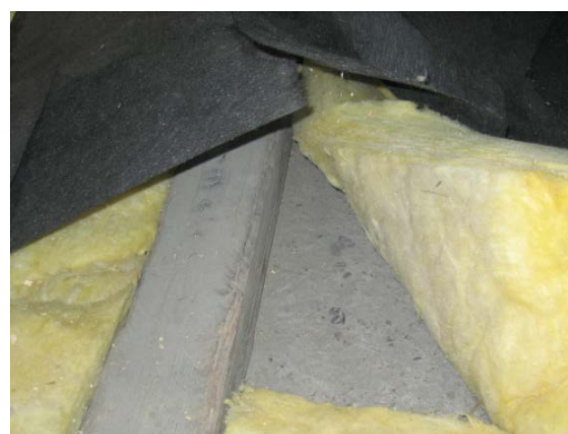
Bild 25 Bereits sanierte Geschossdecke (Kuppelvordach)
