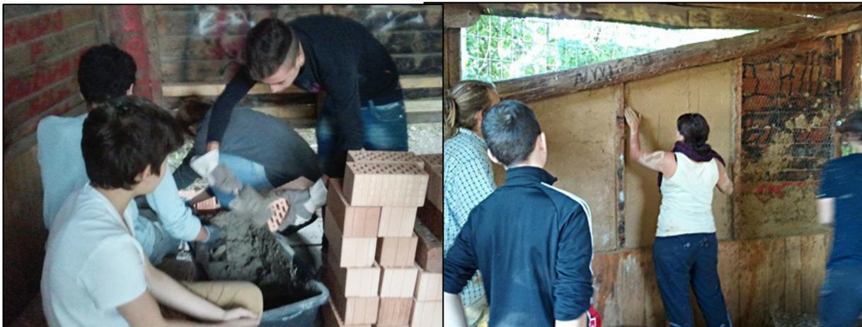
*Links wird die kleine Mauer erstellt, rechts die Innenwand des Pavillons mit Lehm verkleidet.*
