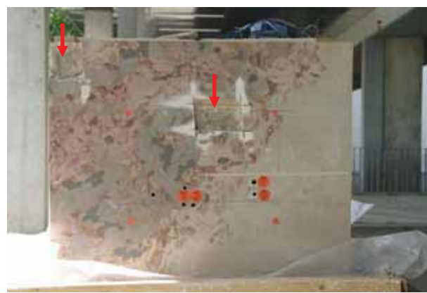
Abb. 103 Gipsstuckprobekörper nach der Mikrowellenbehandlung, Beprobung der Oberfläche zur weiteren Untersuchung
