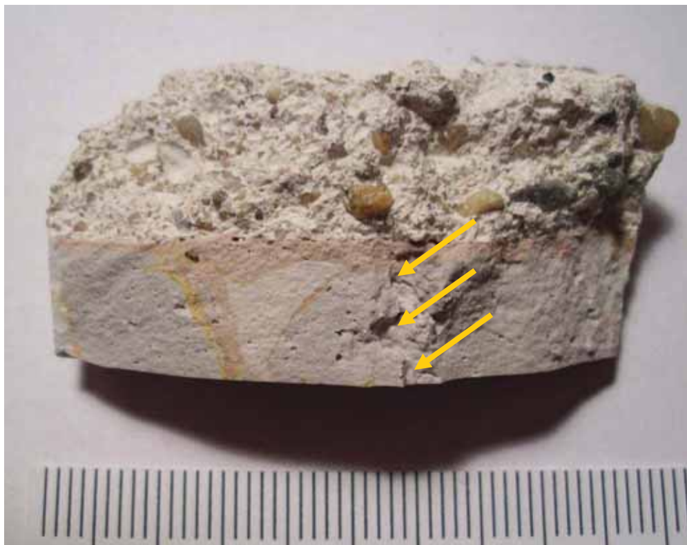
Abb. 105 Gipsstückprobekörper nach der Mikrowellenbehandlung, Unterbeprobung der Gipsstückprobe im Rissbereich für die ESEM-Analyse, Im Bild: Gipsstück (unten) mit Putzuntergrund (oben)
