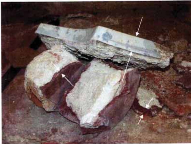
Bruchstücke der Stuckmarmor- Architekturfassung, die unterschiedlichen Schicht- bzw. Plattendicken werden deutlich. Die Ausführung erfolgte teilweise als dünner Vorsatz (braunrote Schicht) auf einem Mörtelstuckgrund als Träger (weißes Material), teilweise auch in Form von vorgefertigten Schalen bzw. Platten (graue Platte)
