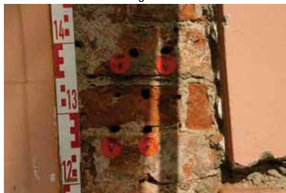
Abb. 124 Probenahmestellen, V = Voruntersuchung, N = Nachuntersuchung
