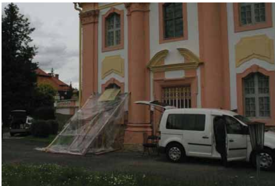
Abb. 116 Versuch der Mikrowellenbehandlung von der Außenseite der Kapelle
