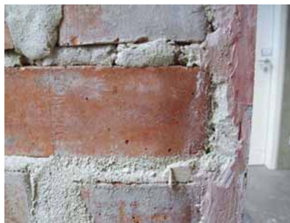
Abb. 83 Ziegelmauerwerk mit Stuckauflage (rechts)
