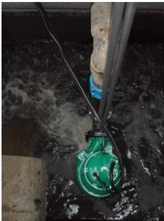
Abb. 6: Inbetriebnahme der Pumpe FA 15.66 am 15.11.2012
