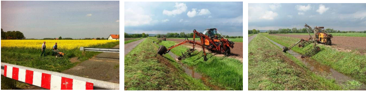
Abb. 7: Angepasste Böschungsmahd in Coenagrion mercuriale -Gräben Anfang Mai.
