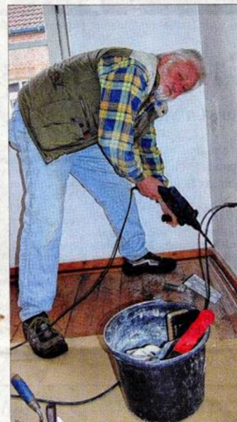
Hausmeister Berthold Geesen ist mit Innen-Renovierungsarbeiten beschäftigt.
