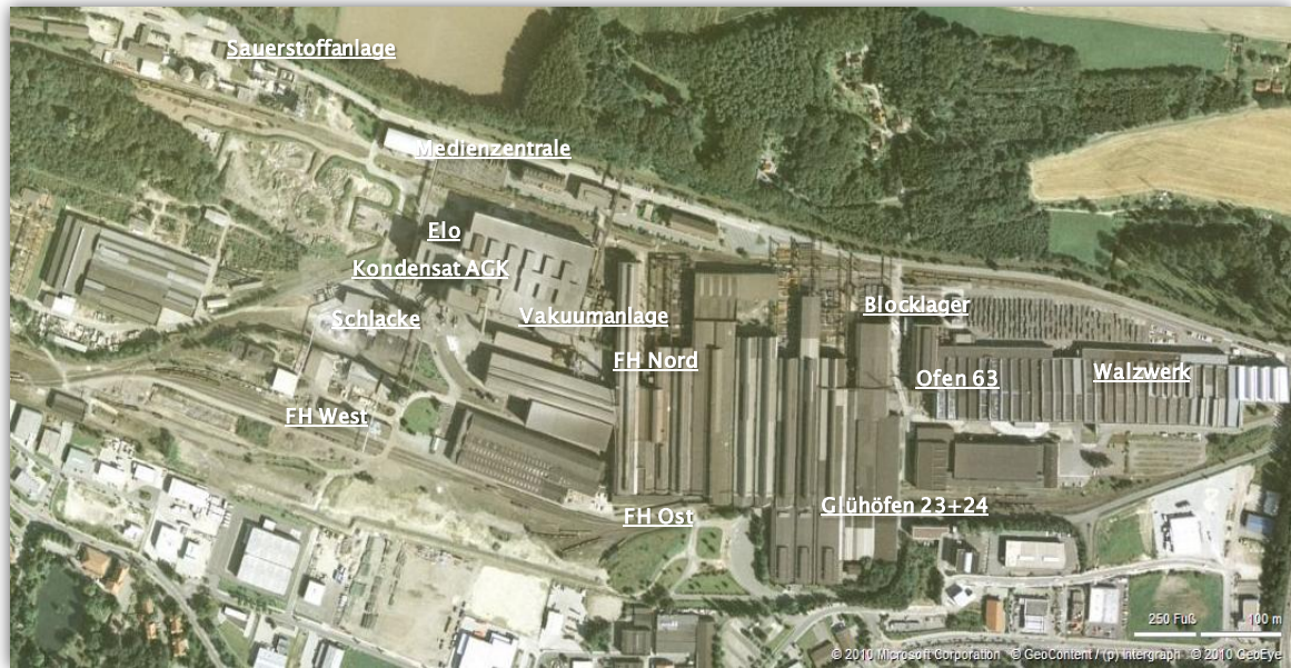
Abbildung 2: Abwärmequellen und -senken auf dem Werksgelände
