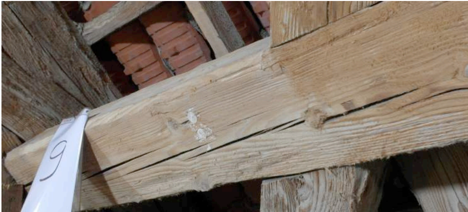
Abb. 39 Naumburg, Dom, Feld 9, Zustand nach Bariumacetatapplikation (11.3.2014)
