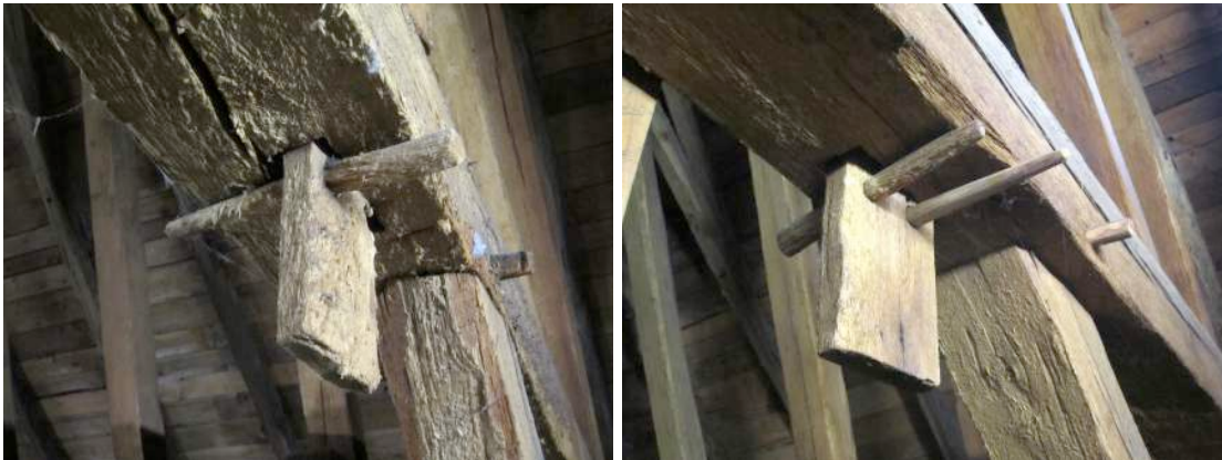
Abb. 32, 33 Meisenheim, Schlosskirche, Zapfenschlösser vor und nach Reinigung mittels rotierender Kunststoffbürste
