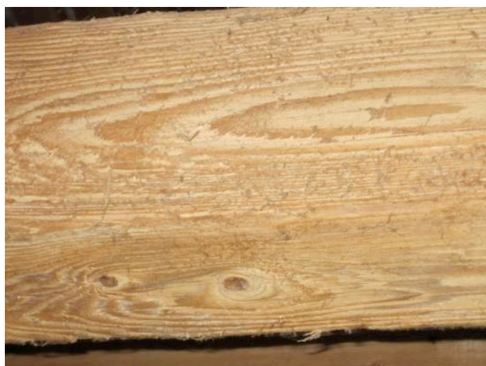
Abb. 16 Wechselburg, Klosterkirche: Mazeration nach Reinigung
