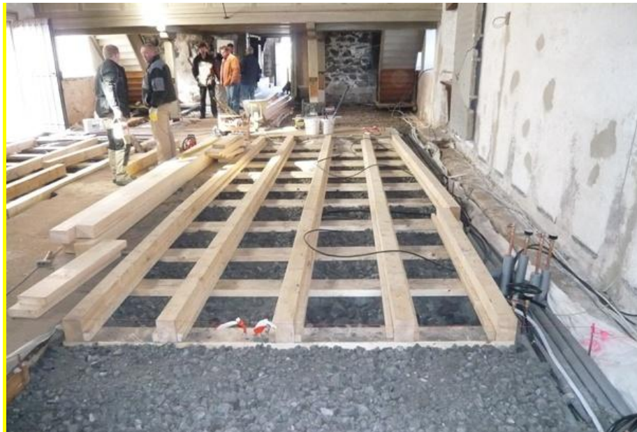
Abbildung 14: Verlegung der hölzernen Lagerroste im Bereich der Bankpodeste
