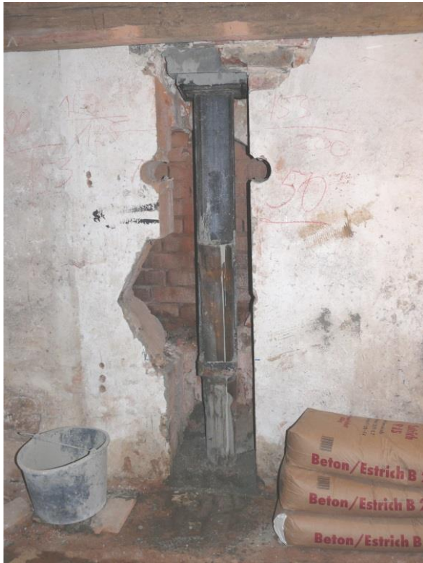
Bild A 6: Eingebauter SOB-Mikropfahl
