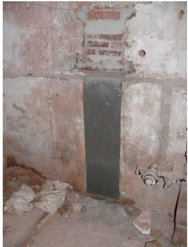
Bild A 7: Vermauerter Mikropfahl
