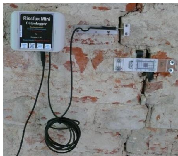
Bild A 5: Induktiver Wegaufnehmer und Rissmonitoring
