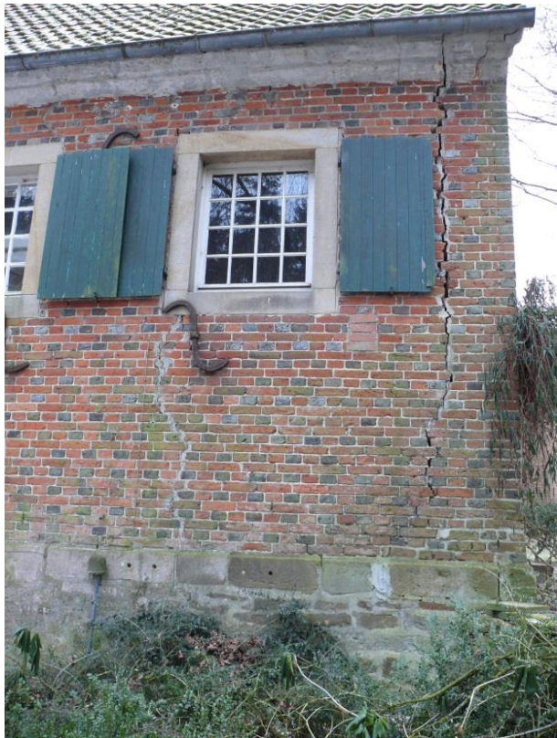
Bild 3: Vertikalriss - Westwand
