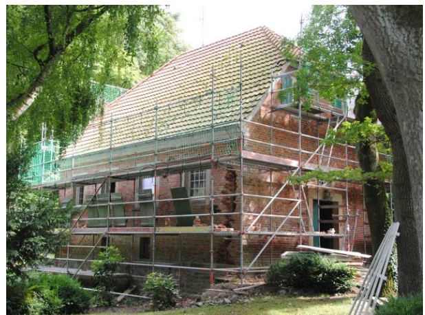
Bild A 9: Dachdeckerarbeiten
