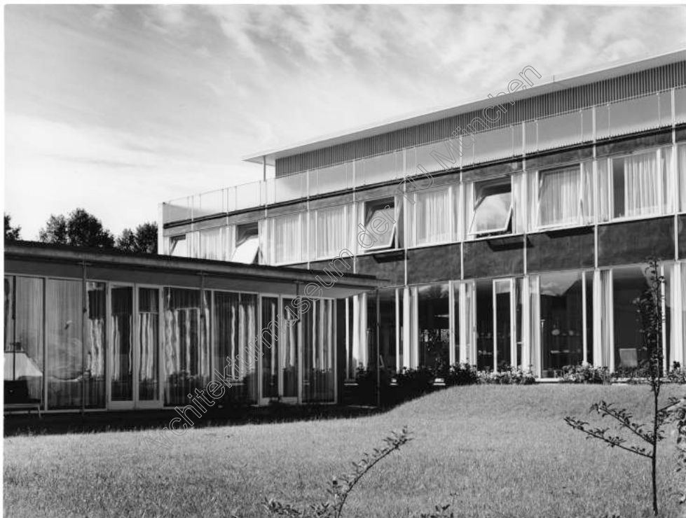
Abbildung 8: Gartenansicht der Vertretung des bayerischen Bevollmächtigten nach der Fertigstellung 1955. Bild: Architekturmuseum der TU München.
