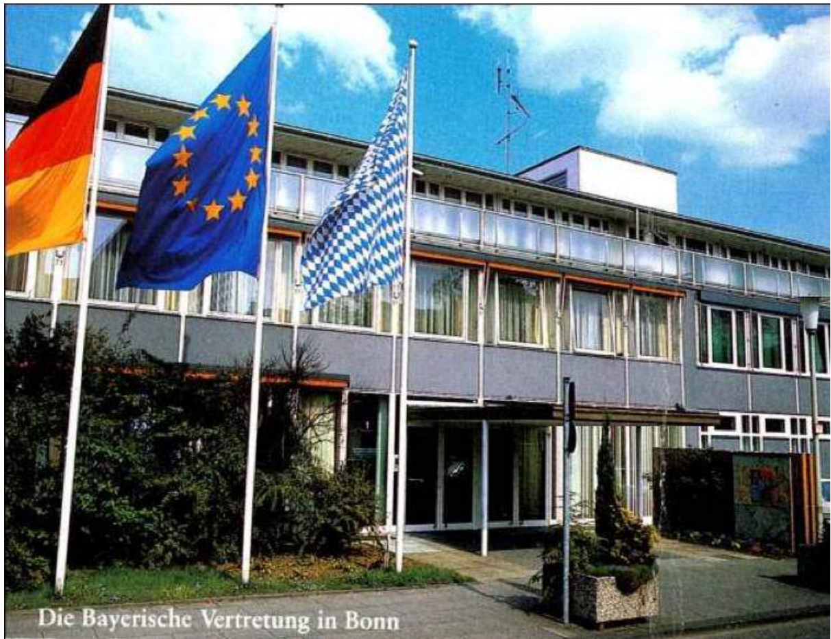
Abbildung 21: Postkarte der Bayerischen Vertretung mit dem Anbau und bereits blau gestrichenen Terrazzofeldern in hellem Blaugrau. Deutlich erkennbar sind die schweren Fensterprofile und die Grünfärbung der schusssicheren Gläser im Anbau.
