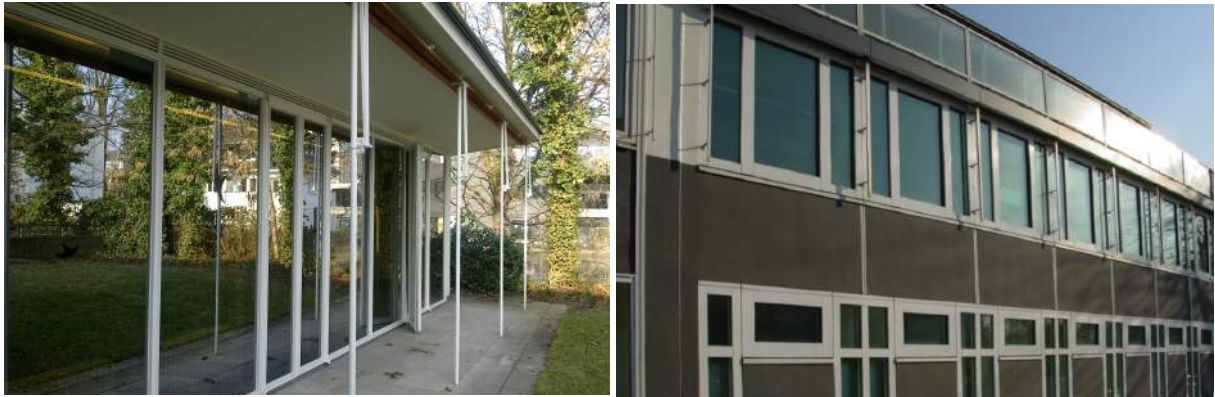
Abbildung 6: Südostfassade des Gartenpavillons. Abbildung 7: Straßenseite des Anbaus.
