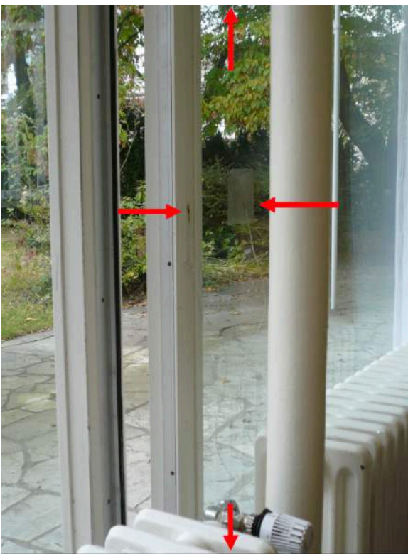
Abbildung 31: Oberflächenmessung an der Pavillonfassade. Foto: HZI Ingenieure.
