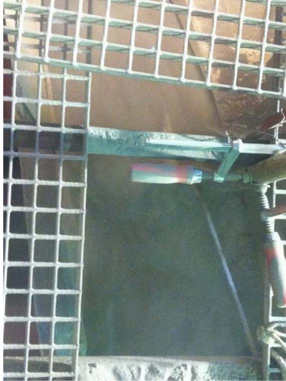
Bild 10: Aufsicht auf den Zulauf zum Becherwerk mit provisorisch installierter Umlenkschaufel (rechts im Bild, mit Schraubzwingen arretiert)
