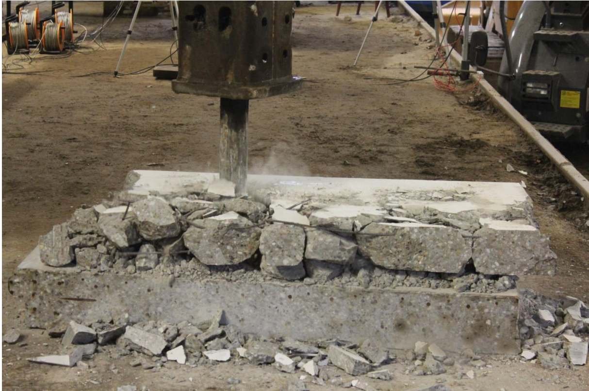
Abbildung 13: Dritte Versuchsreihe: Abbruch von Stahlbetonteilen
