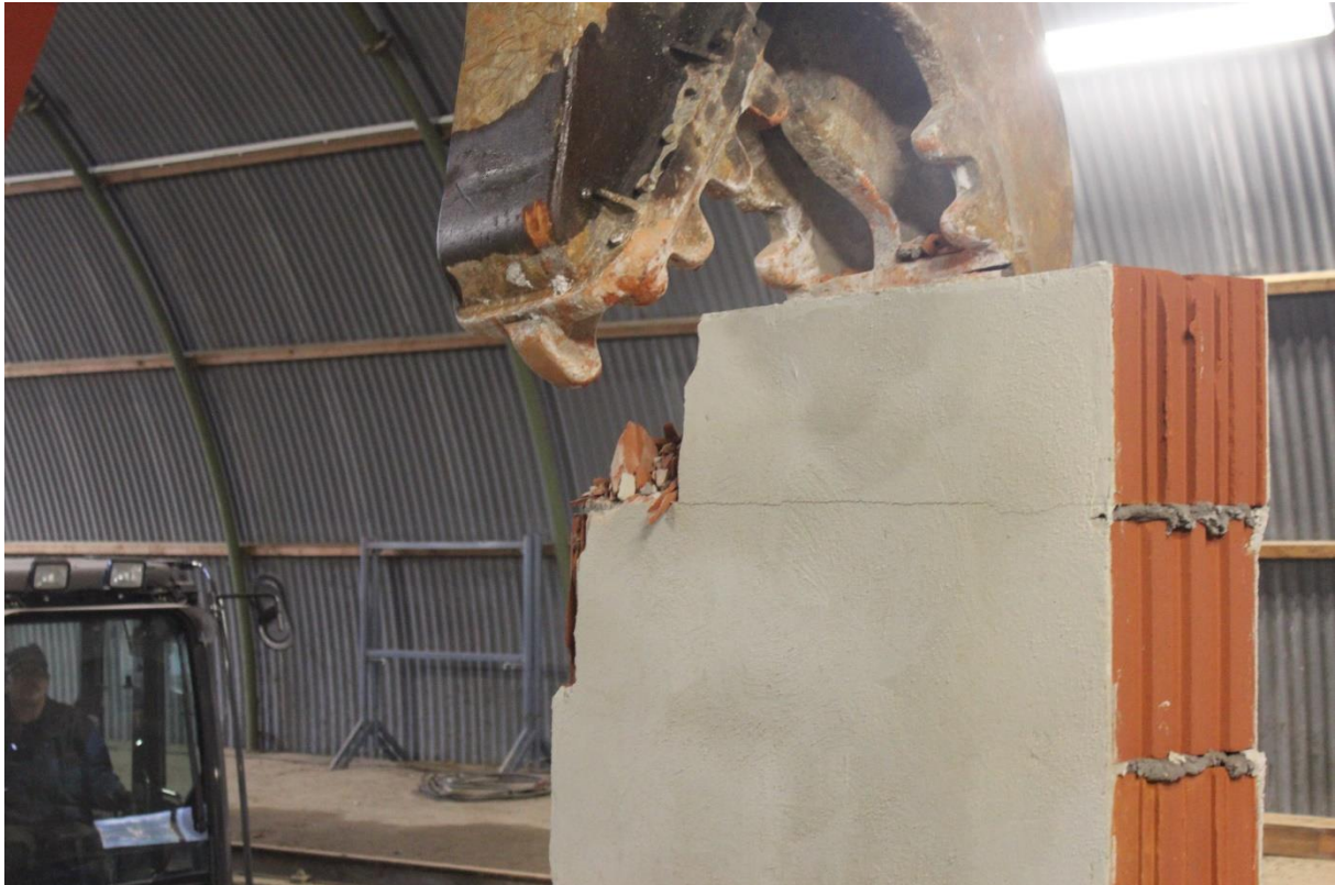
Abbildung 12: Zweite Versuchsreihe: Abbruch von verputzten Ziegelsteinwänden
