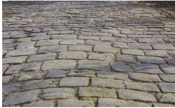
Bild 9: Kalkgebundene Pflastersteine Unt. Stubensandstein
