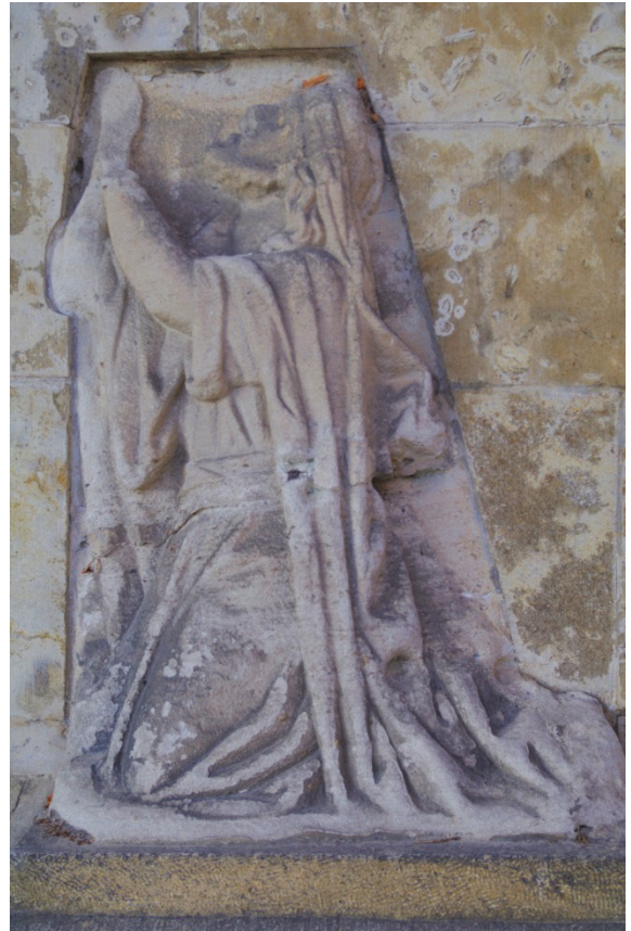
Bild 50: Außenfassade mit betendem Christus
