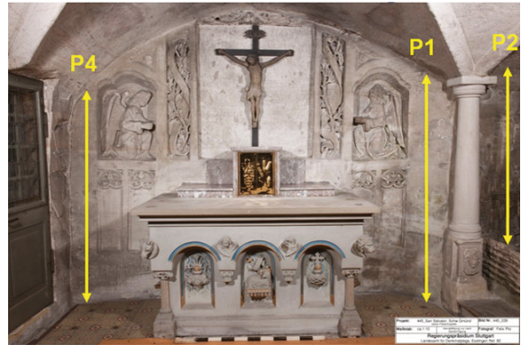
Bild 6 Messprofile mit dem TDR Messgerät in der Oberen Kapelle (Foto: Landesamt für Denkmalpflege im RP Stuttgart, Felix Pilz).
