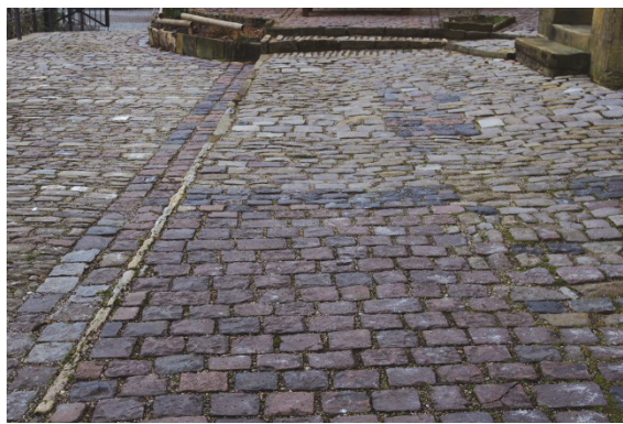
Bild 56: Die Pflastersteine auf dem Plateau
