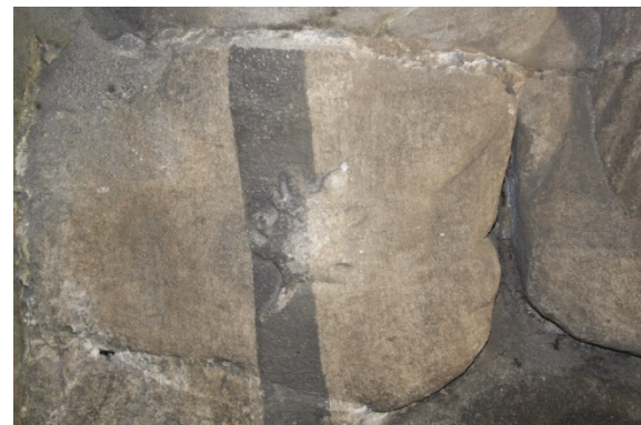
Bild 46: Laser-Reinigung, Detail Zwischenzustand Bereich 03.02
