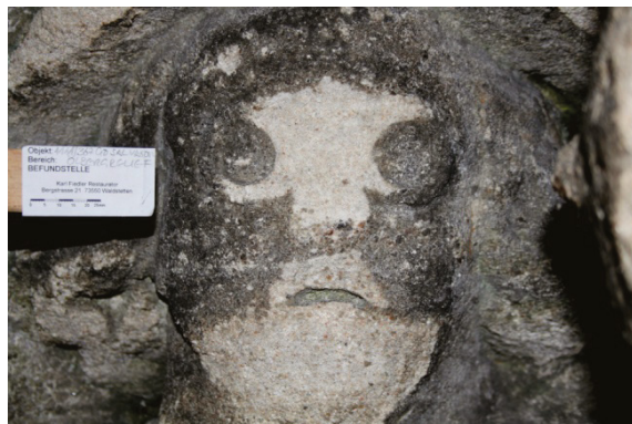
Bild 28: Bereich 06.19 Verlust von Reliefhöhen
