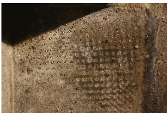
Bild 39: Zementfußboden mit Kondenswassertropfen
