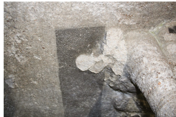
Bild 47: Laser-Reinigung, Detail Zwischenzustand Bereich 05.01 (Decke)
