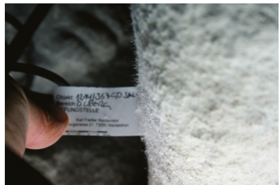
Bild 67: Salzkristallisation während der Entfeuchtung nach Kittung und Schlämmung
