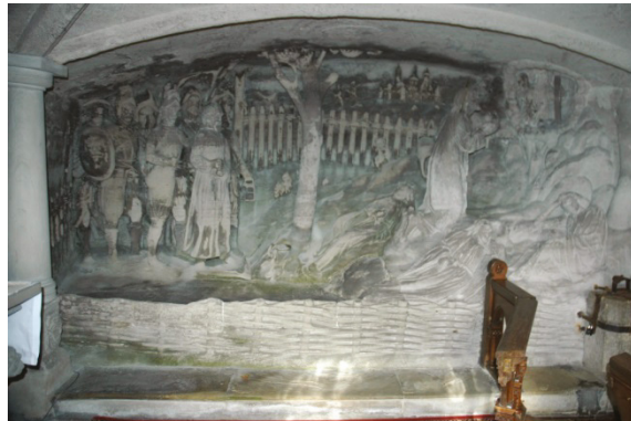
Bild 1: Ölbergsszene in der oberen Kapelle mit braun-grünem Biofilm
