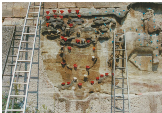
Bild 2: Festigung mittels Infusionstechnik am Bildfeld 3, Herzog Christian [2]
