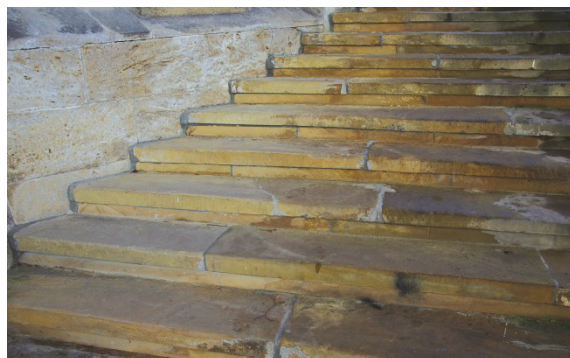
Bild 47: Sandsteintreppe, Schilfsandstein und Muschelkalkfassade
