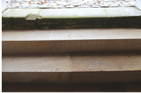
Bild 24: Stufen erneuert durch Leistädter Sandstein
