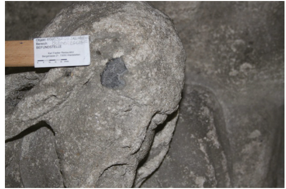
Bild 15: Ergänzung aus dunkelgrauem Mörtel an der Stirn der Jakobus-Figur
