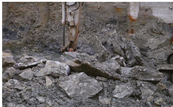
Bild 10: Fleins aus dem Unteren Stubensandstein im Tunnel
