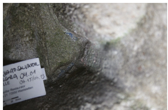
Bild 17: Bereich 04.01 Wandfläche Nord Fassung, blau auf heller Grundierung.
