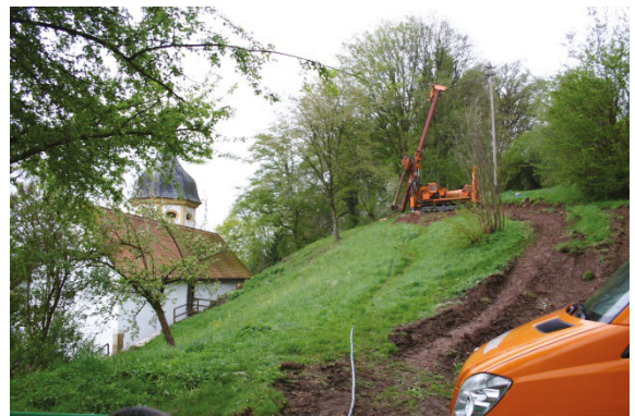
Bild 1: Bohrgerät bei der Vorbereitung von Bohrung 2.
