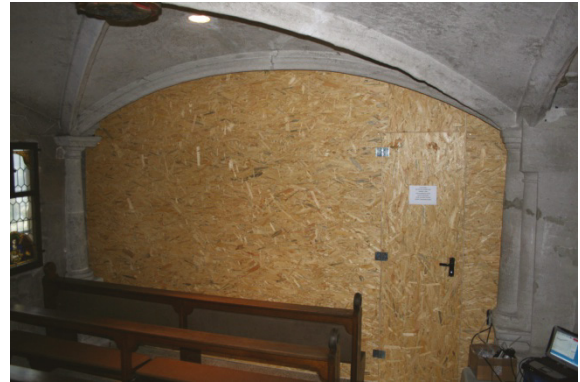
Bild 49: Trennwand für Bearbeitung Ölberg, rechts unten permanente Messung der Ethanol-Konzentration im Ölbergbereich
