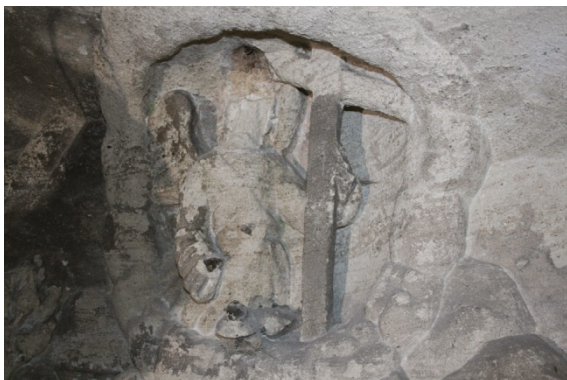
Bild 14: Ergänzungen aus dunkelgrauem Mörtel an Engel (Kelch und rechte Hand)
