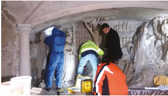
Bild 56: Nach der Festigung Absaugung von Schimmelbildung in den Tiefen / Kontrolle der Festigung durch Ultraschall-Laufzeitmessung
