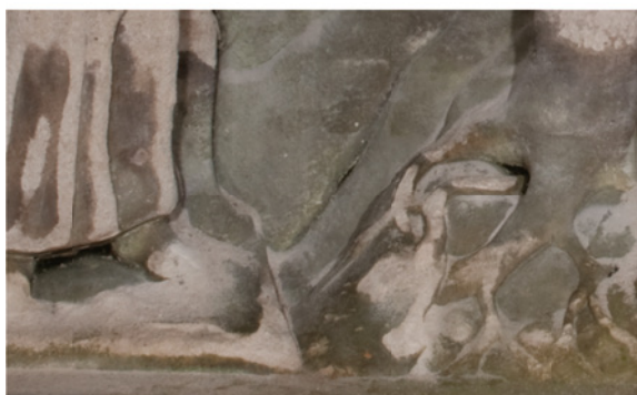
Bild 4: Inhomogene Verteilung des Biofilms in der Ölbergsszene
