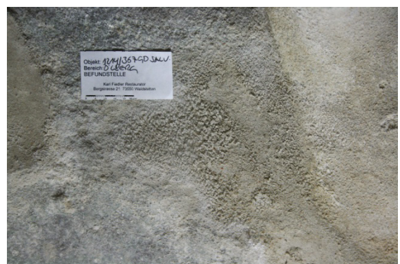
Bild 68: Salzkristallisation während der Entfeuchtung nach Kittung und Schlämmung
