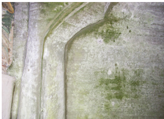
Bild 8: Schichtiger Verlauf des Biofilms, der den Inhomogenitäten des Steins folgte
