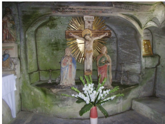
Bild 2: Kreuzigungsgruppe in der unteren Kapelle mit intensiv grünem Biofilm
