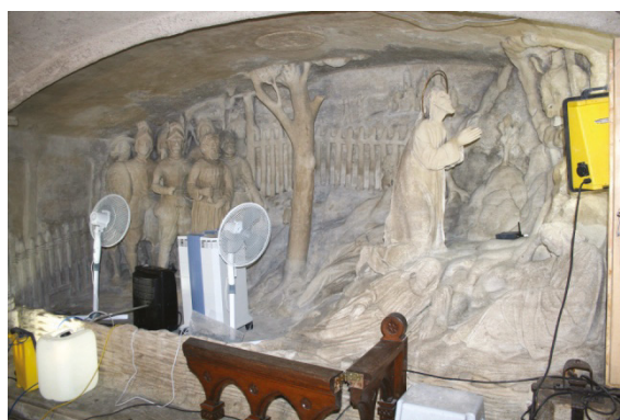
Bild 65: Trocknung von Kittungen / Schlämmen durch Entfeuchtung, Absorbition, und Ventilation in der Ölbergnische
