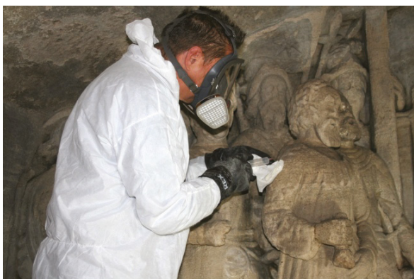
Bild 53: Gezielte Applikation mit Spritze und Kanüle
