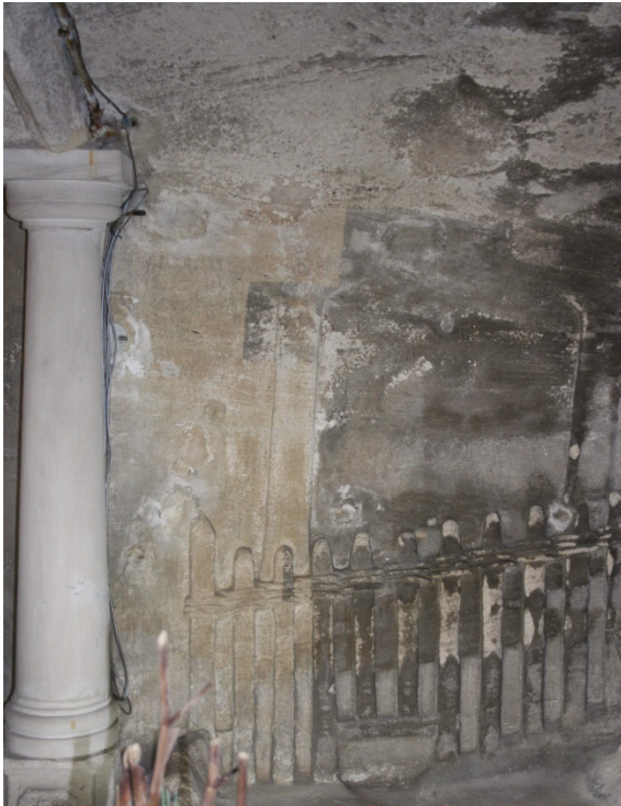
Bild 37: Laser-Reinigung Musterfläche in Bereich 04.03
