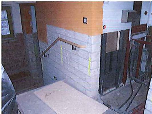
Im St. Clemens-Haus (Ausgang zum Garten der Bibelpflanzen) wurde der Innenputz abgeschlagen, der Fußboden ausgebaut und mit der Trocknung des Fußbodens begonnen
