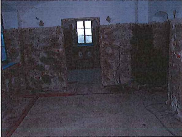
In der ehemaligen Mühle (Aufenthaltsraum) wurde der Innenputz abgeschlagen, der Fußboden und das Mauerwerk wurden getrocknet, die Elektrik wurde teilweise erneuert, der Spritzputz wurde aufgetragen
