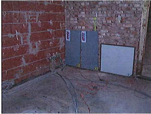
Im Celsa-Pia-Haus (Spülküche) wurde der Innenputz ausgebaut, der Fußboden geöffnet und mit der Trocknung des Fußbodens begonnen
