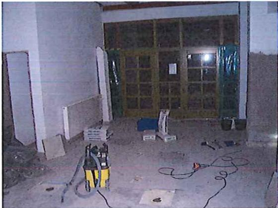
In der ehemaligen Mühlenscheune wurde der Eingangstürflügel erneuert, der Innenputz abgeschlagen, der Fußboden und das Mauerwerk wurden getrocknet, die Elektrik wurde teilweise erneuert, der Putz wurde aufgebracht
