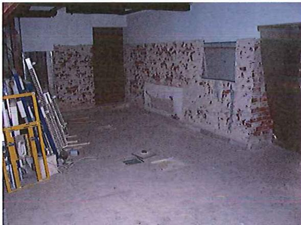
In der ehemaligen Mühle (ehemalige Dauerausstellung Energie) wurde der Innenputz abgeschlagen, der Fußboden und das Mauerwerk wurden getrocknet, die Elektrik wurde teilweise erneuert
