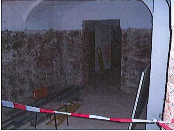
In der ehemaligen Mühle (Eingangsbereich) wurde der Innenputz abgeschlagen, der Fußboden und das Mauerwerk wurden getrocknet, die Elektrik wurde teilweise erneuert
