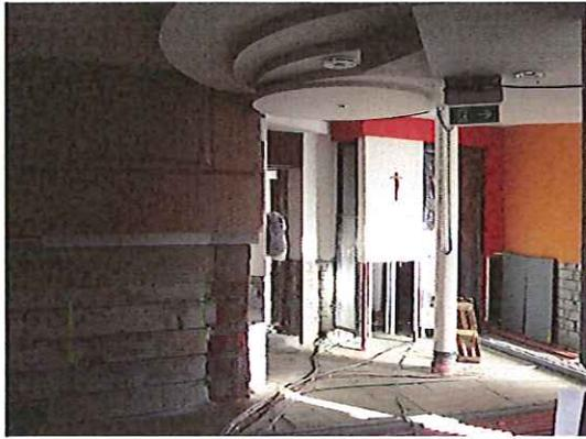
Im St. Clemens-Haus (Eingangsbereich) wurde der Innenputz abgeschlagen, der Fußboden ausgebaut und mit der Trocknung des Fußbodens begonnen
