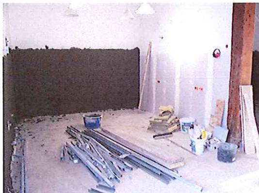
Im Haus der Familie (Kinderbetreuung) wurde der Innenputz entfernt, der Fußbodenaufbau wurde komplett zurückgebaut, die Elektroarbeiten sind zum großen Teil erledigt, die Räume wurden getrocknet, der Putz wurde aufgetragen
