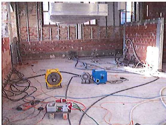
Im Celsa-Pia-Haus (Küche) wurde der Innenputz abgeschlagen, der Fußboden ausgebaut und mit der Trocknung des Fußbodens begonnen
