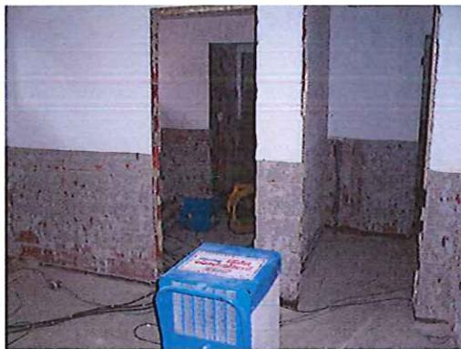
Im Celsa-Pia-Haus (Sozialtrakt) wurde der Innenputz abgeschlagen, der Fußboden ausgebaut und mit der Trocknung des Fußbodens begonnen
