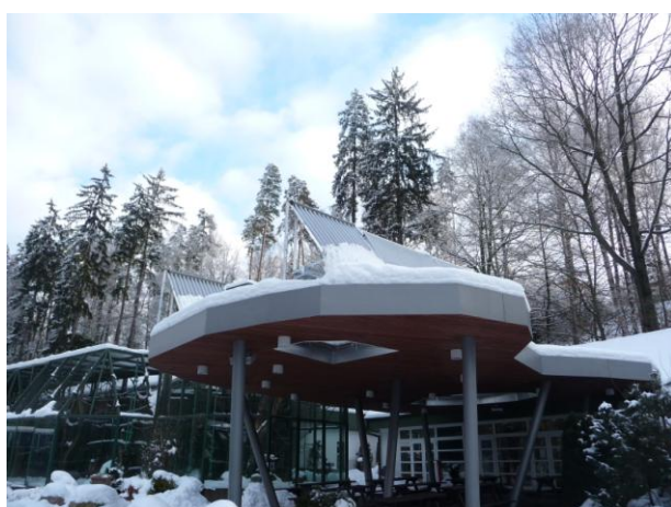
Abb. 9: Sonnenkollektoren auf Imbiss
