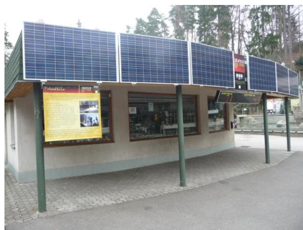
Abb. 8: Fotovoltaik am Souvenirladen
