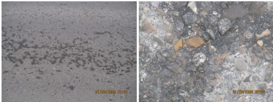
Abbildung 4-4: Dokumentation von „Salzflecken“ und die Auswaschung von Feinpartikeln aus dem Fahrbahnmaterial als Folge der Salzstreuung [Lambert, 2010]
