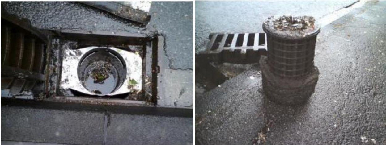
Abbildung 4-12: Zusetzen der Filtermantelfläche durch feine Pollen im Frühjahr [SEH und IGS, 2010]
