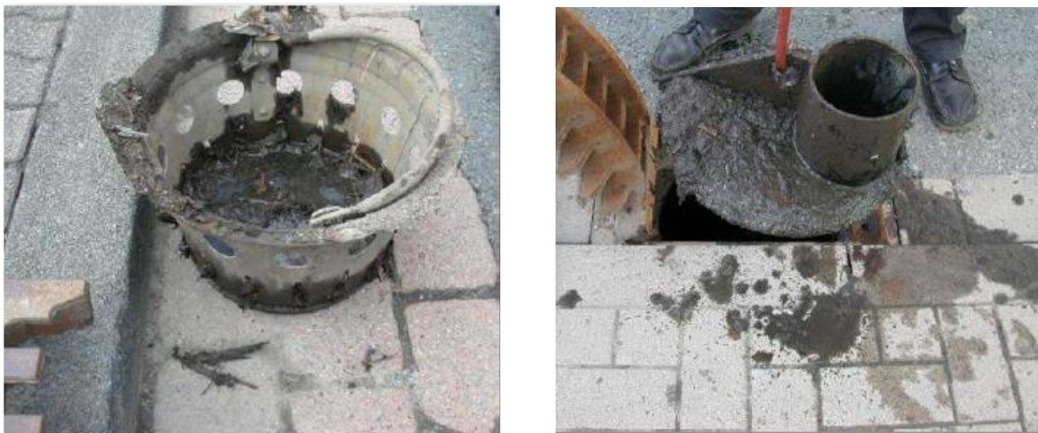
Abbildung 4-22: Aquafoel-Sicherheitsstraßenabläufe bei der Kontrolle [Ellerhorst, 2012a]
