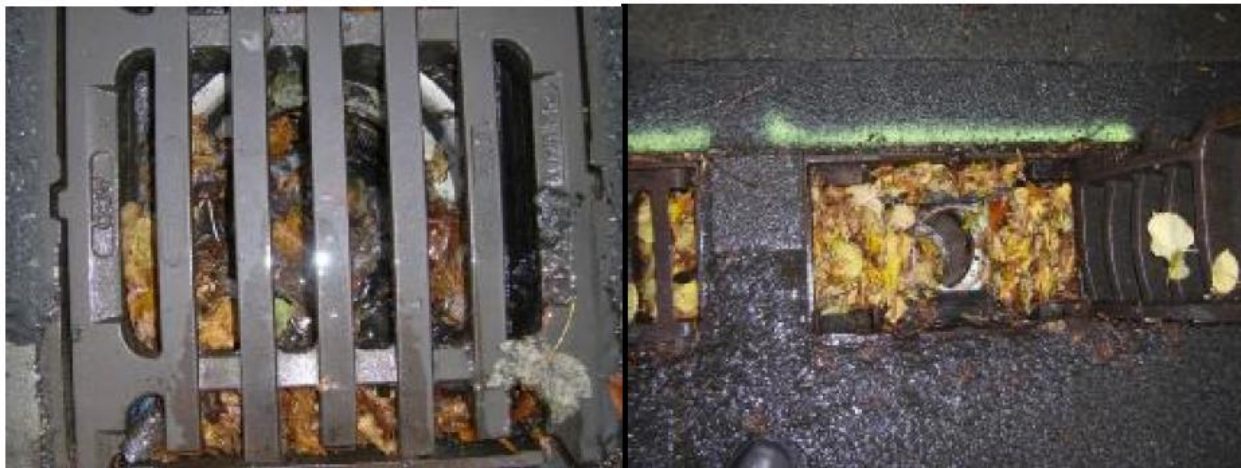
Abbildung 4-12: Zusetzen der Filtermantelfläche durch feine Pollen im Frühjahr [SEH und IGS, 2010]
