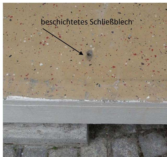
**Abbildung 15 Verriegelungssystem und beschichtete Schließbleche**
