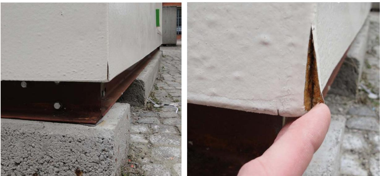
**Abbildung 18** Abgeplatzte Kante im Eckbereich
