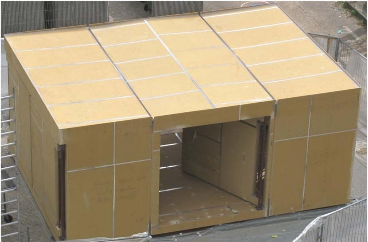
Abbildung 30 Fugen an Plattenstößen mit handelsüblichem Klebeband abgeklebt
