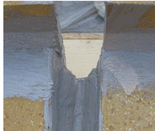
Abbildung 39 Regenablaufrinne am Übergang Dach/Fassade vor der Beschichtung
