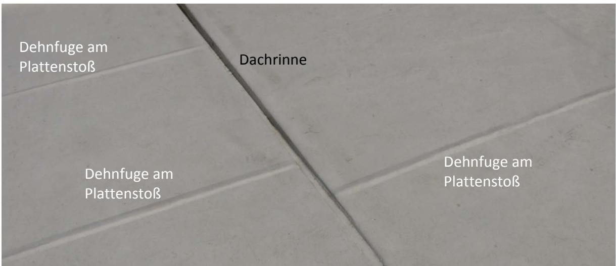
Abbildung 31 Aufwölbung der Beschichtung im Bereich der Dehnfugen im Dach
