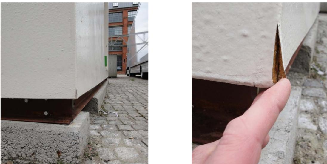
**Abbildung 38** Schaden an der Gebäudeecke
