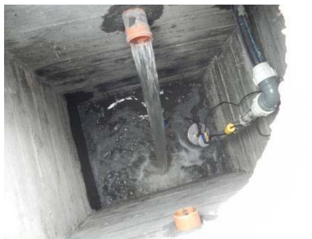
Bild 16: Inbetriebnahme des Pumpenschachtes
