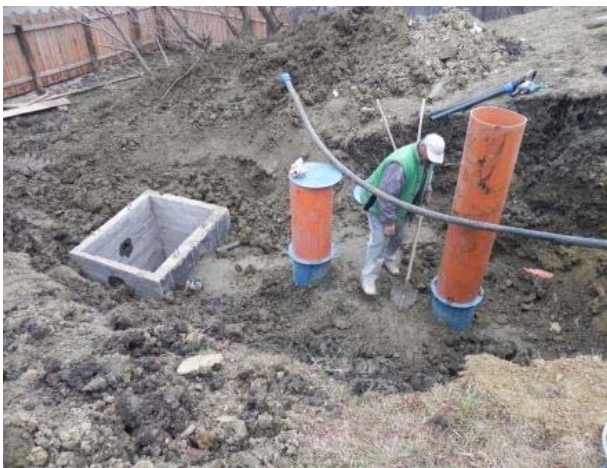
Bild 13: Lagenweise Verfüllen von Erdreich über Pumpenschacht und eingebaute Vorklärung
