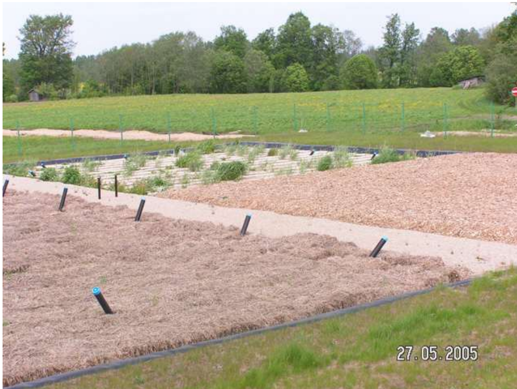
Fig. 4: Pat filtrant cu scurgere verticală din localitatea Tinuzi de lângă orașul Ikșșile; în stânga acoperire cu paie, în dreapta cu așchii de lemn.
