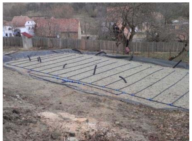
Bild 10: Fertig gestellter Bodenfilter vor Einzäunung und Bepflanzung
