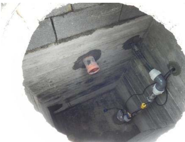
Bild 15: Blick in das Innere des Pumpenschachtes
