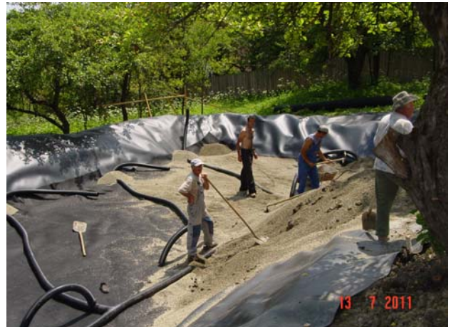
Bild 6: Lagenweise Einbringen der Filterschichten in das mit PE-Folie und Geotextil ausgelegte Becken
