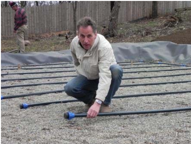
Bild 7: Verlegen und Ausrichten der Beschickungsröhre
