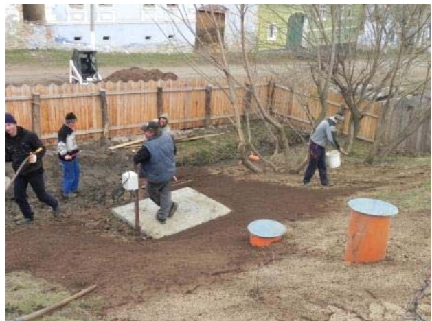
Bild 14: Abschließendes Herrichten des Geländes
