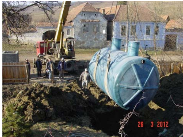
Bild 12: Einheben der Vorklärung
