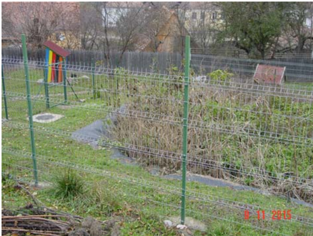
Bild 17: Blick auf den Bodenfilter links im Bild der Kontrollschacht am Filterausgang.
