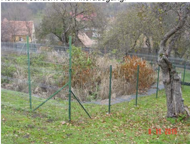
Bild 19: Blick auf auf den Bodenfilter. Dichter Bewuchs auf dem gesamten Filter
