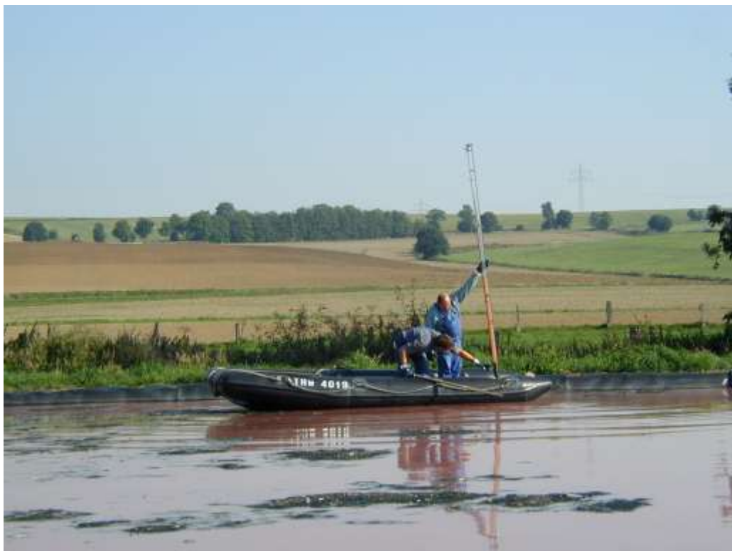
Abb. 6: Schlammmessung in einem vorschalteten Abwasserteich
