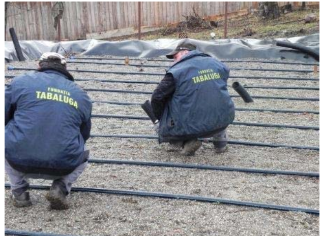
Bild 8: Bohren der Beschickungsöffnungen
