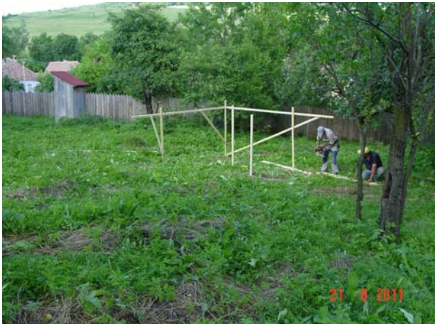
Bild 5: Abstecken des Filterbeckens auf dem Gelände des Kinderferienheims
