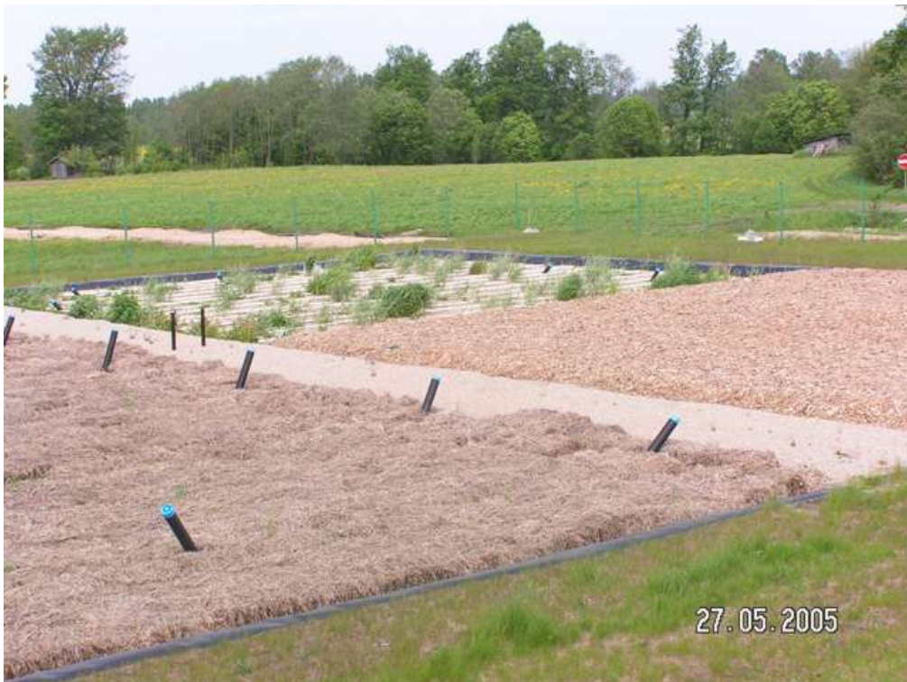
Abb. 4: Vertikaler Bodenfilter Tinuzi, Stadt Ikskile, links Abdeckung mit Strohballen, rechts Abdeckung mit Holzschnitzel.
