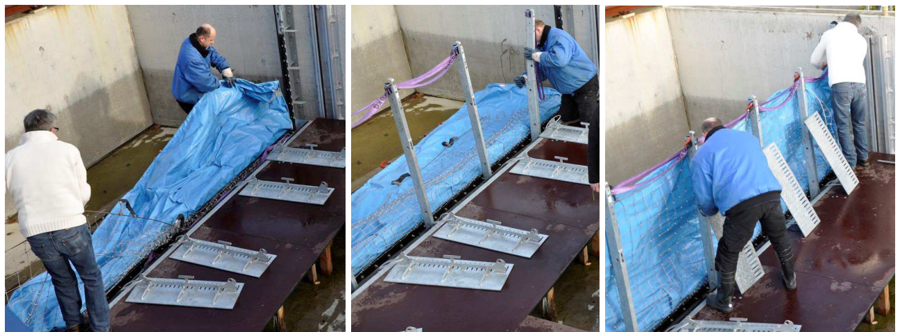
Bilder Aufbau der AquaWand
