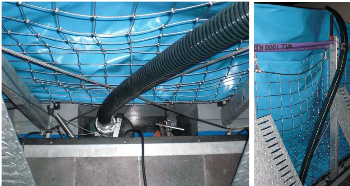
Abbildung 23: Die Pumpe ist im Schacht und der Schlauch an den Pfosten gehängt
