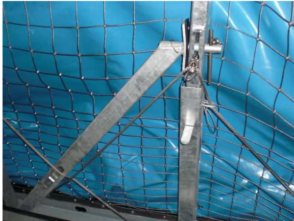
Abbildung 22: Die Pfostenverstärkung
