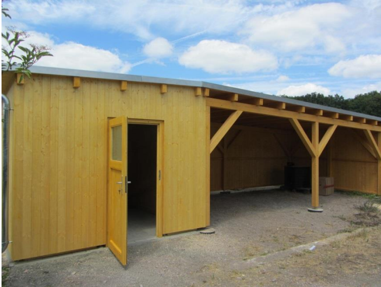
Abbildung 6-8: Ausstellungsfläche und mobiler Schauraum nach Fertigstellung (ohne Anlagen)
