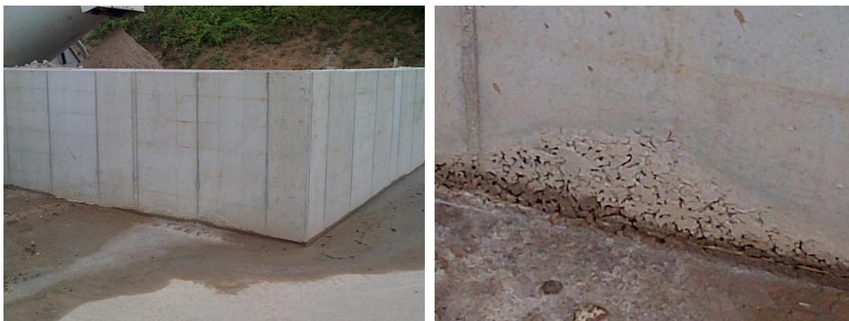
Bild 49 Ansicht der ausgeschalteten Wand
