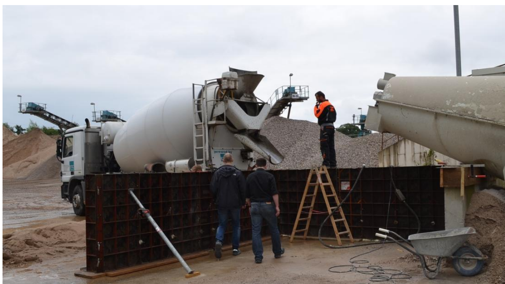
Bild 48 Schalung auf dem Gelände des Transportbetonwerks Niederkassel
