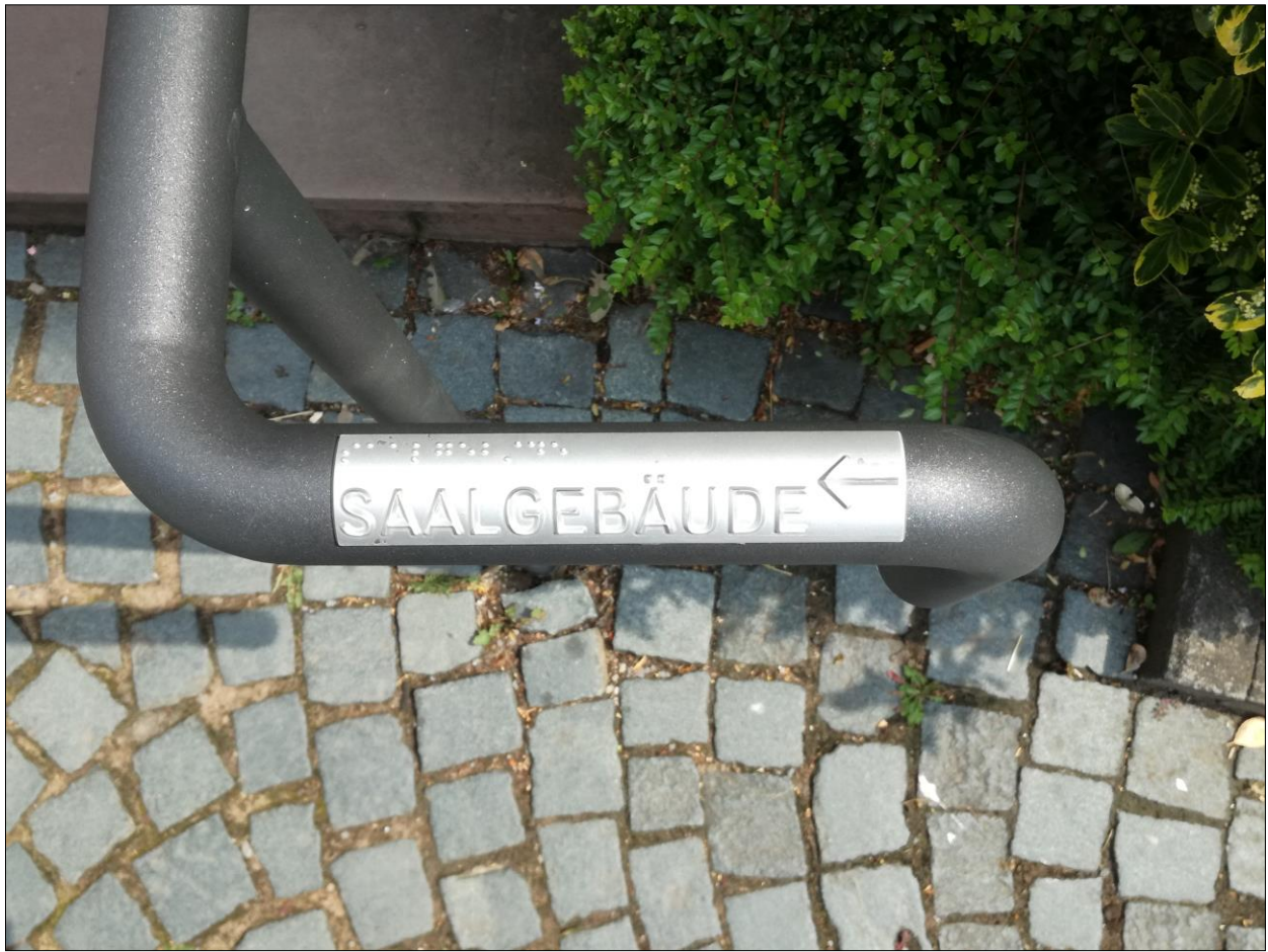
Bild 47: Barrierefreier Handlauf am Eingang Saalgebäude, mit Beschriftung, AB Haase
