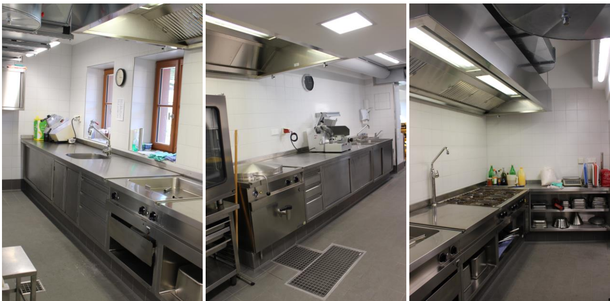
Bild 2, 3 und 4: Neu errichtete Versorgungsküche
