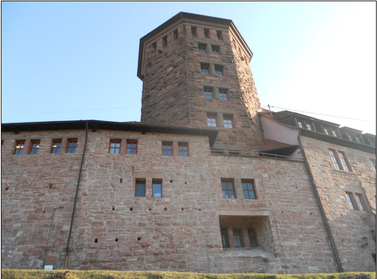
Bild 8 Westlicher Bergfried und Burgmauerflügel mit Umbauten von 1930, AB Haase
