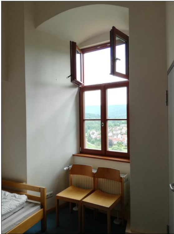
Bild 30: Fenster und Fensternische F146 im Zimmer „Madrid“ nach der Erneuerung, AB Haase
