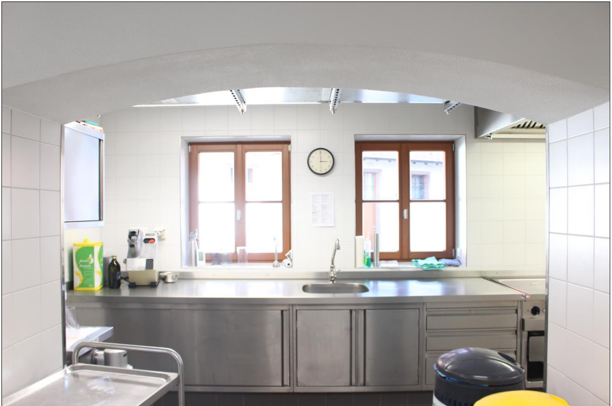
Bild 31: Blick auf die hofseitigen neuen Küchenfenster, AB Haase
