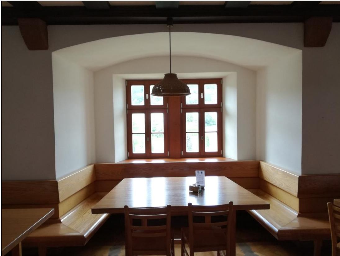
Bild 49: Energetisch optimierte Fensternische mit denkmalgerechten Fenstern im Speisesaal, AB Haase
