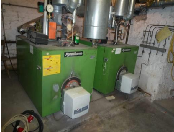
Bild 12 und Bild 13: alte Heizungsanlage
