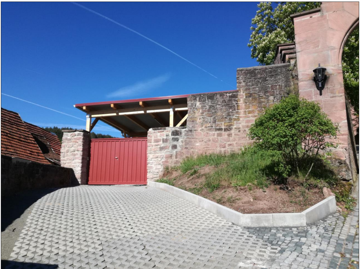
Bild 42: Blick auf die wiederhergestellte Lagerhallenzufahrt und das neue Tor, AB Haase
