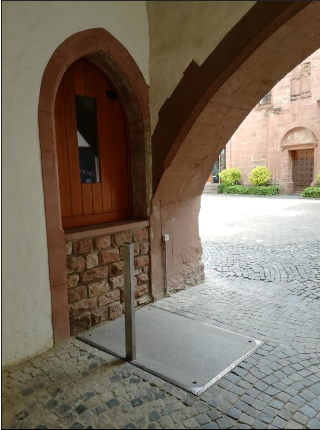
Bild 46: Der überfahrbare, rollstuhlgerechte Plattformlift zum Speisesaal, AB Haase
