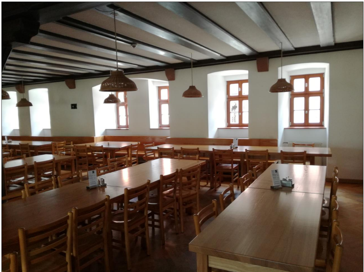
Bild 28: Der Speisesaal nach Fensteraustausch und Dämmung der Fensternischen, AB Haase
