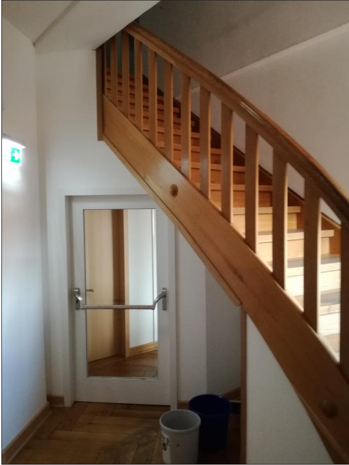
Bild 44: Neue Trennwand zwischen Flur und Treppenhaus im DG, Bt. E, mit Tür T30-RS, AB Haase
