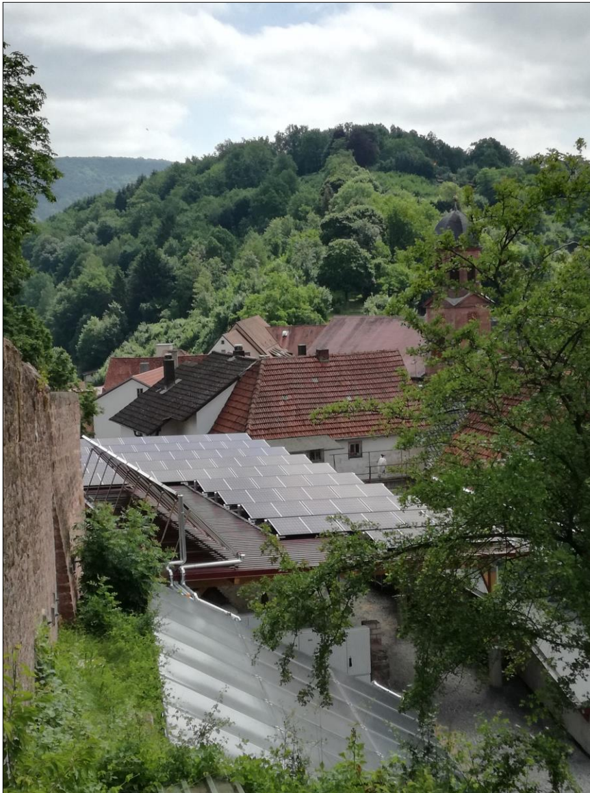
Bild 23: Die Photovoltaik-Anlage auf dem Dach der Lagerhalle, AB Haase
