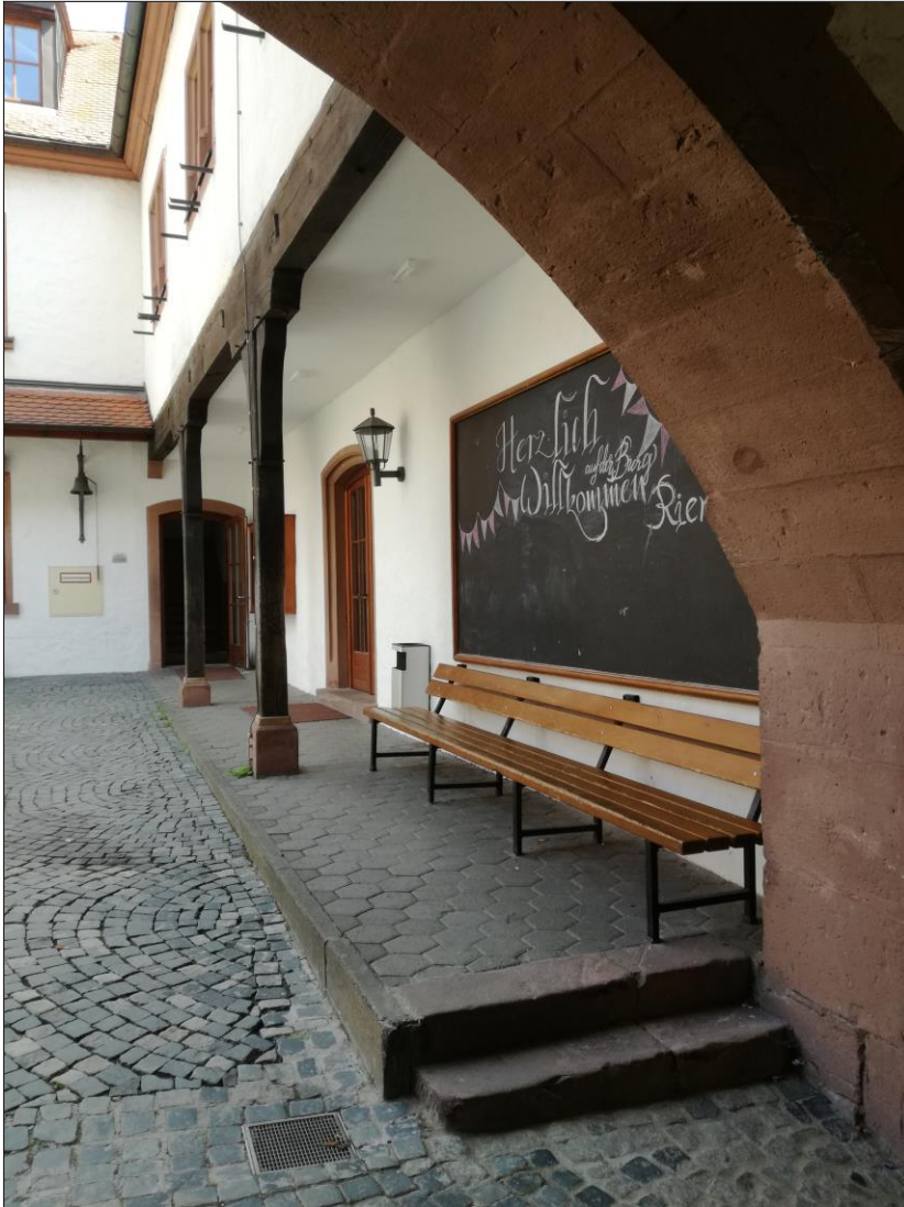
Bild 32: Die gedämmte Unterseite des Flurs im Obergeschoss von Bt. D, AB Haase
