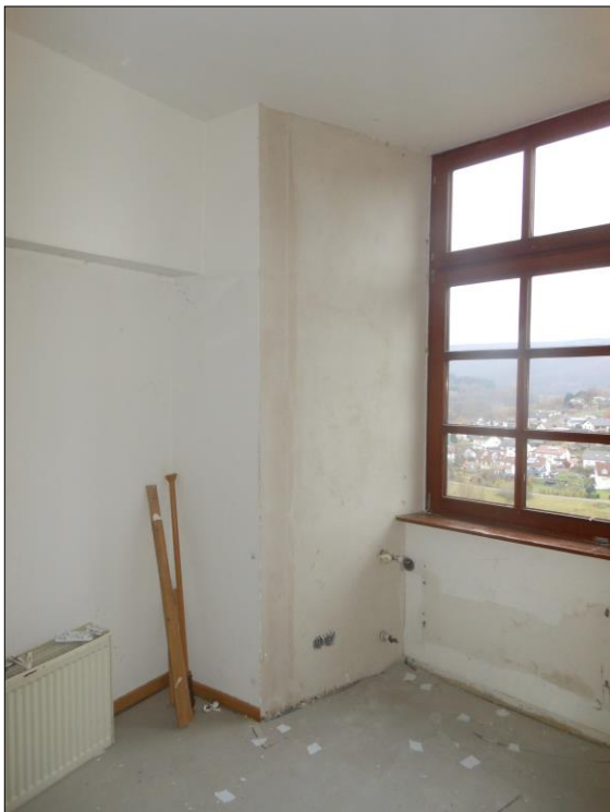
Bild 29: Fenster und Fensternische F146 im Zimmer „Madrid“ in der Bauphase vor der Erneuerung, AB Haase
