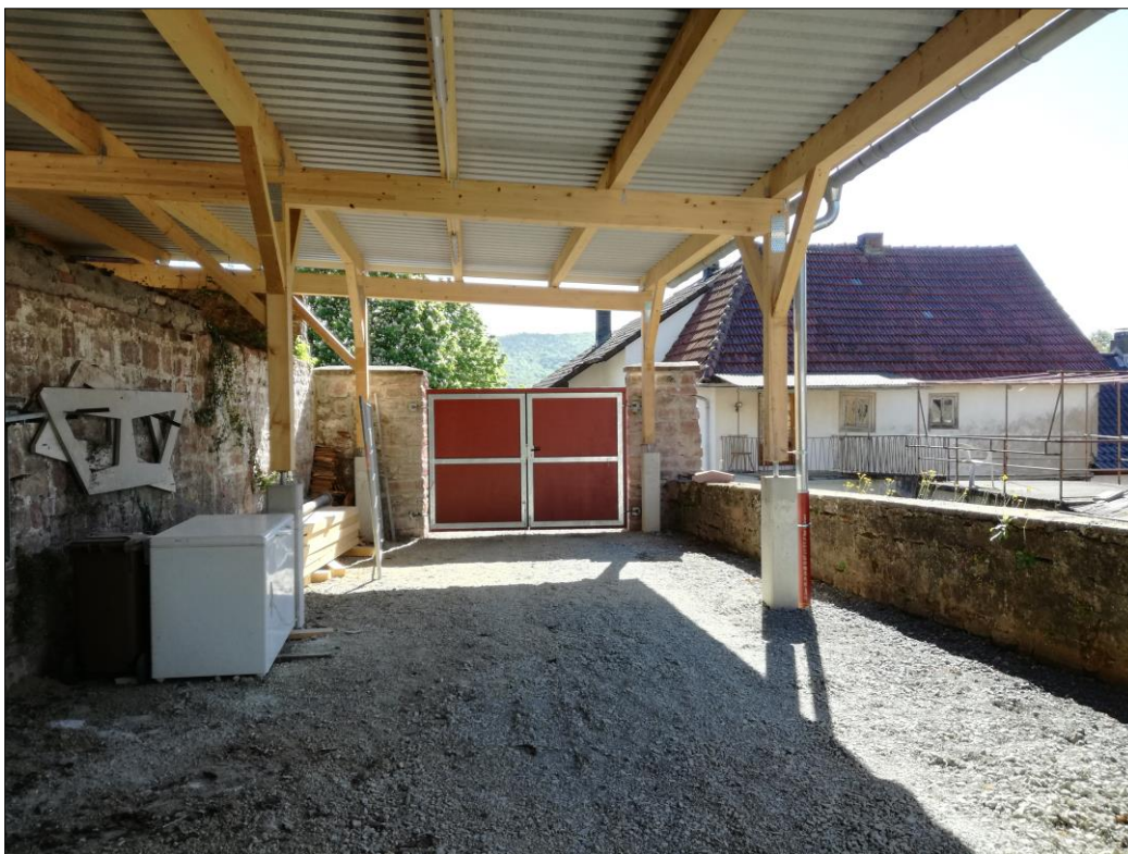
Bild 41: Die neue Lagerhalle. Blick nach Süden, AB Haase
