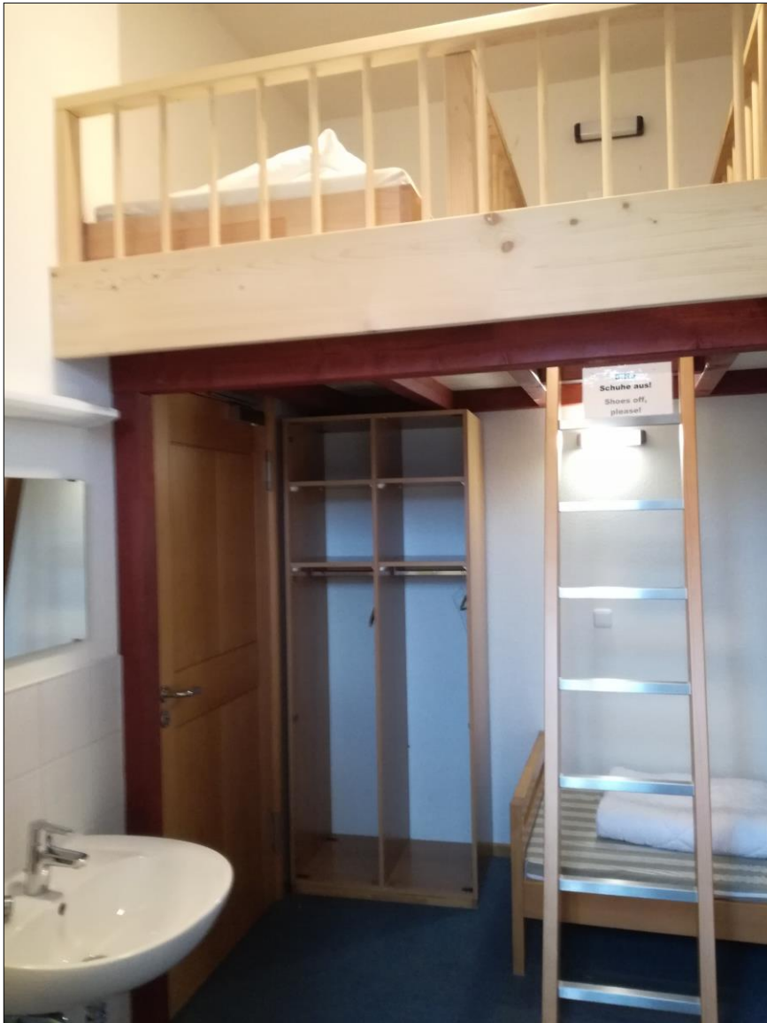
Bild 38: Neue Schlafempore im Zimmer „Madrid“ und Waschbecken im Raum vor der neuen Sanitärzelle, AB Haase
