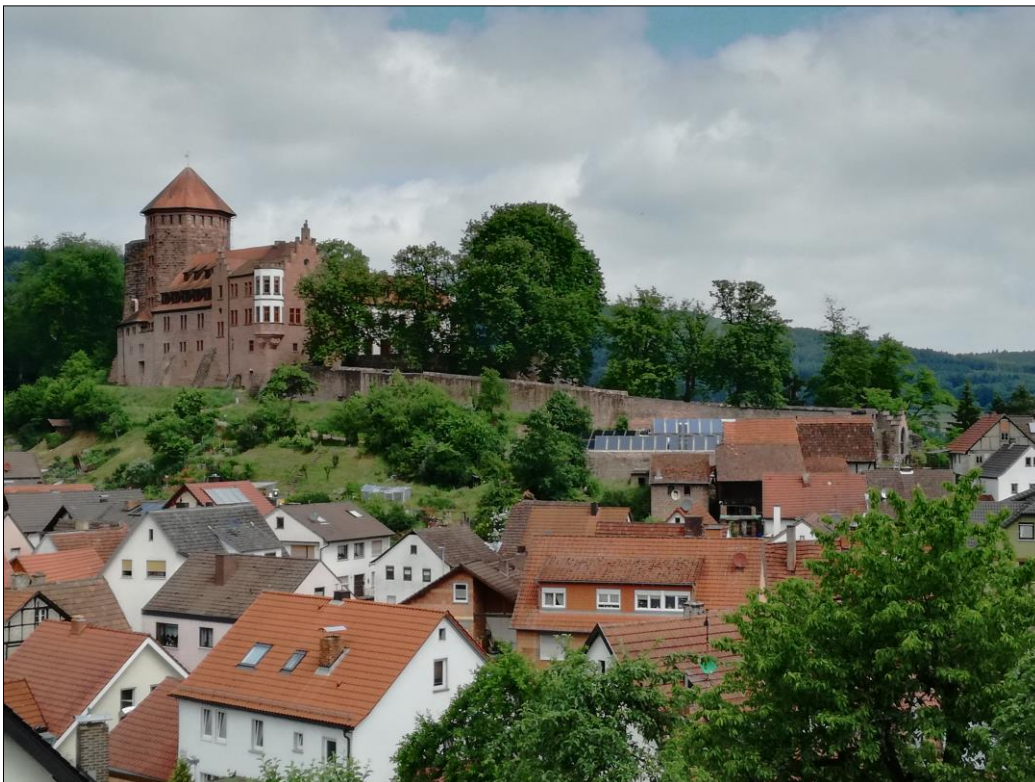
Bild 51: Blick über das Tal auf Burg Rieneck mit der neuen Heizzentrale , PV und Solarthermie, AB Haase
