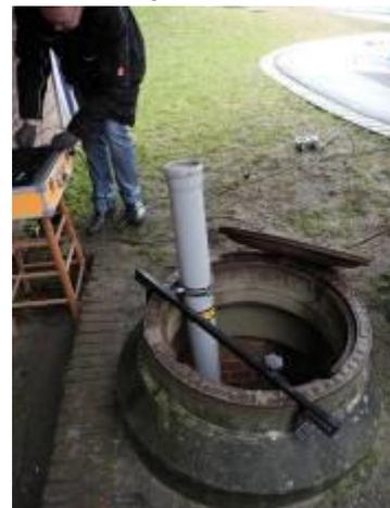
Bild 76: HT-Rohr als Einführhilfe für die die Schwenkkopfkamera mit Abbiegemodul
