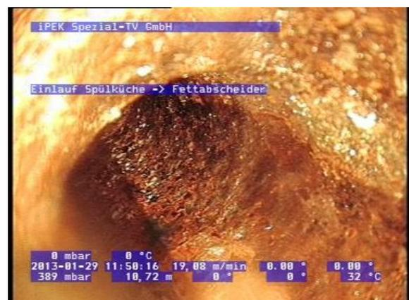
Bild 22: Ratskeller Osnabrück, Ergebnisse der Zustandserfassung: Bild links oben: Querrisse in Steinzeug-Rohr DN 150. Bild rechts oben: starke Korrosion im Gussrohr
