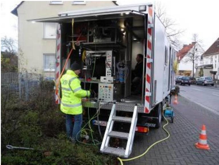
Bild 52: Einbringen der Kamera über einen Revisionsschacht am Übergabepunkt zur öffentlichen Kanalisation.
