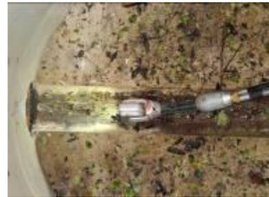
Bild 53: Lindauer Schere im Revisionsschacht. Rechts ist die angeflanschte Hochdruckdüse mit dem zusätzlichen Spülschlauch erkennbar.
