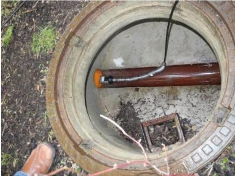
Bild 73: Einbringen der Kamera über Revisionschacht und händischer Vorschub
