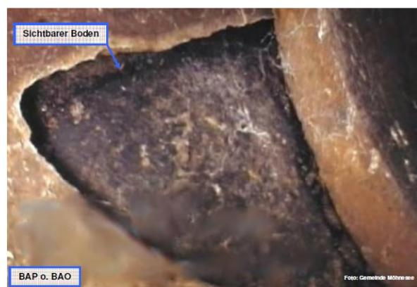
Bild 98: Beispiele von Schadensbilder aus dem Bildreferenzkatalog **Links:** Einragendes Dichtungsmaterial. **Rechts:** Hohlraum, Boden sichtbar. []
