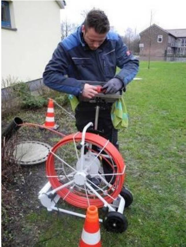
Bild 45: Montage des Bedienpults Visioncontrol vor der Inspektion des Entwässerungsnetzes unter der Turnhalle der Heiligenwegschule.
