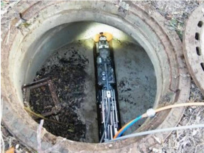
Bild 31: Inspektionsroboter mit Vorschubeinheit im Revisionsschacht
