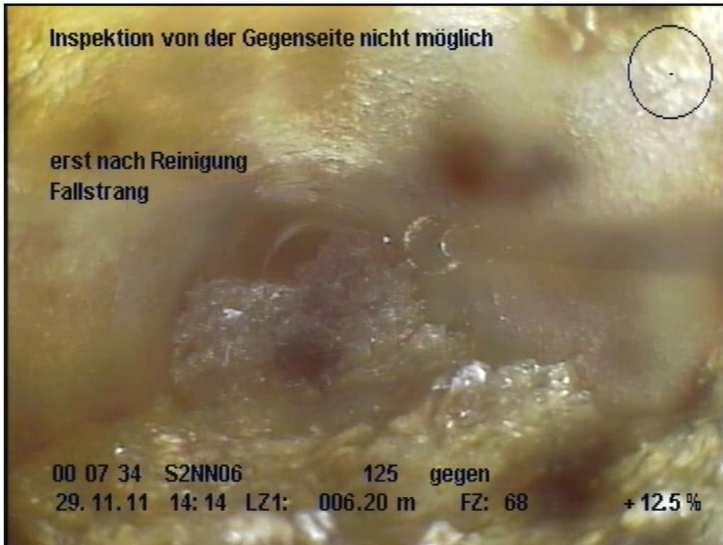
Bild 28: Heiligenwegschule, Osnabrück: Entwässerungsnetz unterhalb des Schulgebäudes aus dem Jahr 1954. Ablagerungen am Ende einer Fallleitung vorhanden. Position im Entwässerungsnetz vgl. Bild 27.
