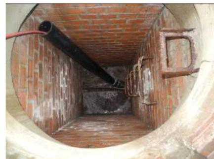
Bild 51: Einführhilfe für die AGILIOS an den Standorten Turnhalle (links) und Schulgebäude. Durch die Nutzung der Einführhilfen wird das Vorschieben der Inspektionseinheit erleichtert. Ein Einstieg in den Revisionschacht ist nicht notwendig.
