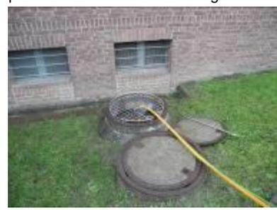
Bild 58: Arbeitssicherheit: Abdeckung des Schachts mit einem Gitter.
