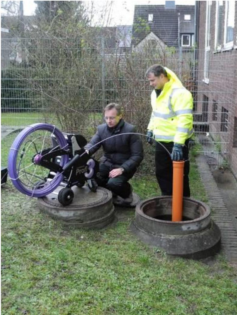
Bild 59: Einbringen der Kamera über Revisionsschacht und händischer Vorschub
