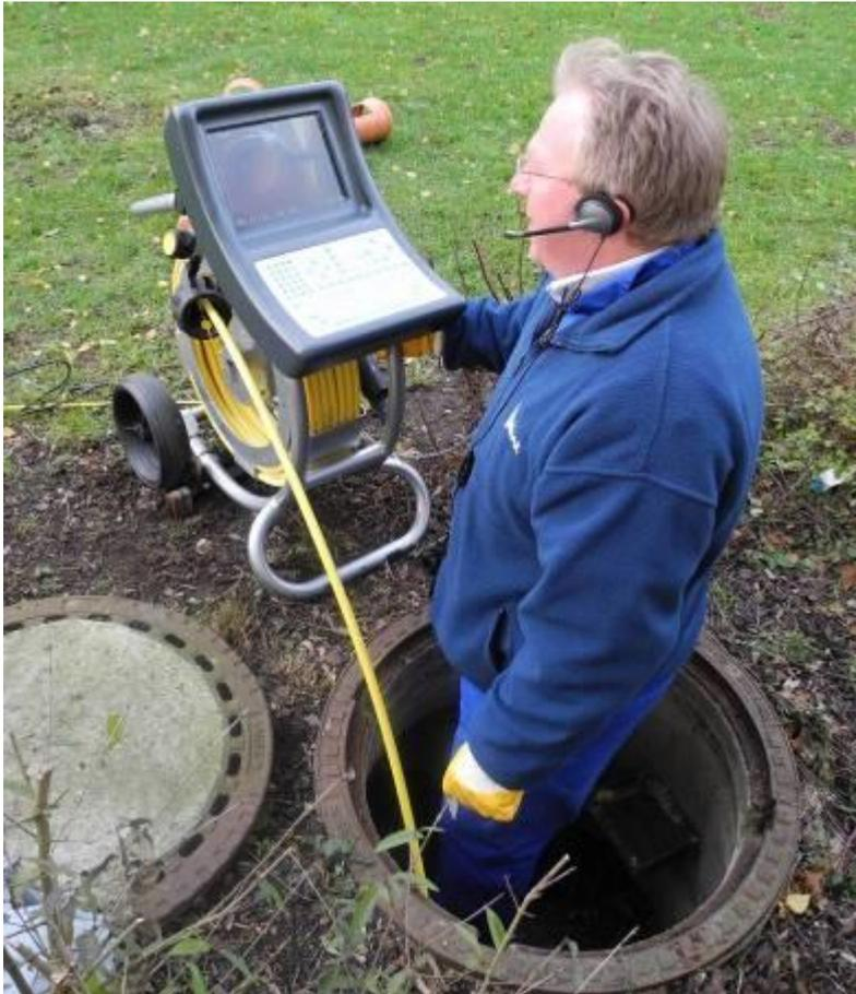
Bild 38: Einbringen der Kamera über Revisionsschacht und händischer Vorschub
