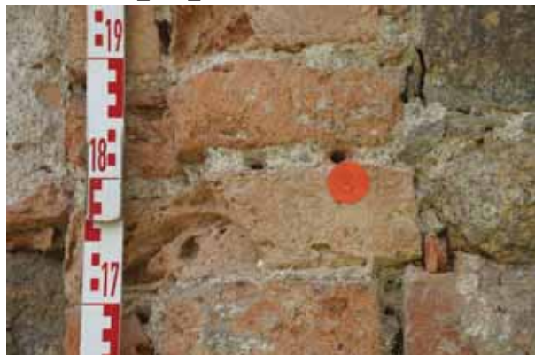
Abb. 6 Beamtenhaus, Giebel, Pilaster, Tiefenprofil MKG_TP1_3/
