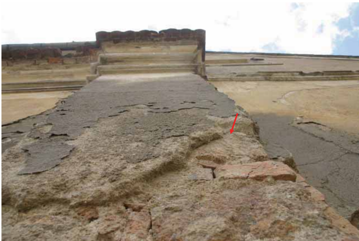
Abb. 9 Beamtenhaus, Giebel, Pilaster, Probenahmepunkt M_KG_M1
