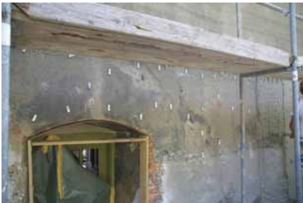
Abb. 63 Beamtenhaus, Nordwestfassade, Sicherung barocker Putzoberflächen, Aufnahme am 25.08.2010
