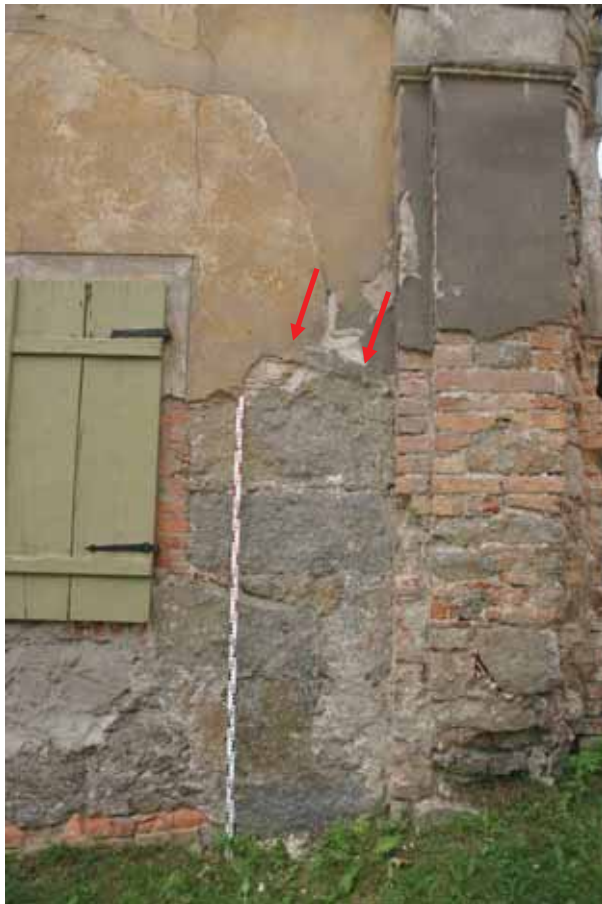
Abb. 34 Beamtenhaus, Probenahmepunkte M_KG_M2 (links) und M_KG_M4 (rechts)
