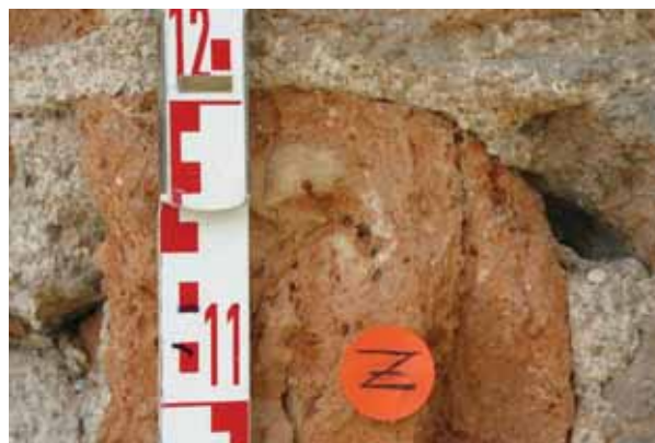
Abb. 30 Beamtenhaus, Giebel, Pilaster, Tiefenprofil MKG_TP2_Z (Ziegel)
