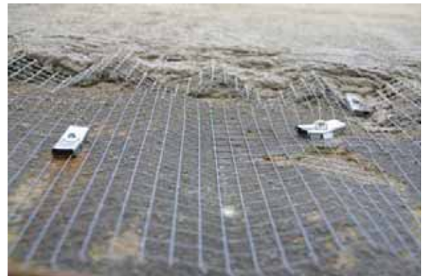
Abb. 64 Beamtenhaus, Nordwestfassade, Sicherung barocker Putzoberflächen, Aufnahme am 25.08.2010
