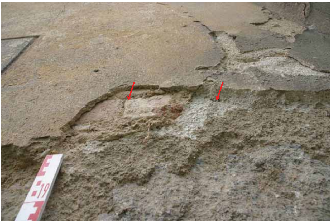
Abb. 35 Beamtenhaus, Giebel, Probenahmepunkte M_KG_M2 (links) und M_KG_M4 (rechts)
