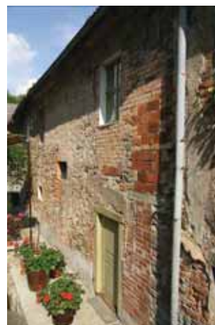
Abb. 9 Haupthaus, Nordwestfassade linker Bereich, 25.06.2010
