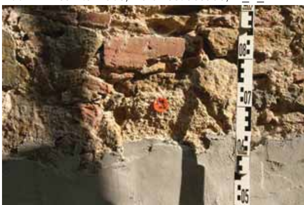
Abb. 23 Beamtenhaus, Nordwestfassade, M_K_M2
