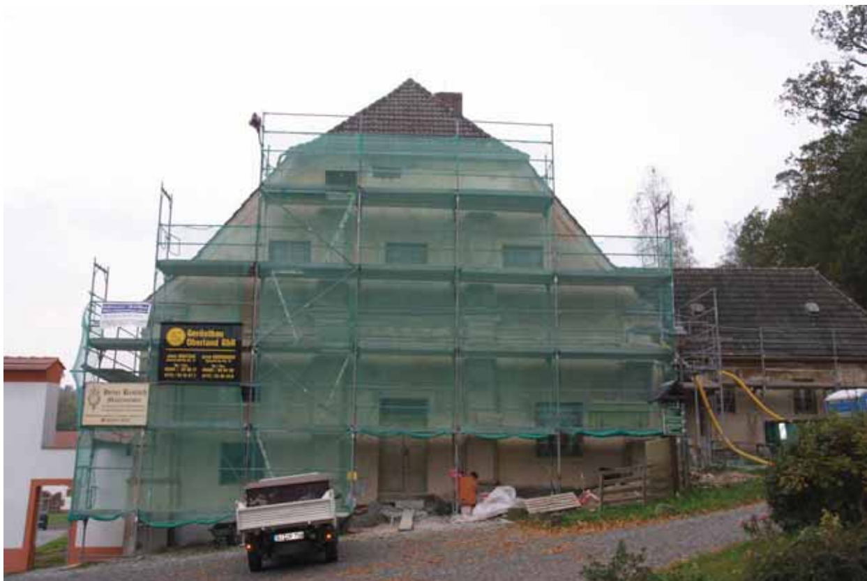
Abb. 69 Beamtenhaus, Giebel, Restaurierung des Giebelbereichs
