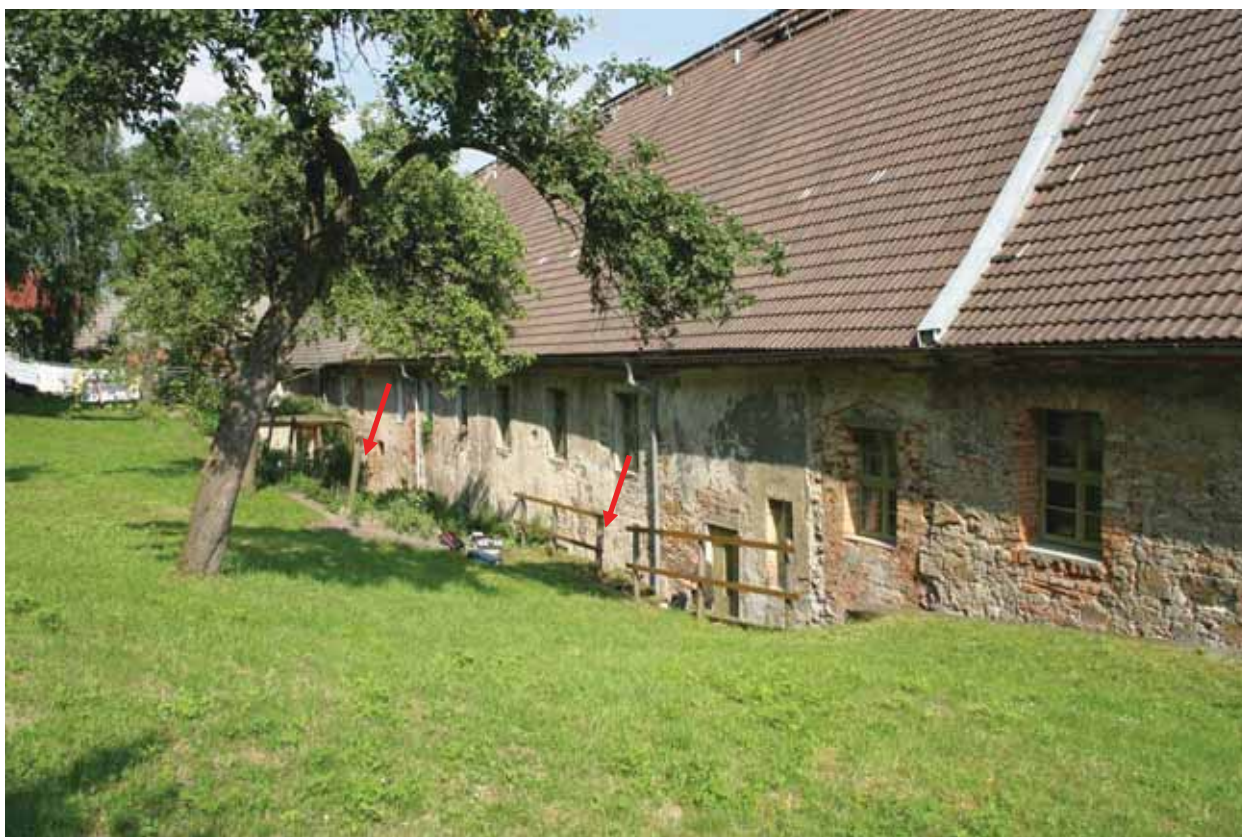
Abb. 7 Beamtenhaus, Nordwestfassade, Probenahmepunkte M_K_TP3 und M_K_TP4
