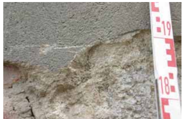
Abb. 60 Beamtenhaus, Giebel, Materialwechsel Zementmörtel (links) / Kalkmörtel (rechts)
