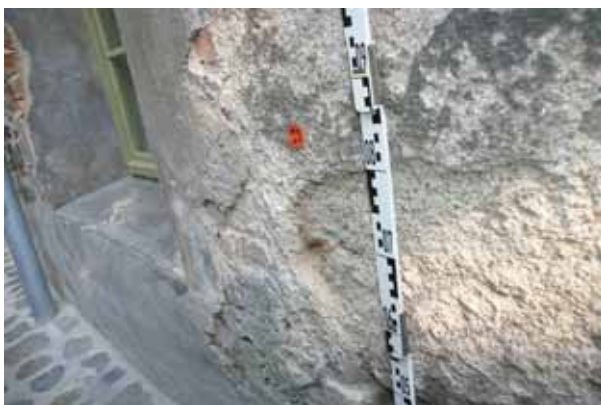
Abb. 21 Beamtenhaus, Nordwestfassade, M_K_M1
