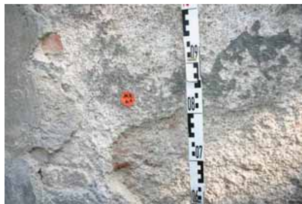
Abb. 11 Beamtenhaus, Nordwestfassade, M_K_M1
