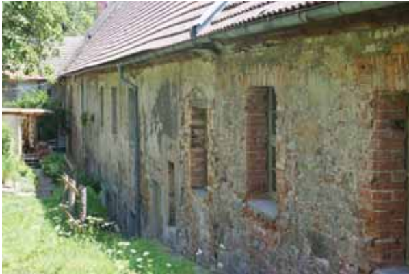
Abb. 61 Beamtenhaus, Nordwestfassade vor der energetischen Sanierung, Aufnahme am 21.07.2010
