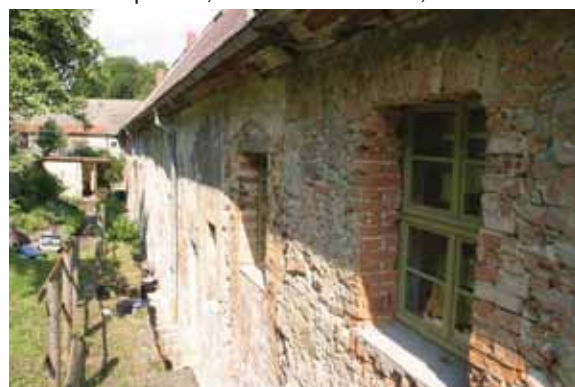
Abb. 7 Haupthaus, Nordwestfassade mittlerer Bereich, 25.06.2010
