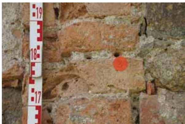
Abb. 29 Beamtenhaus, Giebel, Pilaster, Tiefenprofil MKG_TP1_3/
