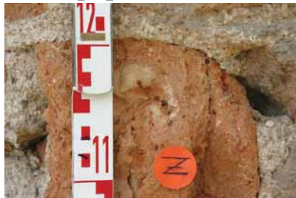
Abb. 7 Beamtenhaus, Giebel, Pilaster, Tiefenprofil MKG_TP2_Z (Ziegel)
