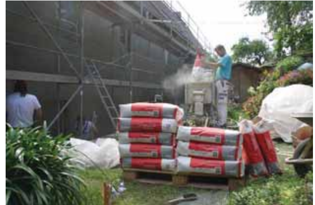
Abb. 62 Beamtenhaus, Nordwestfassade, Putzarbeiten, Aufnahme am 25.08.2010
