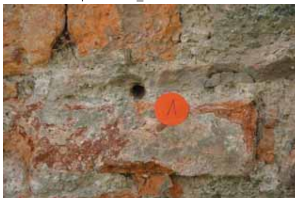
Abb. 27 Beamtenhaus, Giebel, Pilaster, Tiefenprofil MKG_TP1_1/
