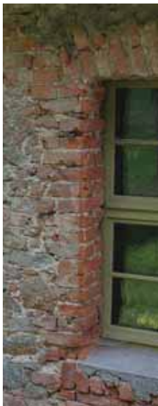
Abbildung 3 Fensterlaibung der rückwärtigen Wand
