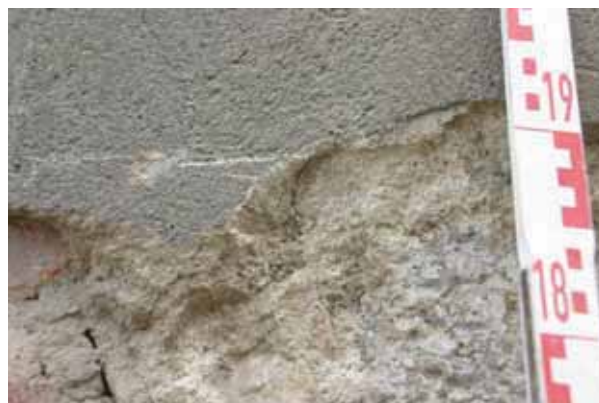
Abb. 27 Beamtenhaus, Giebel, Materialwechsel Zementmörtel (links) / Kalkmörtel (rechts)
