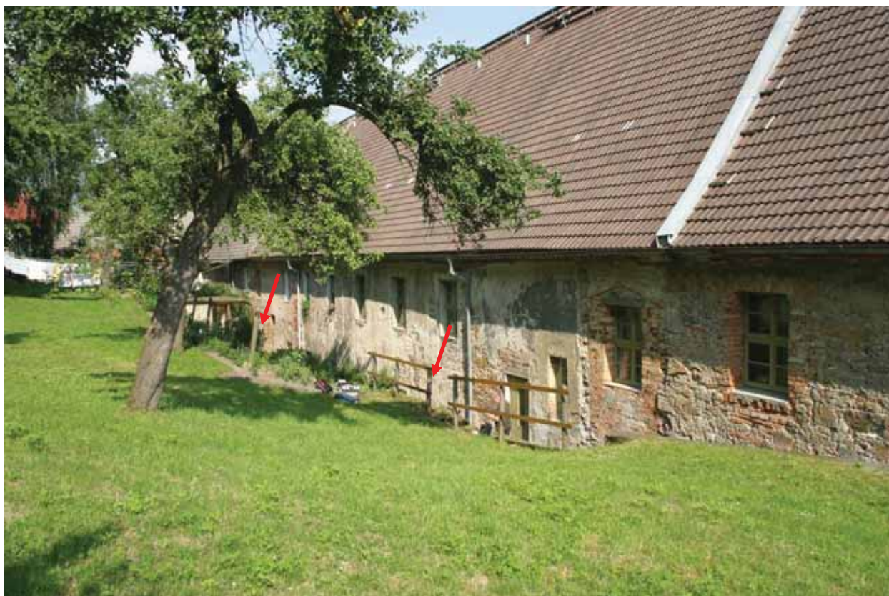
Abb. 18 Beamtenhaus, Nordwestfassade, Probenahmepunkte M_K_TP3 und M_K_TP4
