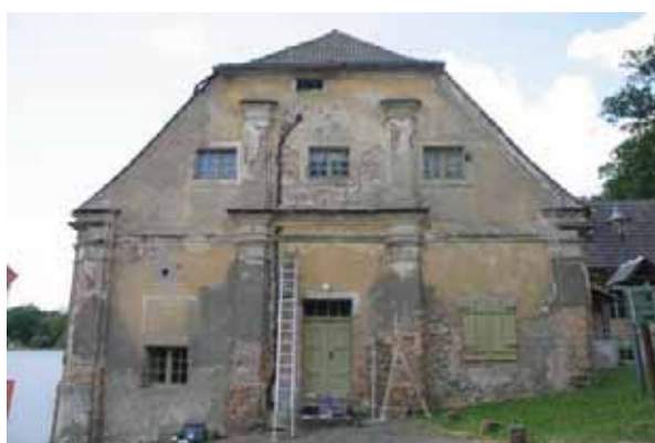
Abb. 70 Beamtenhaus, Schmuckgiebel vor der Restaurierung (07.07.2010)
