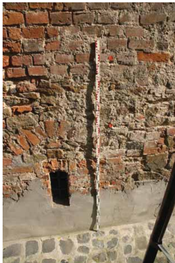
Abb. 20 Beamtenhaus, Nordwestfassade, M_K_TP4
