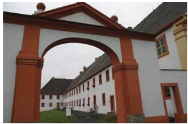
Abb. 68 Beamtenhaus, Hoffassade nach der Restaurierung
