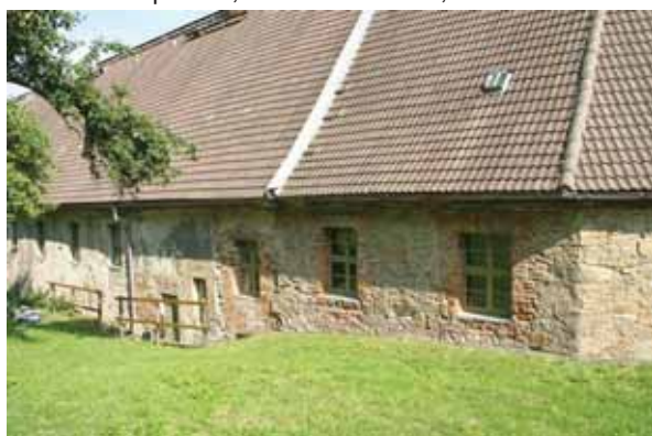
Abb. 6 Haupthaus, Nordwestfassade rechter Bereich, 25.06.2010
