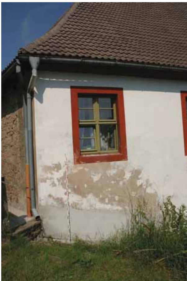
Abb. 5 Beamtenhaus, Südwestfassade, M_K_TP2
