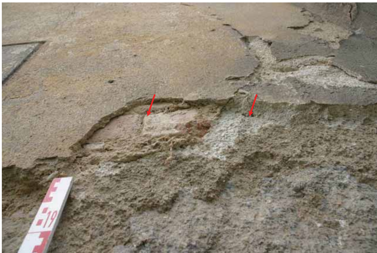
Abb. 12 Beamtenhaus, Giebel, Probenahmepunkte M_KG_M2 (links) und M_KG_M4 (rechts)
