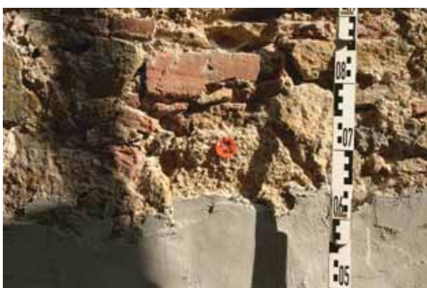
Abb. 12 Beamtenhaus, Nordwestfassade, M_K_M2
