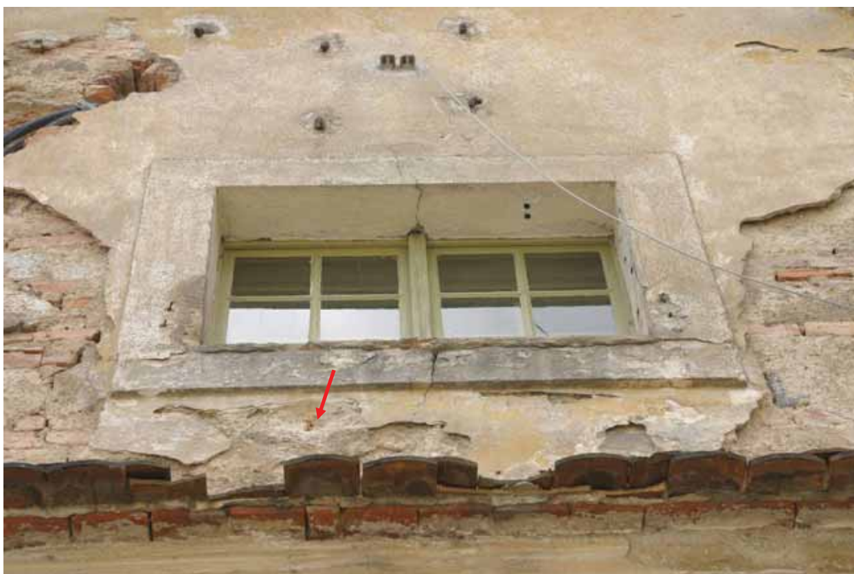
Abb. 31 Beamtenhaus, Giebel, Probenahmepunkt MKG_TP3_F (Fuge)
