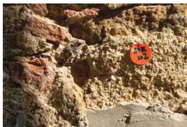
Abb. 13 Beamtenhaus, Nordwestfassade, M_K_M2
