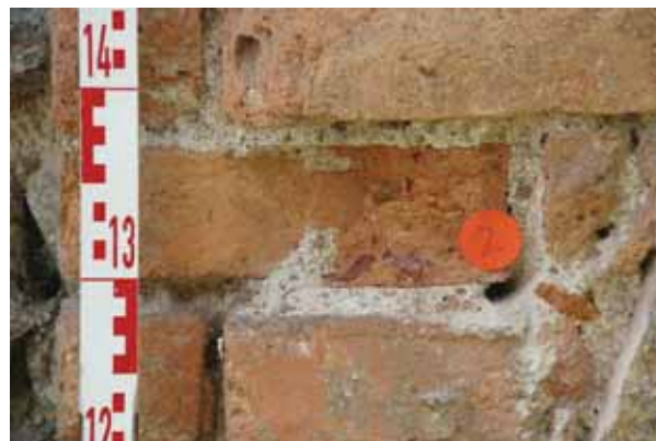
Abb. 5 Beamtenhaus, Giebel, Pilaster, Tiefenprofil MKG_TP1_2/
