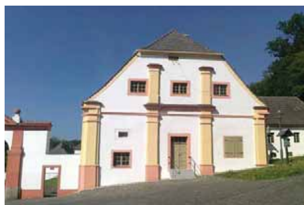
Abb. 71 Beamtenhaus, Schmuckgiebel nach der Restaurierung (18.05.2011)
