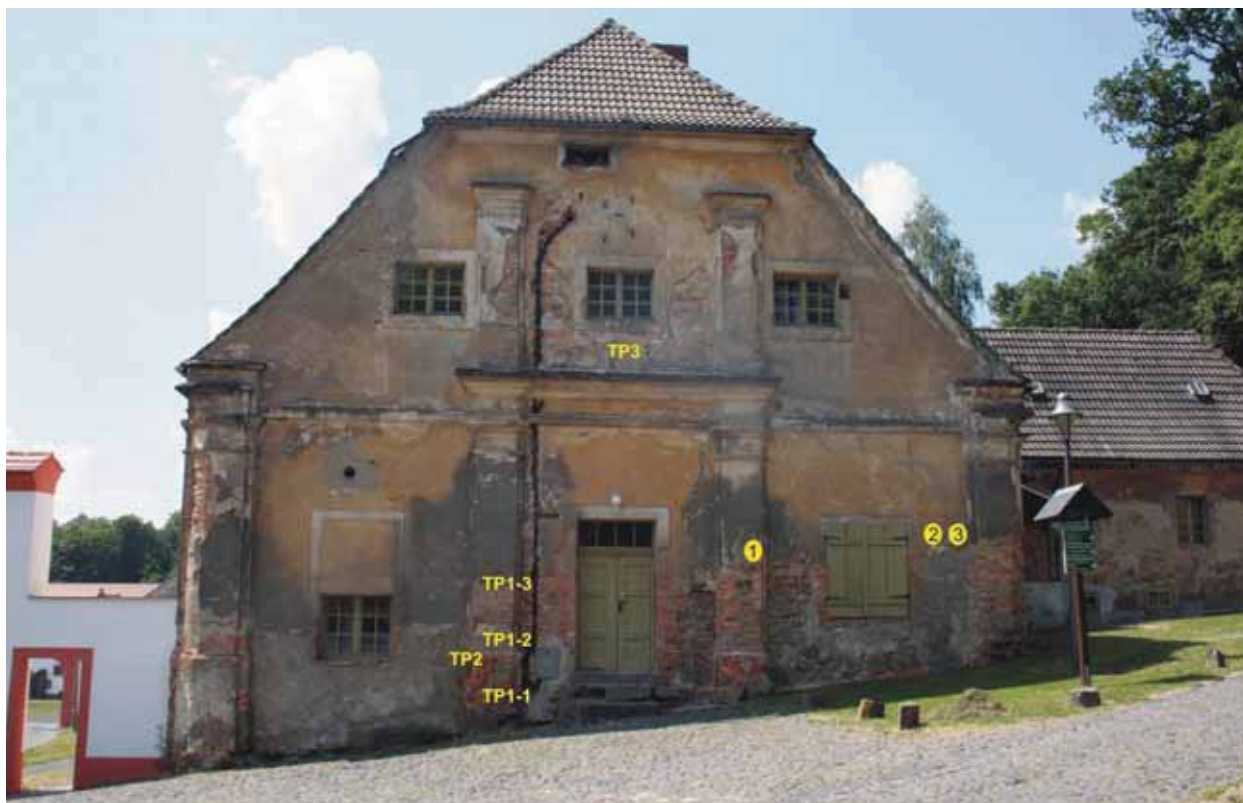
Abb. 2 Beamtenhaus, Giebel, Übersicht der Probenahmepunkte
