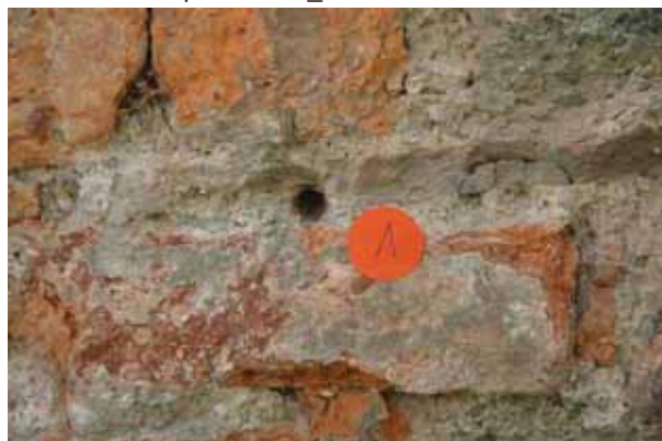
Abb. 4 Beamtenhaus, Giebel, Pilaster, Tiefenprofil MKG_TP1_1/
