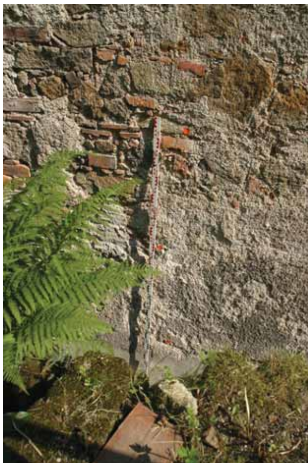
Abb. 19 Beamtenhaus, Nordwestfassade, M_K_TP3
