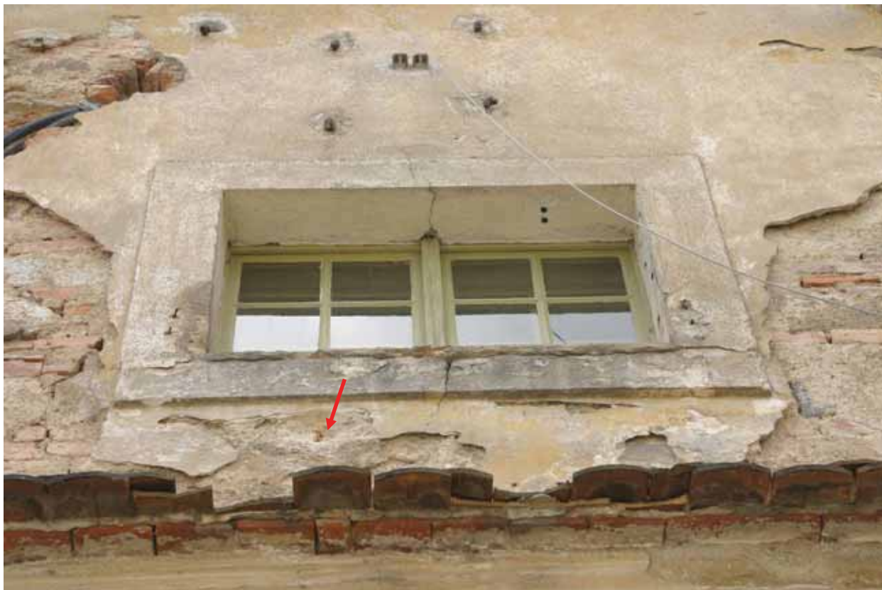
Abb. 8 Beamtenhaus, Giebel, Probenahmepunkt MKG_TP3_F (Fuge)
