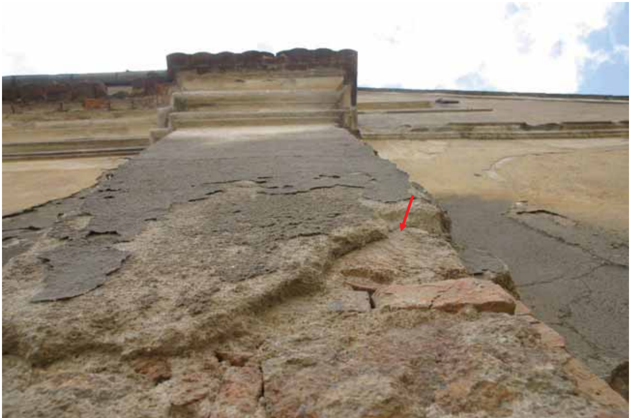
Abb. 32 Beamtenhaus, Giebel, Pilaster, Probenahmepunkt M_KG_M1
