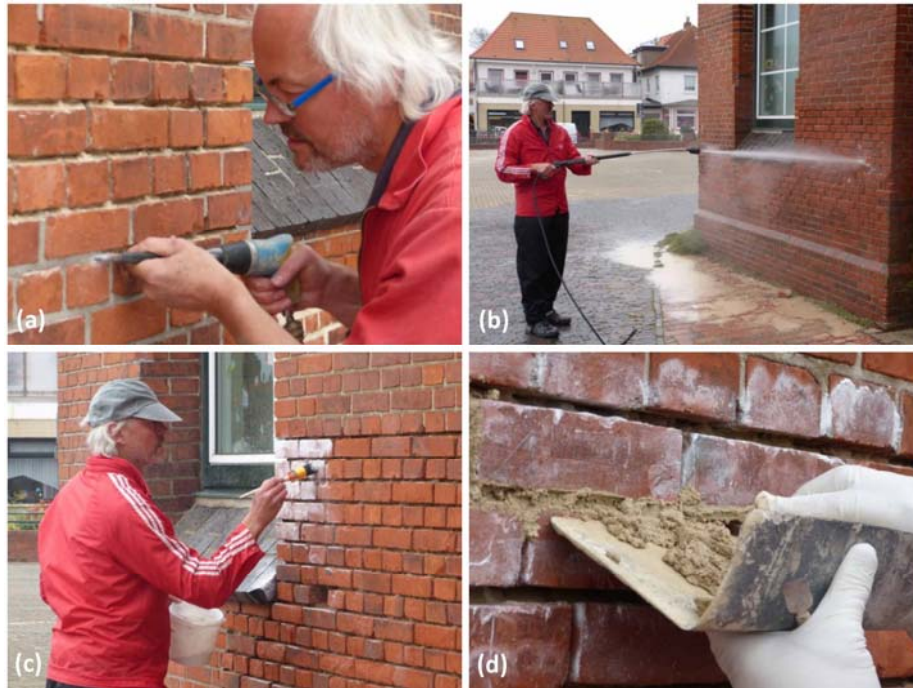
Abb. 57: Musterfläche 3. (a) Fugenausräumen mit Pressluftmeißel; (b) Die Wasserreinigung und Vornässen vor der Mörtelapplikation; (c) Abpudern mit Quarzmehl zur Reduktion randlicher Verunreinigung der Ziegel durch Bindemittelanteile des Salzspeichermörtels; (d) Einbringen des Salzspeichermörtels.
