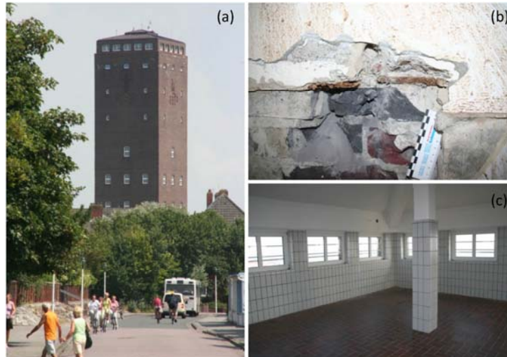
Abb. 84: Wasserturm auf Norderney. (a) Ansicht aus Richtung Jann-Berghaus-Straße; (b) Konstruktionsmerkmal: Auflager der Stahlbetondecke auf Kork; (c) Wandfliesen bilden das Charakteristikum der oberen Stockwerke des Wasserturms.
