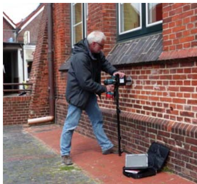
Abb. 12: Einsatz des Bohrwiderstandsmessgerätes an der Westseite der Grundschule Norderney.
