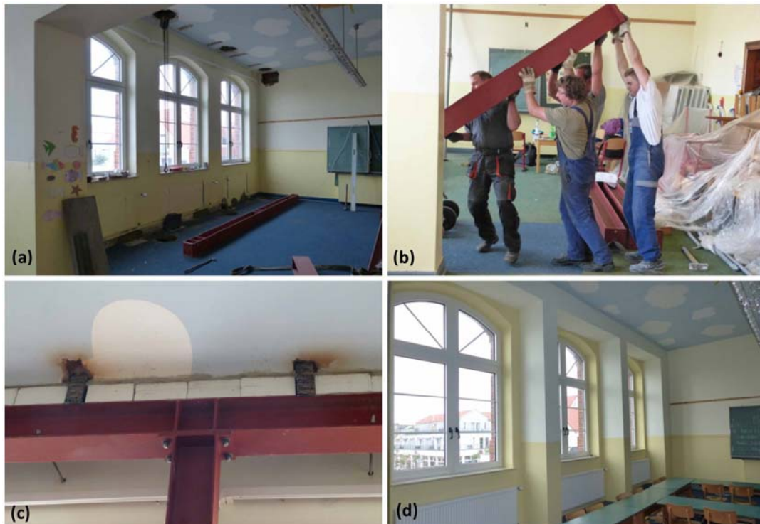
Abb. 49: Herstellung der Innenkonstruktion. (a) für den Aufbau der Stahlträgerkonstruktion vorbereiteter Klassenraum; (b) Aufrichten einer Stahlstütze durch „Manpower“; (c) Detail zur Verankerung der Konstruktion an der Decke und im Mauerwerk; (d) Fertiger Zustand nach Verkleidung der Stahlkonstruktion und Beschichtung.
