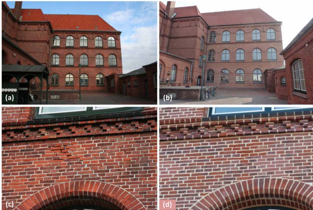
Abb. 45: Bauabschnitt 1 (Westseite des östlichen Gebäudeflügels). (a) Übersicht vor der Instandsetzung; (b) Übersicht nach der Instandsetzung; (c) Detail des Mauerwerkszustandes über dem mittleren Fenster im 1. OG; (d) Detail nach der Instandsetzung.
