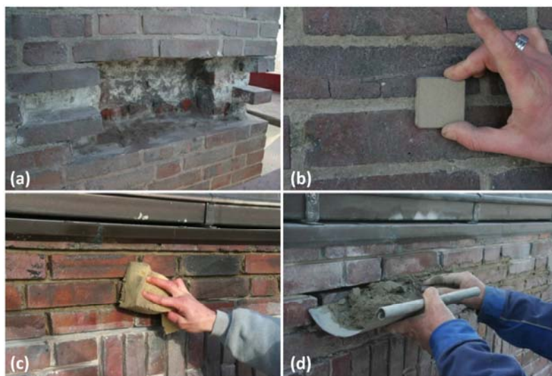
Abb. 99: Arbeitsschritte bei der Instandsetzung. (a) Ausbau geschädigter Hartbrandklinker; (b) Anpassung von Farbton und Struktur des Fugenmörtels; (c) Reinigung mit Schwamm nach Steinersatz; (d) Einbringen des Fugendeckmörtels.
