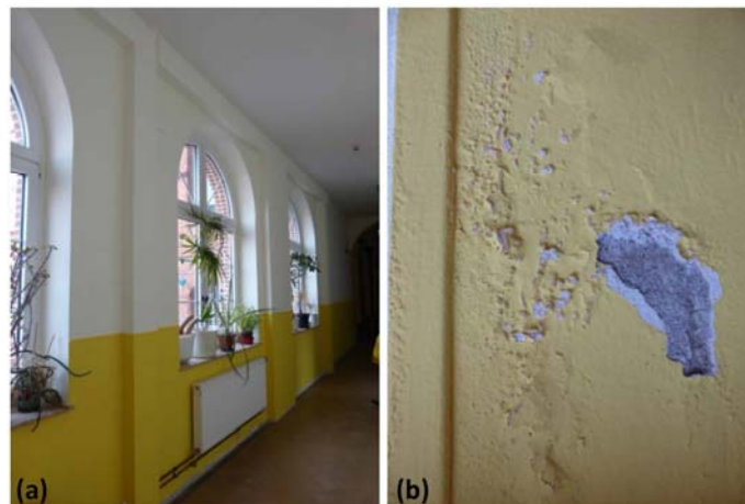
Abb. 50: Fertiggestellte Stahlkonstruktion in den Flur. (a) Geringer dimensionierte Stützen im Flur, (b) erste Schäden entstanden aufgrund des Verzichts auf ein funktionsdifferenziertes Putzsystem.
