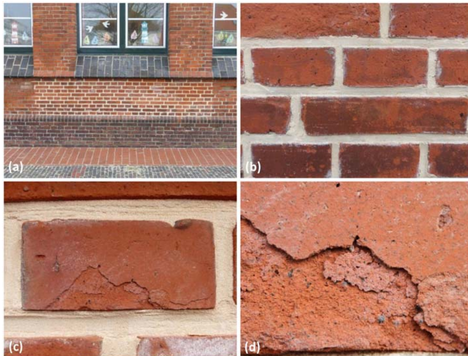
Abb. 53: Musterfläche des Herstellers (Musterfläche 1), Westseite Westflügel, unter zweitem Fenster links von NW-Ecke. (a) Übersichtsaufnahme (16.04.2013) mit partiellen Salzausblühungen; (b) Ausschnittvergrößerung (Fugenoberflächen mit Fugeisen geglättet); (c) Fortschritt der Schalenbildung im Bereich der Musterfläche; (d) Detail: deutlich sichtbare Schuppenbildung unter bzw. am Rand der Schale und Rückständen nach Auflösung der Salze.
