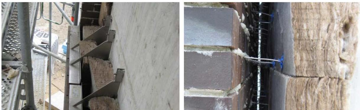
**Bild 14** Einbringung der Mineralwolle-Dämmung (160 mm) zwischen Stahlbetonwand und Ziegelfassade.
