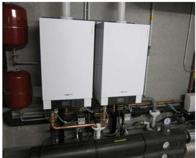
**Bild 24** Heizzentrale mit 1.500 L Pufferspeicher der Wärmepumpe und Anordnung der Abnehmerkreise um den Zortström-Heizverteiler
