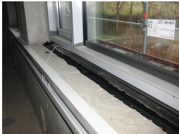
**Bild 16** Fensteranschluss im Innenbereich
