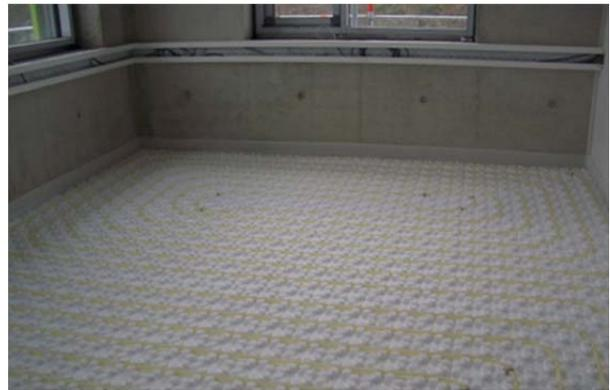
**Bild 18** Verlegearbeiten der Fußbodenheizung in der Bibliothek im Erdgeschoss (links) und fertig verlegte Rohrmäander im 2. Obergeschoss im Eckbüro mit Südausrichtung.
