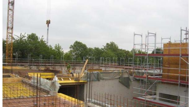
**Bild 17** Rohrmäander der Betonkernaktivierung an Bewehrung (links) (21.06.2011) und Herstellung der Geschosdecke zwischen EG und 1. OG (rechts).
