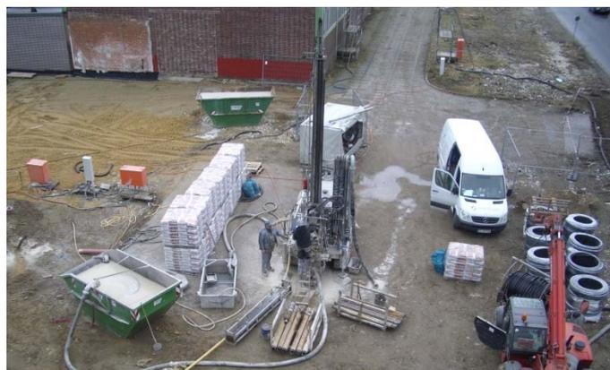
**Bild 19** Bohrarbeiten Erdsonden
