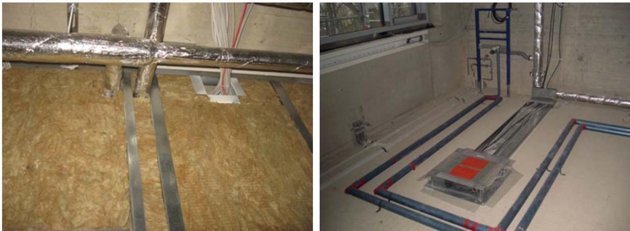
**Bild 21** Dämmung der Innenwände und Rohrleitungen (links); Dämmung der über den Boden geführten Kaltwasserleitung und der Heizungsrohrleitung mit Kompaktdämmhülle (rechts).
