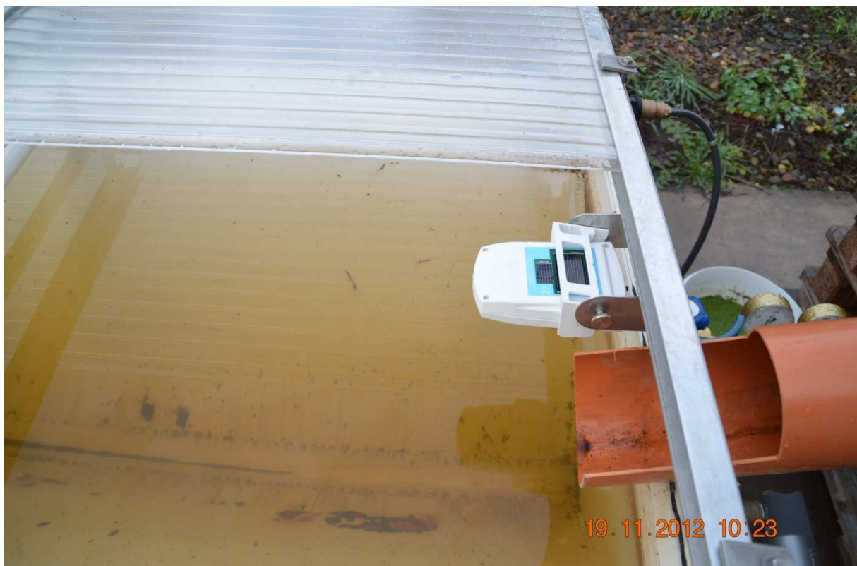
Abb. 9: Rinnenzulauf mit CO 2 -Einspeisung und Solarmessgerät
