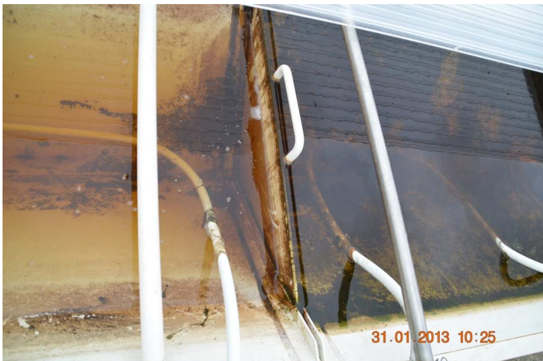
Abb. 7: Der Überlauf am Ablauf der Rinne
