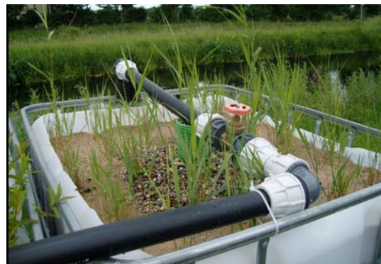
Abbildung 8: Betriebsbereiter Versuchsfilter mit Substraten, Bepflanzung und Beschickungsleitung
