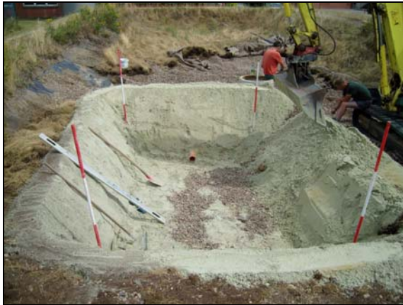
Abbildung 10: Filtermulde vor dem Einlegen der Filterfolie
