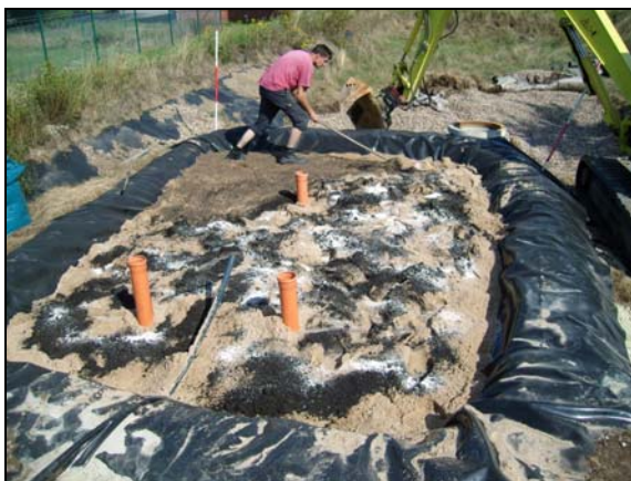
Abbildung 12: Silikatkolloid und Kompost werden oberflächennah gleichmäßig eingeharkt
