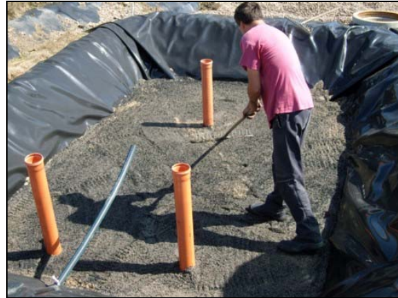
Abbildung 11: schichtweises Einbringen der Pflanzenkohle in das Filtersubstrat
