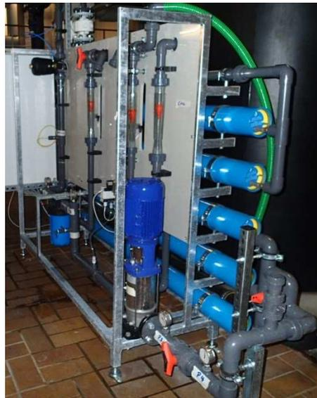
**Abbildung 2. Die großtechnische NF-Anlage im Hallenbad A.**
