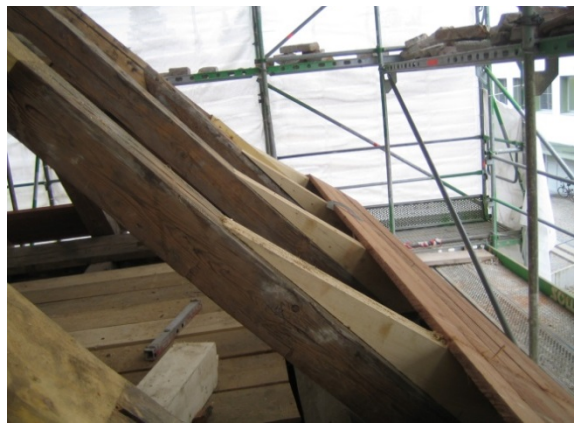
Bild 15: Neuanfertigung der Aufschieblinge und Verschalung des unteren Traufbereichs.
