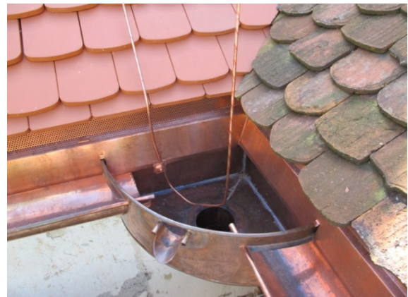
Bild 21: Saier an der Nordwestecke des Kopfbaus.
