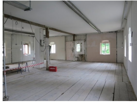
Bild 35: Fertiggestellte Decke im Obergeschoss Kopfbau mit bereits installierten Lüftungsrohren.
