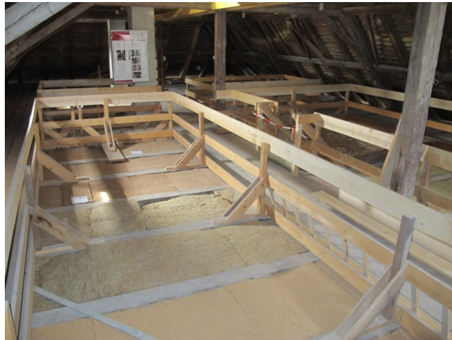
Bild 36: Einbau der unterschiedlichen Materialien als Zwischenbalkendämmung im Dachgeschoss Kopfbau.
