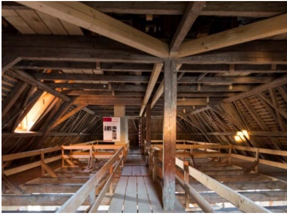
Bild 12: Dachgeschoss des Kopfbaus mit neuen Hölzern zur Längs- und Queraussteifung.
