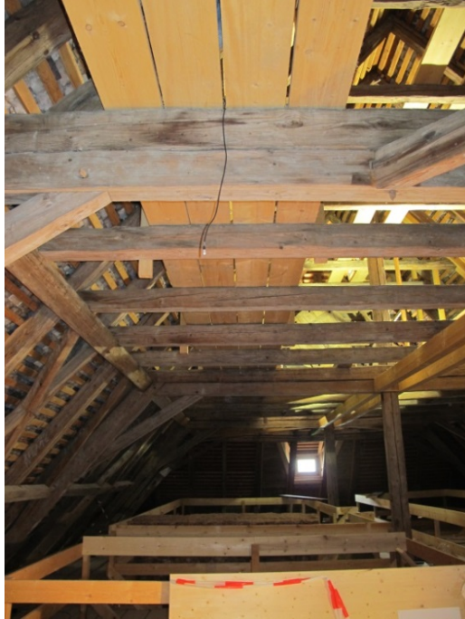
Bild 58: Abgehängter Kombisensor im Westen auf der zweiten Kehlbalkenebene.
