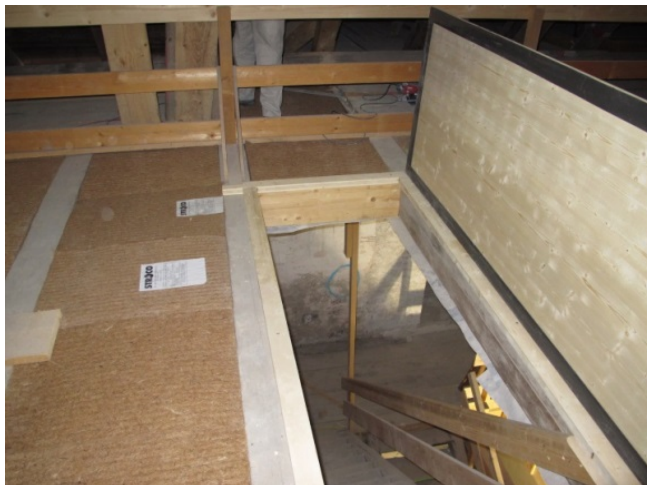
Bild 38: Provisorische Klappe als Deckel der Treppenöffnung ins Dachgeschoss.
