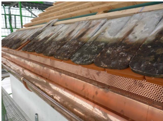
Bild 20: Dachrinne aus Kupfer mit Lochblech, Kopf- bau.
