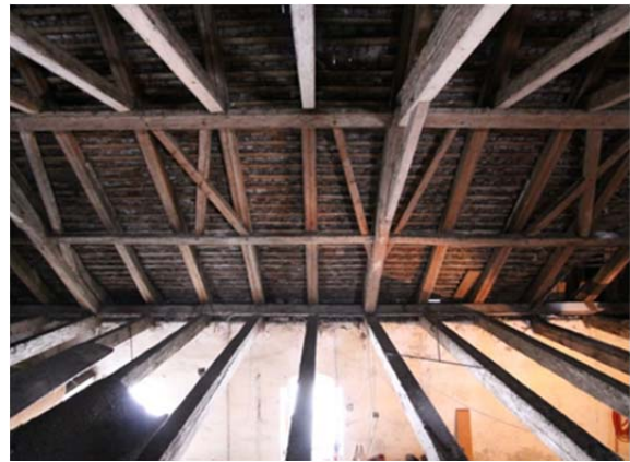
Bild 8: Dachwerk des Kopfbaus mit Andreaskreuzen (liegender Stuhl), Ansicht Nord.
