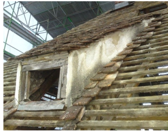
Bild 25: Bauzeitliche SchlepPGAube im Süden der Al- ten Schäfflerei.
