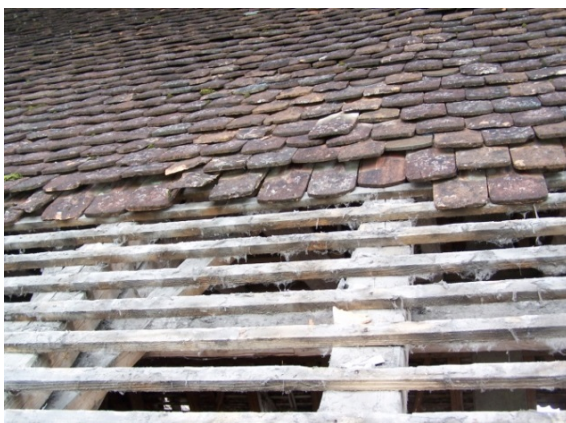
Bild 28: Originale Ziegeleindeckung und Lattung, Kopfbau der Alten Schäfflerei.
