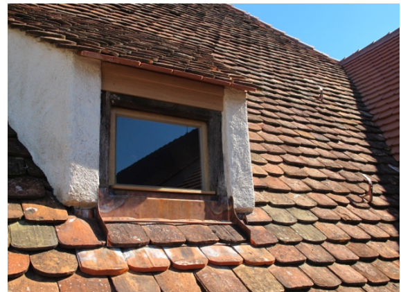
Bild 27: Rekonstruktion der SchlepPGAuben und neu- eingedecktes Dach mit originalen Kirchenbi- bern, Kopfbau der Alten Schäfflerei.
