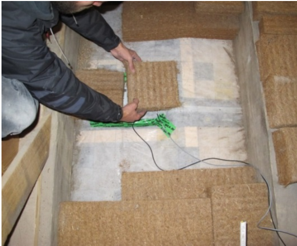
Bild 59: Einbau der Messsensorik im Bereich der ge- dämmten Zerrbalkenebene.
