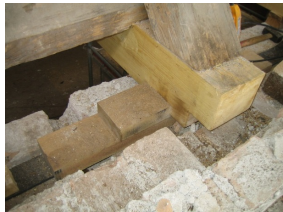
Bild 19: Neue Mauerlatte aus zweilagigem Eichenholz auf einem Elastomerauflager.
