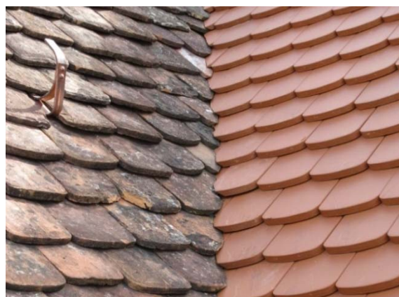
Bild 31: Kehle zwischen Kopfbau mit originalen Kir- chenbibern und Südbau mit nachgebrannten Dachziegeln.
