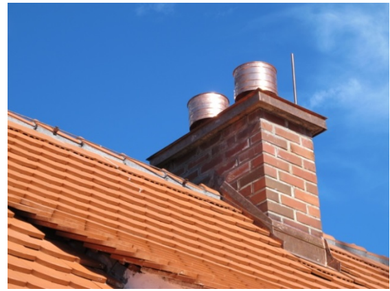
Bild 23: Blitzableiter und Kaminabschluss, Nordbau der Alten Schäfflerei.
