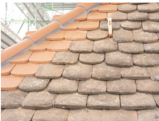
Bild 30: Kombination von originalen Kirchenbibern und nachgebranntem Ziegelmaterial, Kopf- bau.
