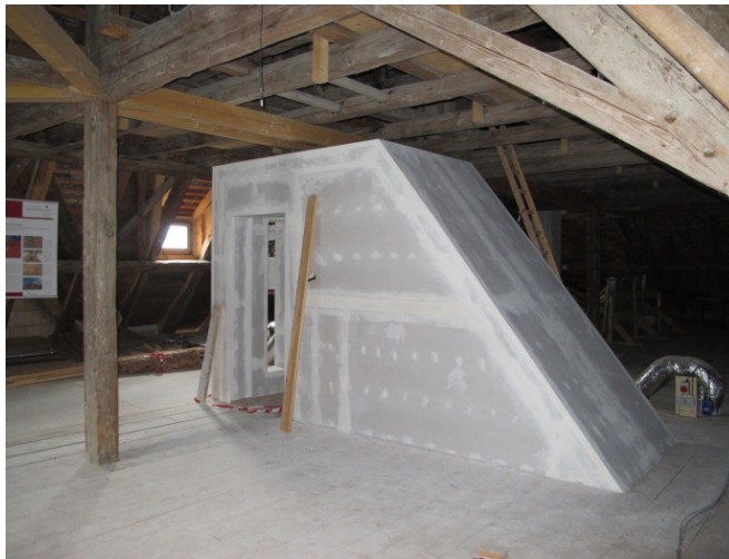
Bild 40: Fertigstellung des oberen Treppenhausabschlusses mit doppelter Gipskarton- Beplankung.
