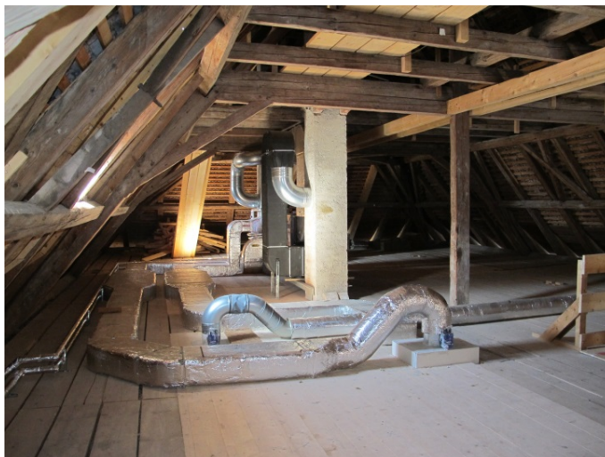
Bild 52: Nachgebesserte Kanalführung Zuluft ins Obergeschoss.
