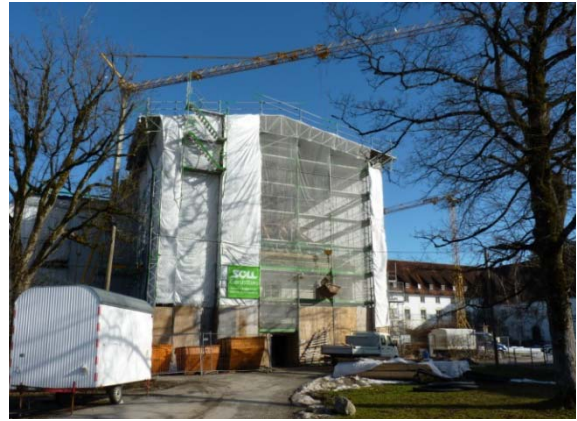
Bild 10: Schutzeinhausung im Bereich des Kopfbaus mit Baukran.
