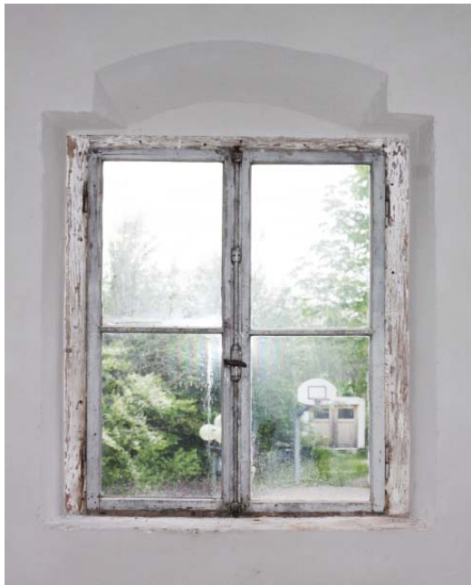
Bild 42: Holz-Einfachfenster als Referenzfenster für Untersuchungen zur energetischen Ertüchtigung von Bestandsfenstern.
