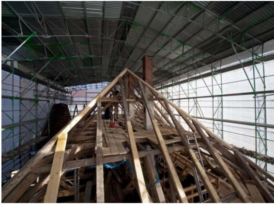
Bild 9: Abgedeckter Dachstuhl des Kopfbaus unter dem Schutzdach, Foto: Uwe Gaasch.
