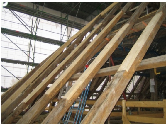
Bild 14: Querschnittsgleiche Überblattungen an der Sparrenoberseite.
