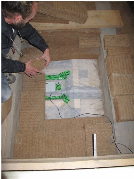
Bild 37: Installieren der Messsensoren für Temperatur, Feuchte und Wärmestrom im Deckenprofil unterhalb der Dämmung.
