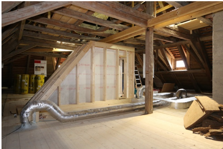
Bild 39: Holzunterkonstruktion des oberen Treppenhausabschlusses im Dachgeschoss des Kopfbaus.
