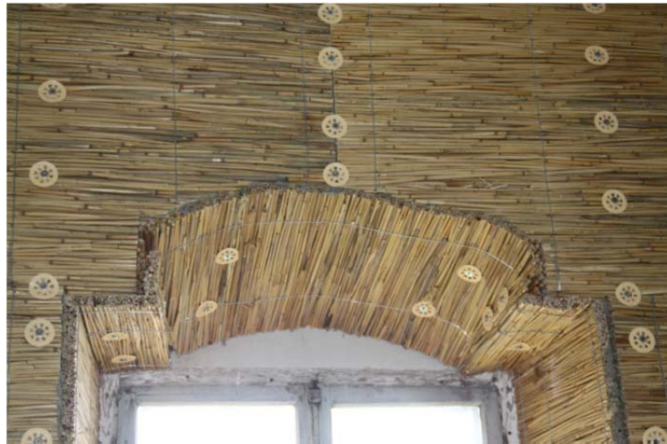
Bild 41: Anschlussarbeiten im Laibungsbereich mit unterschiedlichen Dämmmaterialien, hier Schilfrohr.
