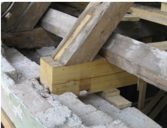
Bild 18: Überblattung des Balkenkopfs und Verzapfung des Sparrenfußpunktes.
