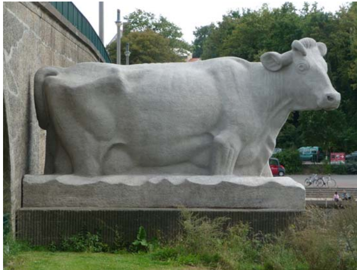
Abb. 26: Kuh Nordseite, nach den abgeschlossenen Reparaturarbeiten im Juli 2014
