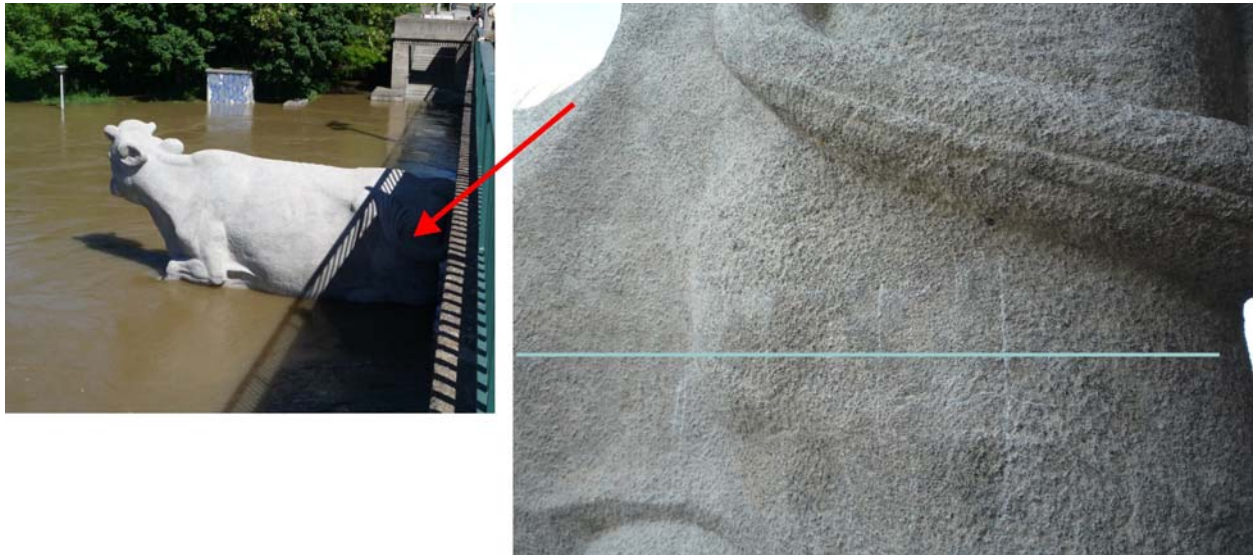
Abb. 2a: Maximaler Wasserstand der Flut und die Lage neuer Sinter, auch oberhalb des Wasserniveaus, Kuh (Süd)
