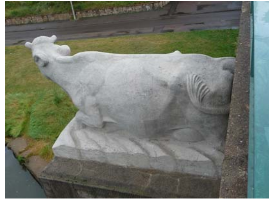
Abb. 11: Durch Regen markierte saugfähige Bereiche am Pferd (links). Die Kuh zeigt deutlich weniger entsprechende Zonen. Allerdings treten auch hier neue Sinter aus.
