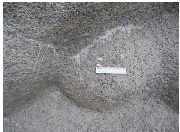
Abb. 3: Sinterfahnen in verschiedenen Bereichen am Pferd
