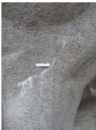
Abb. 3: Sinterfahnen in verschiedenen Bereichen am Pferd
