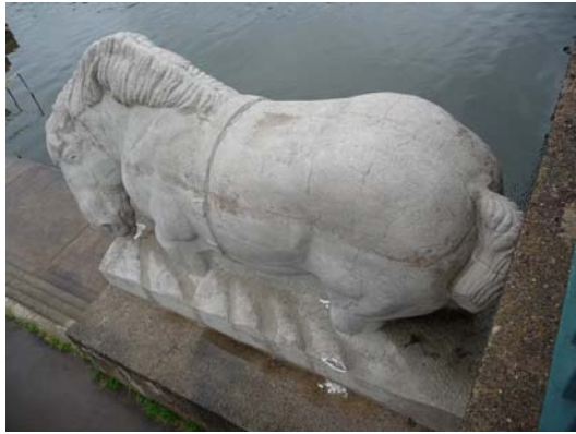
Abb. 11: Durch Regen markierte saugfähige Bereiche am Pferd (links). Die Kuh zeigt deutlich weniger entsprechende Zonen. Allerdings treten auch hier neue Sinter aus.
