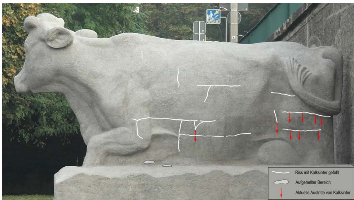
Abb. 13: Kuh, Südseite; Kartierung der Risse, die mit Kalksinter gefüllt sind und aus denen z.T. wieder neu rechts massiv Sinter ausgetreten sind.
