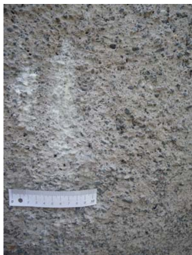
Abb. 20: Sinterfahnen, die aus kleinen Löchern in der Fläche austreten
